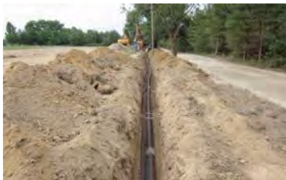
Réalisation de tranchées et pose de câbles (source : Neoen)
