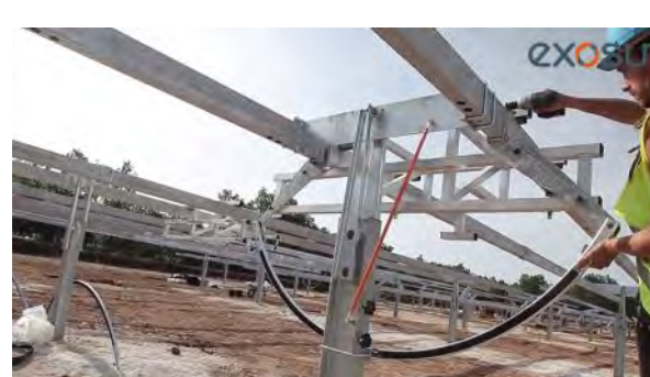
Montage arceaux (ex. de photos d'Exosun)
