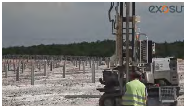
Montage des fondations (exemple de photos d'Exosun)
