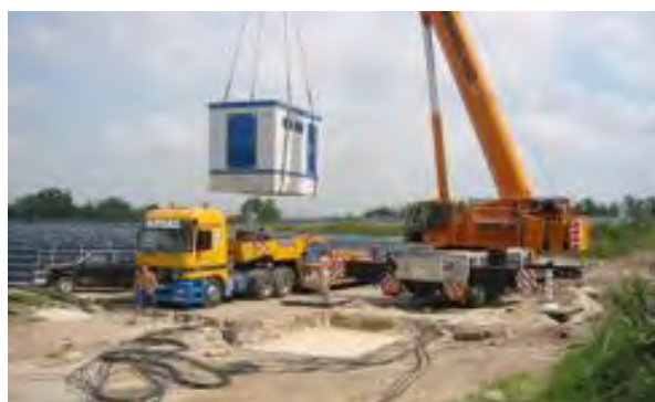
Pose des postes onduleurs (source : Neoen)
