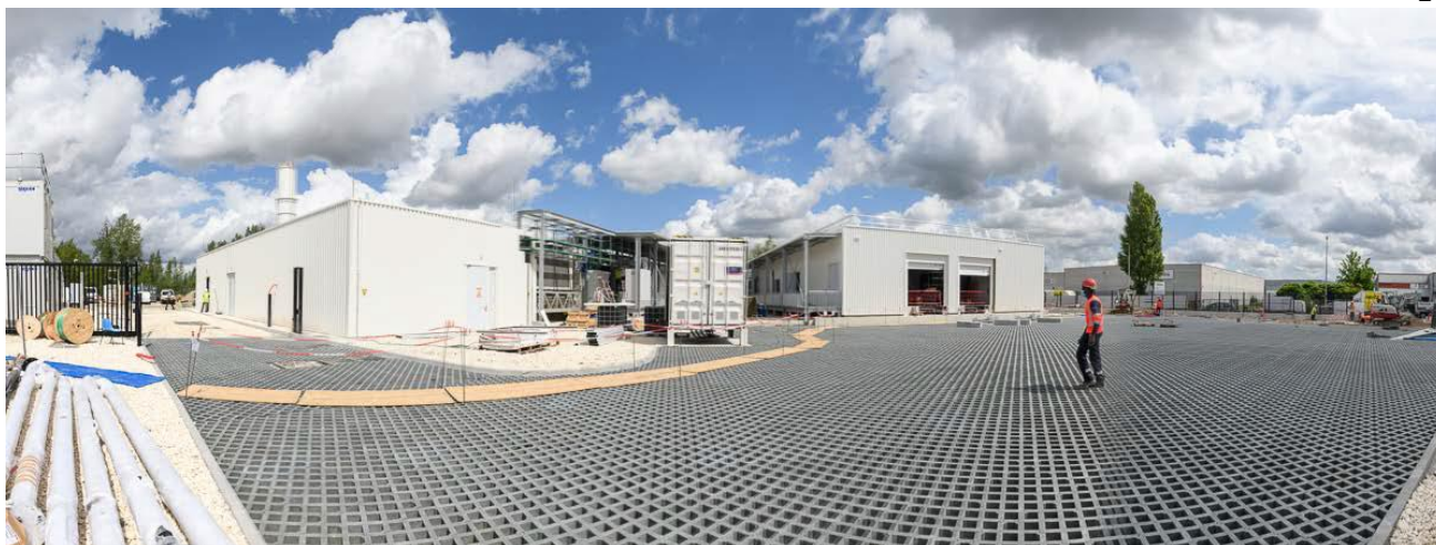
Pose de caisson alvéolaire béton sur voie d'accès avant remblaiement en graves
