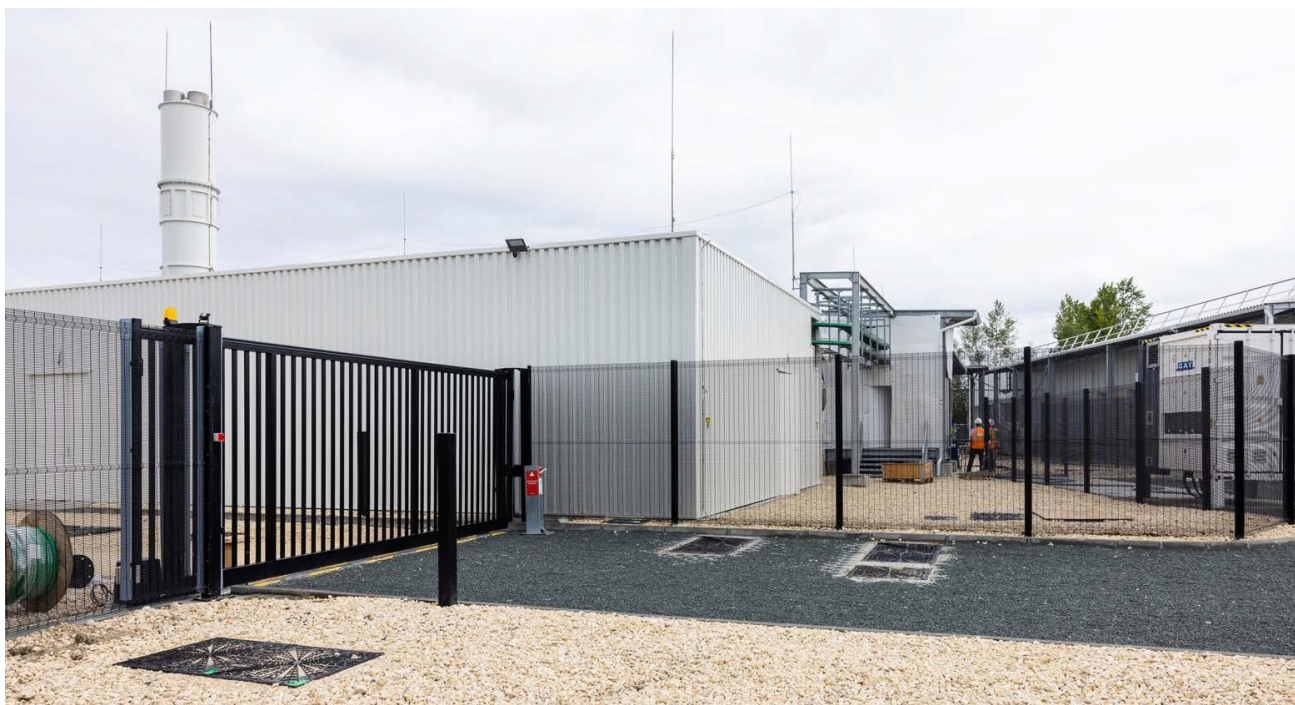
Entrée technique du site et remblaiement des caissons alvéolaires en grave
