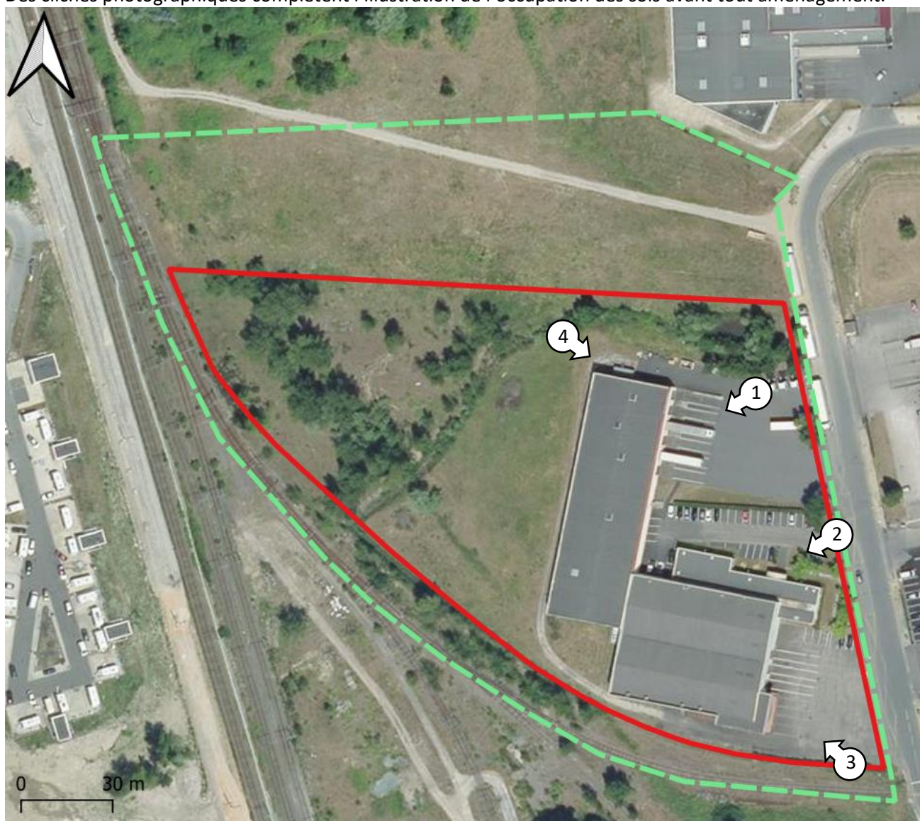
Figure 4 : Vue satellite avant travaux (période 2011-2015)
