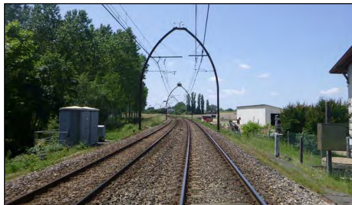
Vue de la ligne Dax-Bayonne à hauteur de Rivière-Saas-et-Gourby © ETEN Environnement
