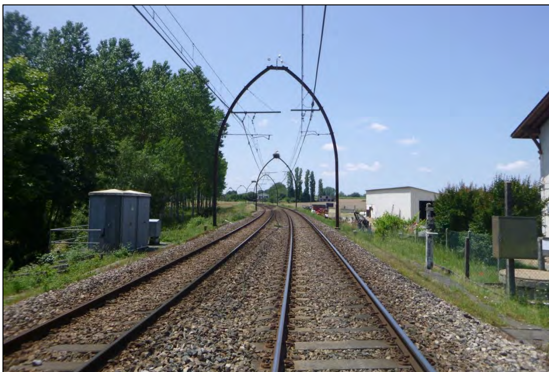
Vue sur la voie © ETEN Environnement
