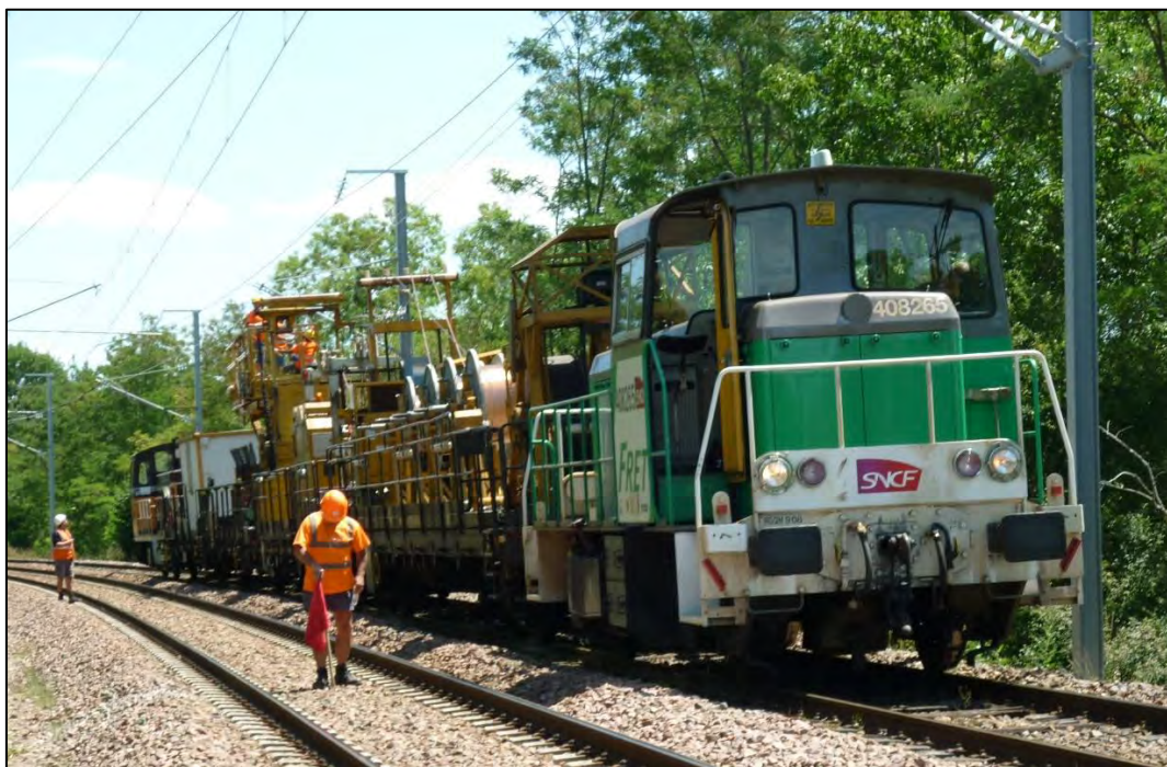
Figure 9 : Exemple de train-travaux (source SNCF Réseau)
