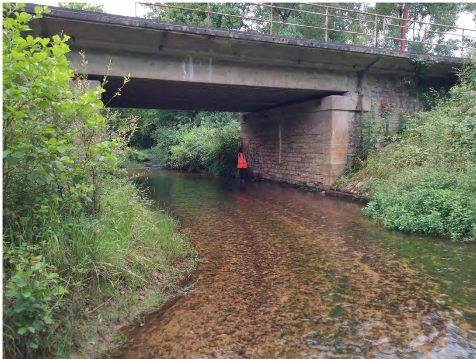
Cours d'eau passant sous la voie ferrée © ETEN Environnement
