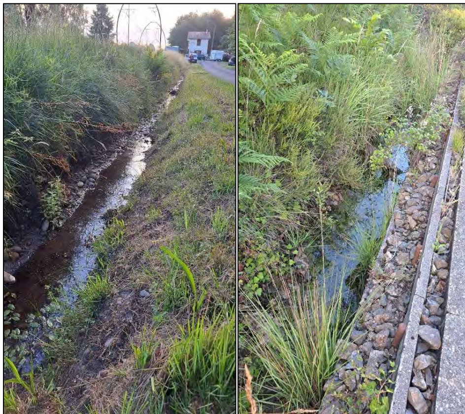
Fossé de la zone de stockage n°18 © ETEN Environnement
