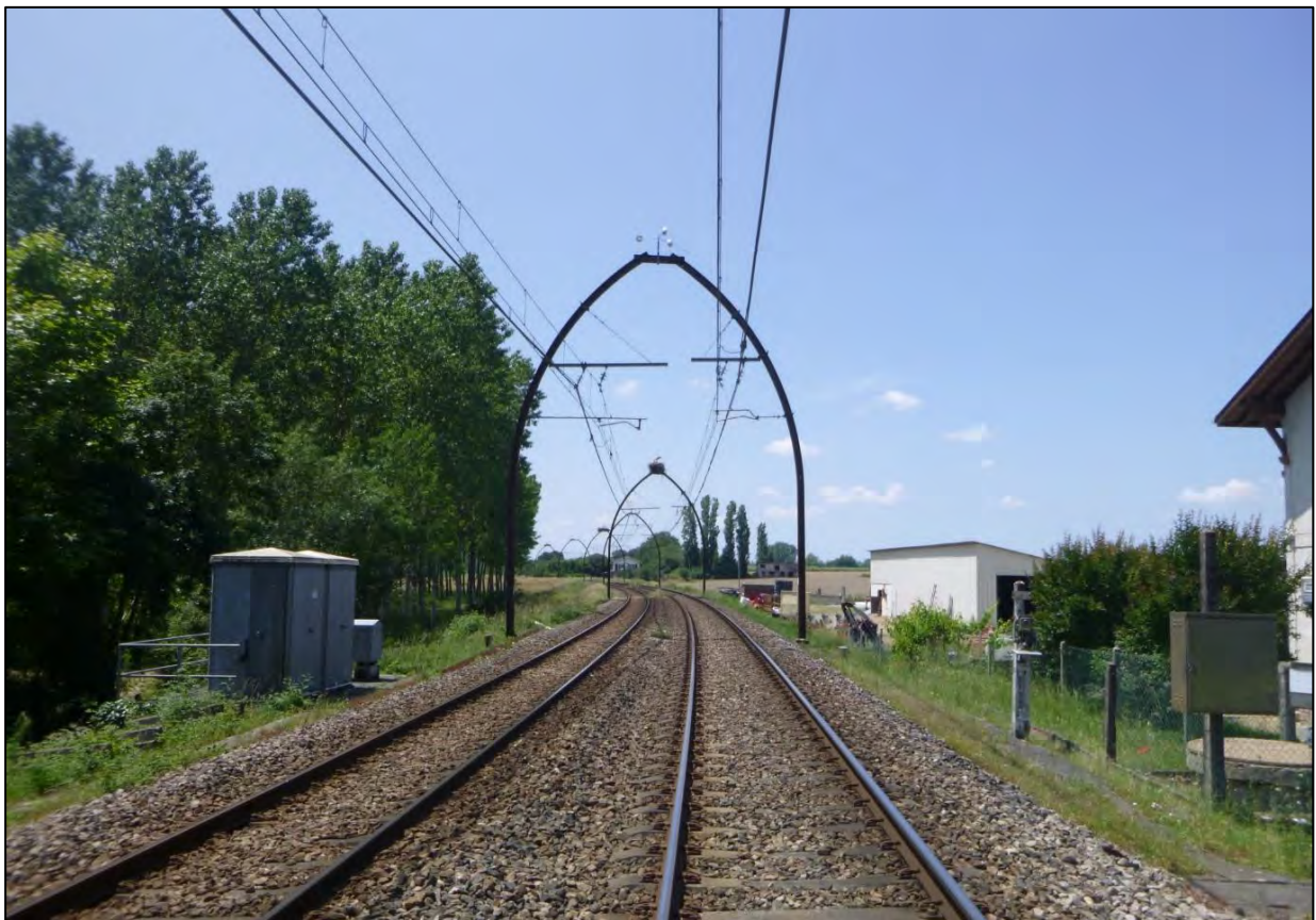
Vue de la ligne Dax-Bayonne à hauteur de Rivière-Saas-et-Gourby © ETEN Environnement
