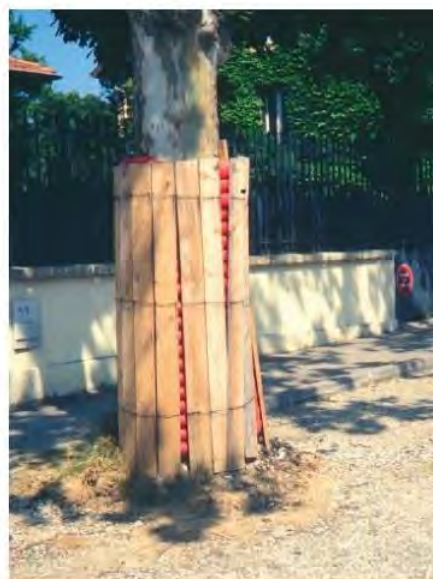
Figure 102 : Technique de protection temporaire du tronc
