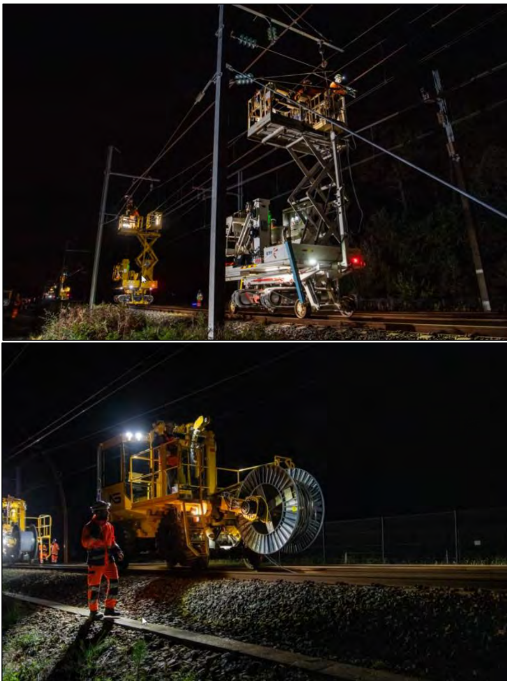
Figure 5 : Exemples de travaux de remplacement de caténaire – zone test (Source SNCF Réseau)
