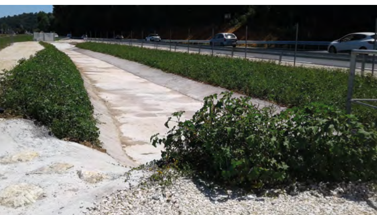
Collecte longitudinale des eaux réalisée sur la RN221 (24)
