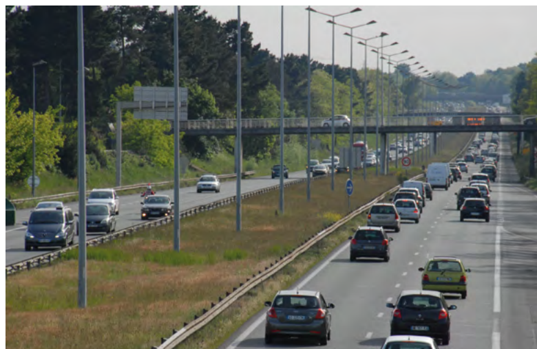
La même méthode a été appliquée pour la mise à 2x3 voies de la rocade bordelaise, qui s'achèvera mi-2023.
