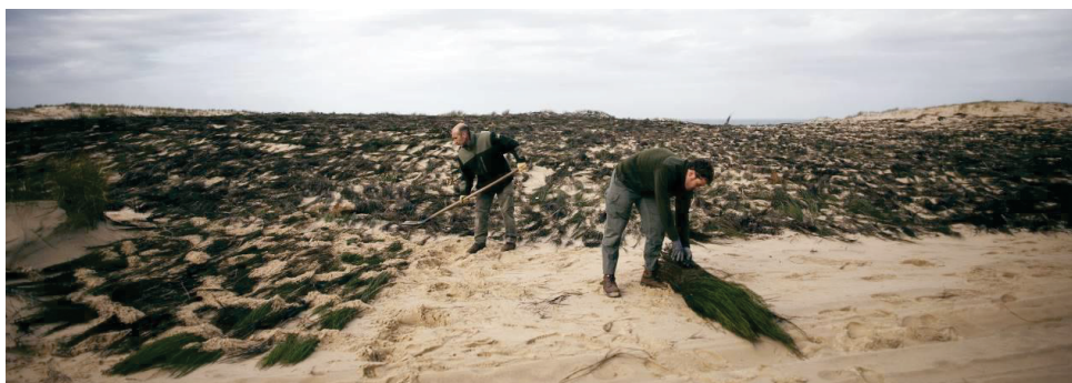
Figure 4: Pose manuelle et sablage de couvertures de genêts, (The Willis Willis / ONF)
