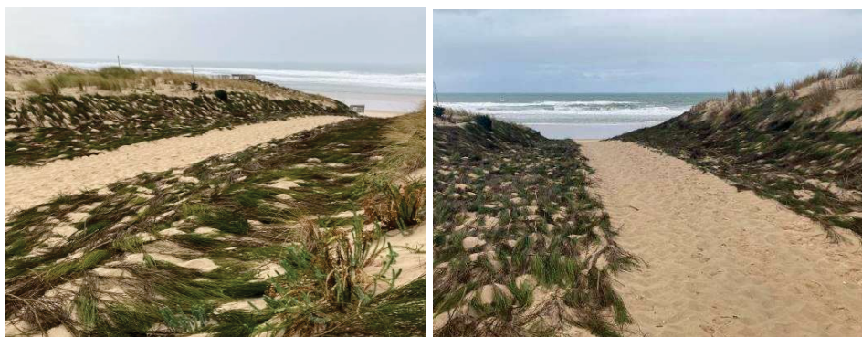
Figure 5 : Couvertures de genêt mises en place dans le cadre d'un plan plage à Lacanau (33), (L. Decrock, ONF, 2020)
