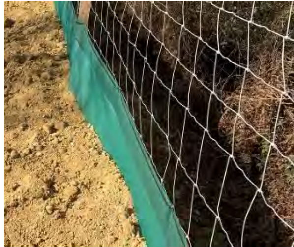
Figure 70 : Clôture grillagée agrémentée d'un filet anti-intrusion
