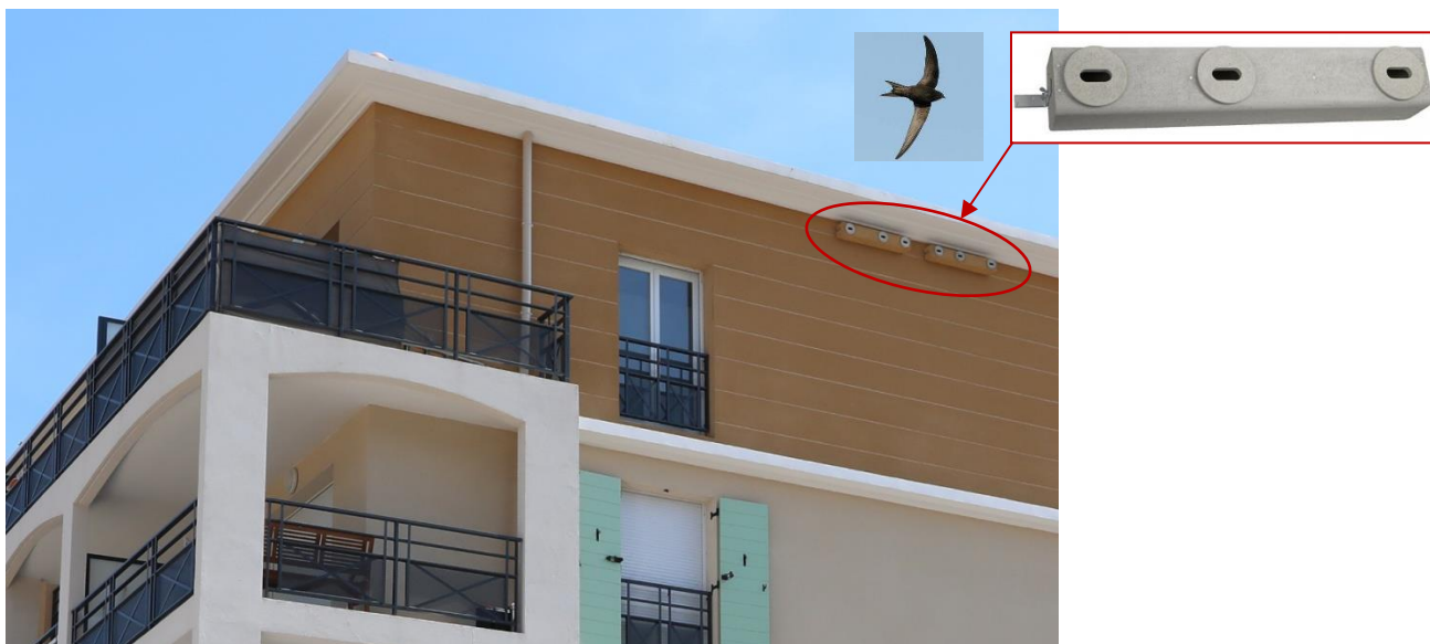
Photo 24 : Illustration de nichoirs à martinet noir installés à plus de 5 mètres de hauteur sous l'avant toit d'un bâtiment à étage Source : Laurent Perrier ; Schwegler
