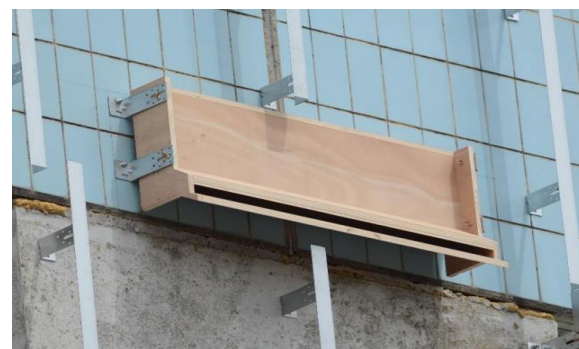
Début du chantier
