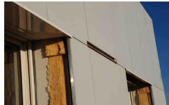
Fin du chantier
