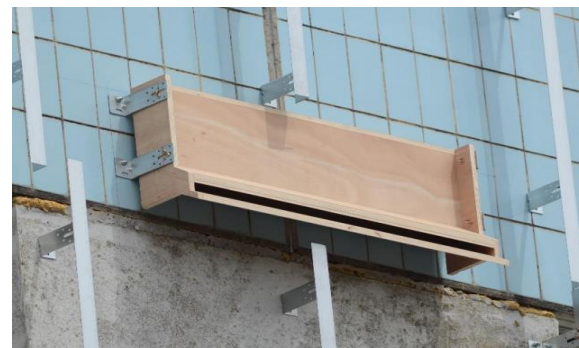
Gîte encastré en cours de pose
