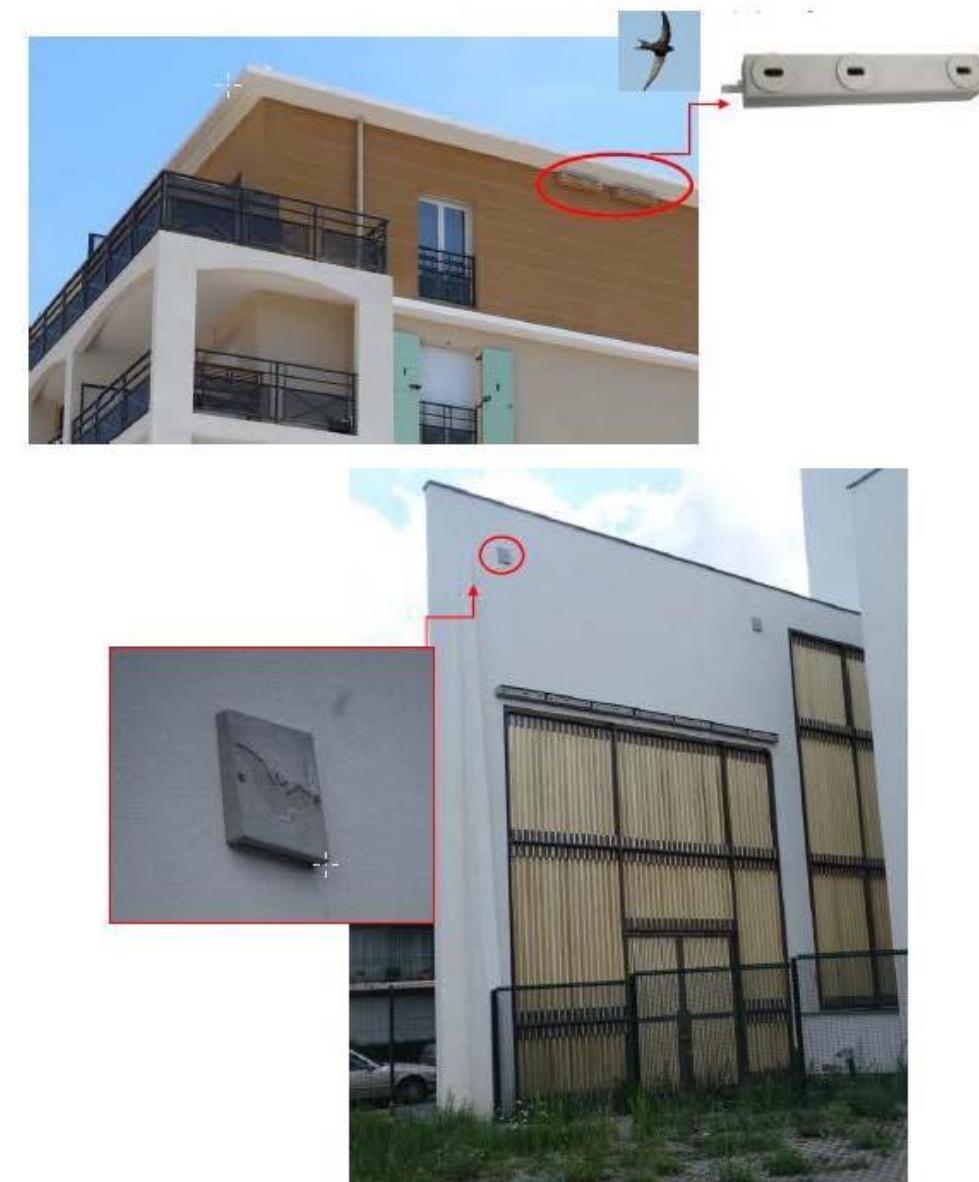
Figure 2 : Illustration de pose de nichoirs à Martinet noir et de gîtes à chiroptères sur une façade d'un bâtiment (sources : Martine Wauters ; Schwegler)
