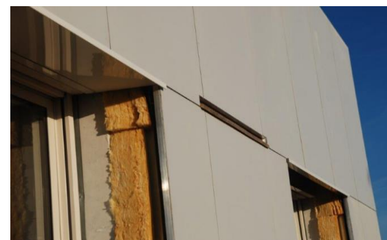
Gîte en fin de chantier
