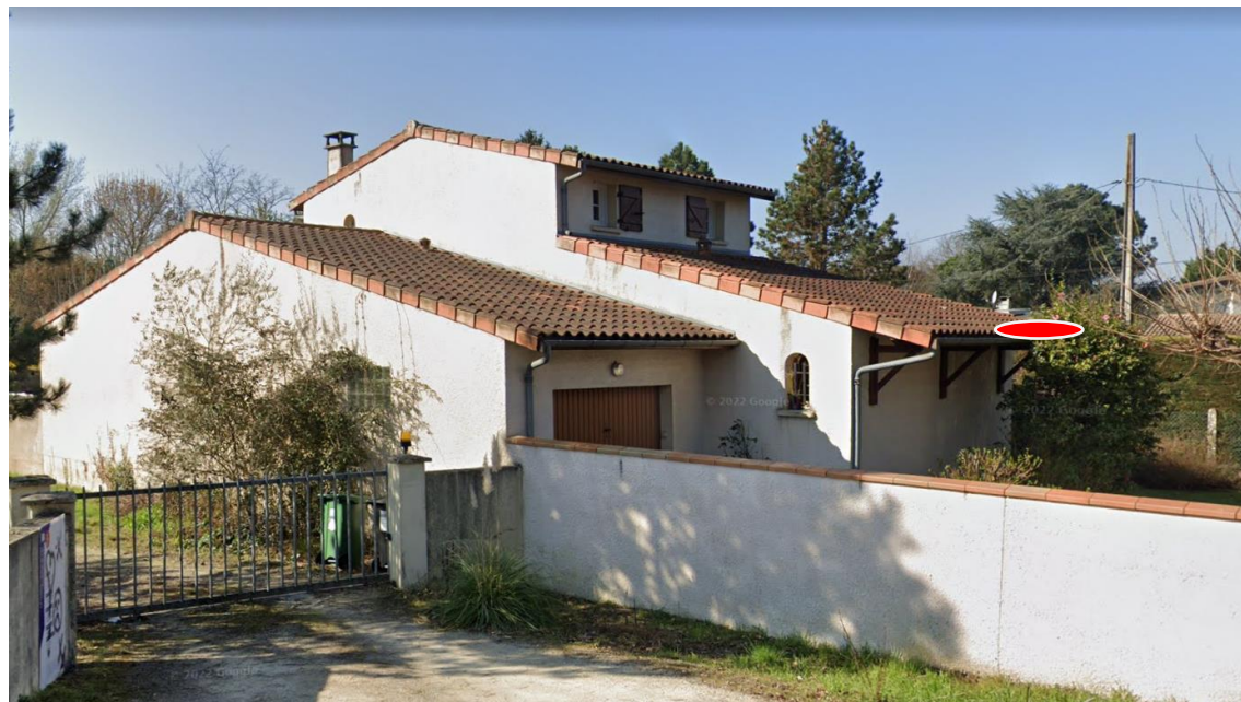
Photo 14 : Bâtiment est pour lequel 4 chauves-souris (type pipistrelles) ont été observées en sortie de gîte au crépuscule
