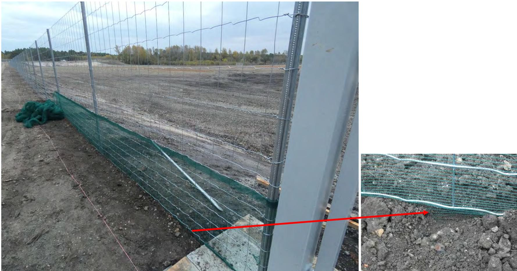
*Photo 3 : Exemple d'une barrière à batraciens en cours d'installation sur un chantier*
