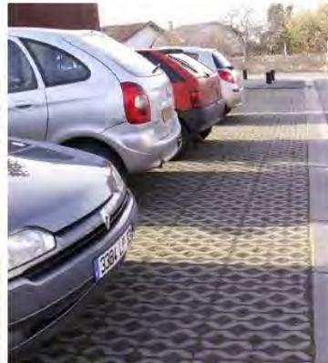
> Dalles béton gazon ou grilles béton gazons
