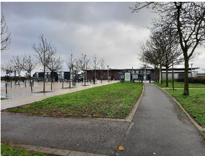
Figure 17 : Parvis de la gare - photo EPA Sénart
