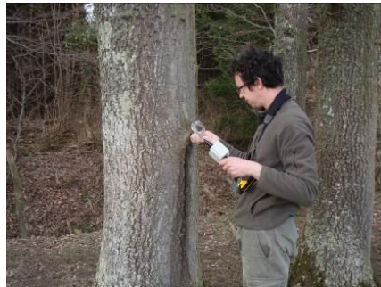
Exemple d'une inspection des cavités à l'aide d'un endoscope (hors aire d'étude -© BIOTOPE)
