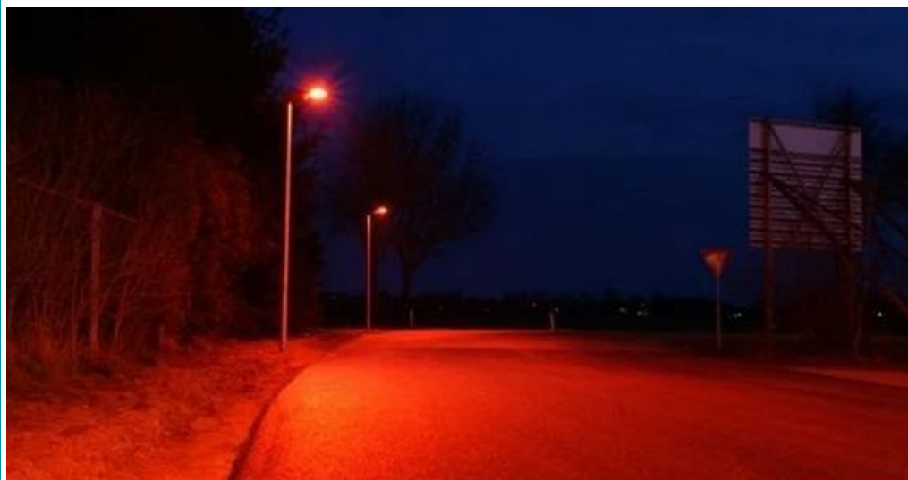
Figure 63 : exemple de luminaires à Led "bat-friendly"
