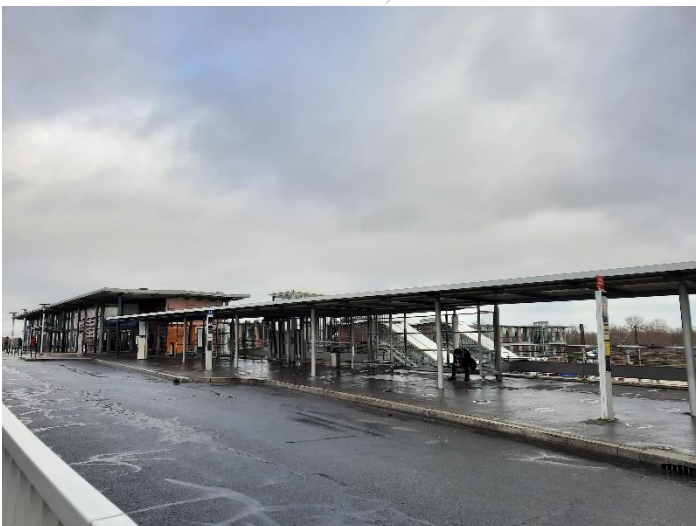
Figure 18 : Aménagements de la gare RER – photo EPA Sénart
