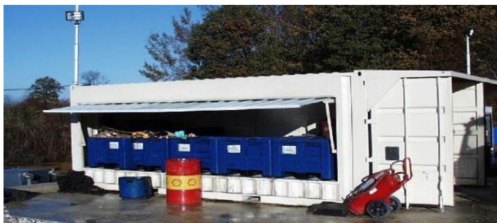
Figure 62. Tri sélectif des déchets de chantier
