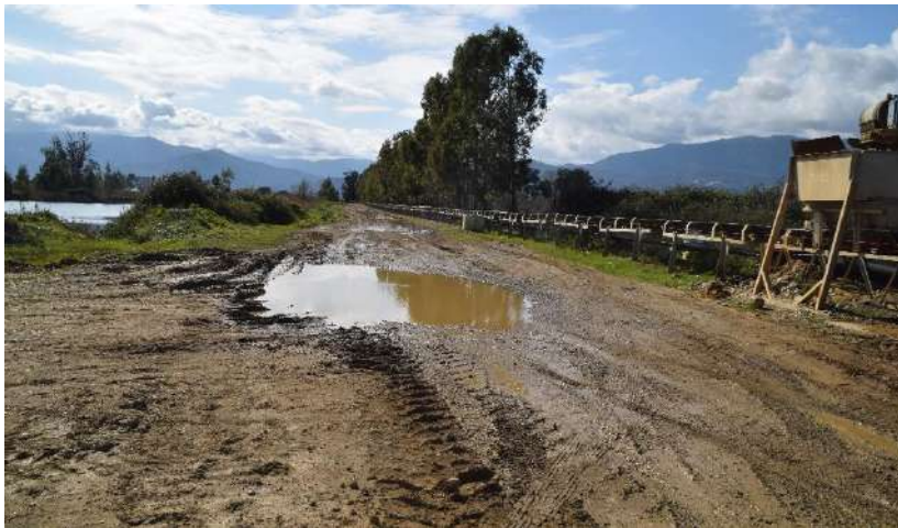
Figure 10 : Vue sur l'une des pistes présentes au sein de l'emprise du projet
