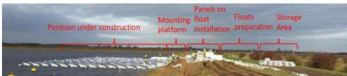
Figure 13 : Exemple d'une zone d'assemblage sur berge
