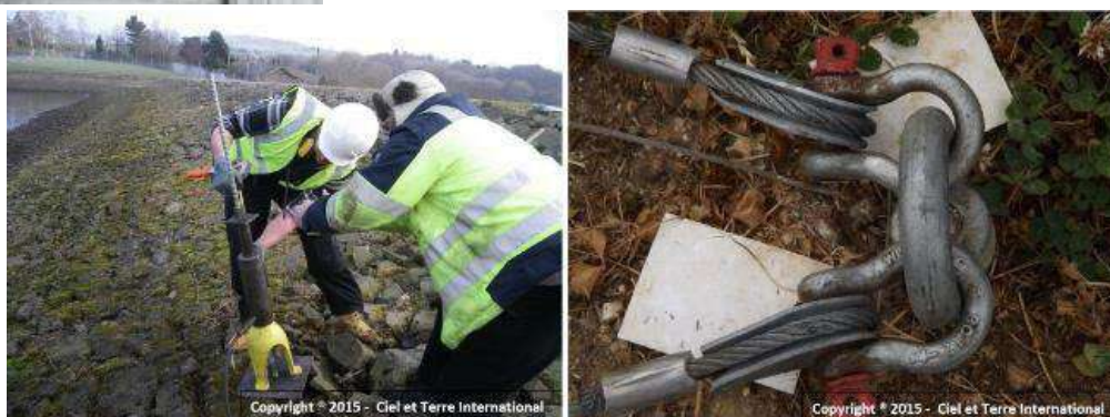
Ancrage sur berges (utilisation d'un vérin hydraulique pour l'installation de l'ancre et raccordement de la chaîne d'ancrage au travers de deux manilles)
