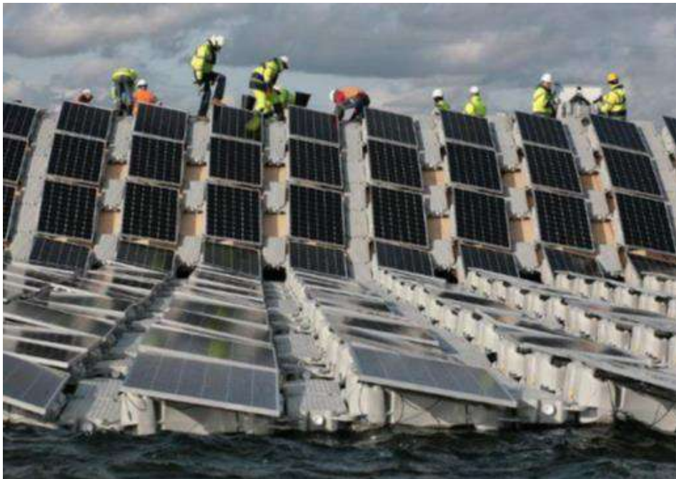
Figure 7 : Exemple de montage et de mise à l'eau des structures
