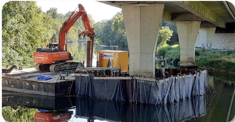
Des visites subaquatiques sur l'ouvrage aval du PH2 d'Angoulême, qui franchit la Charente, avaient permis de constater un affouillement sous une des piles en fondation superficielle dans le fleuve. Des études géotechniques et hydrauliques ont donc été menées afin de lancer les travaux de renforcement de la pile en 2023.
