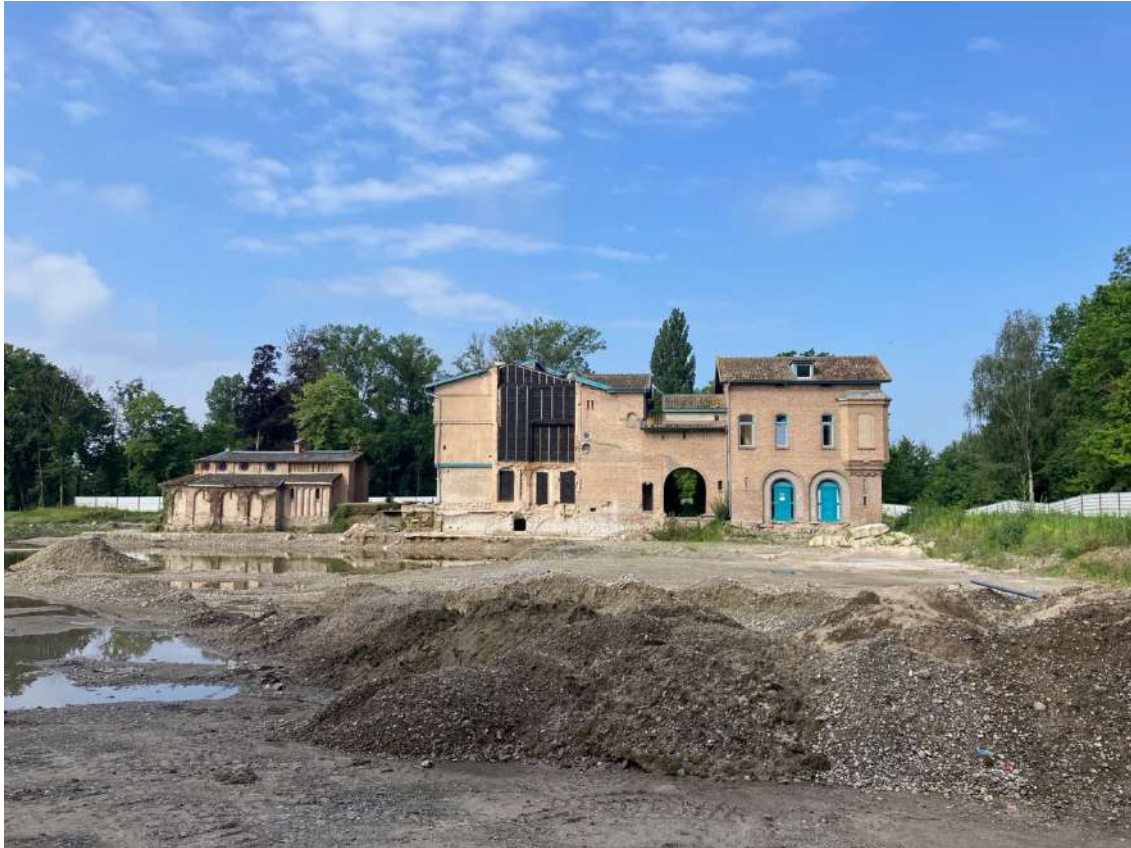
Illustration 32 : Vue du château et de la chapelle après les travaux de démolition, façade Est – Source ARCHIMED Environnement
