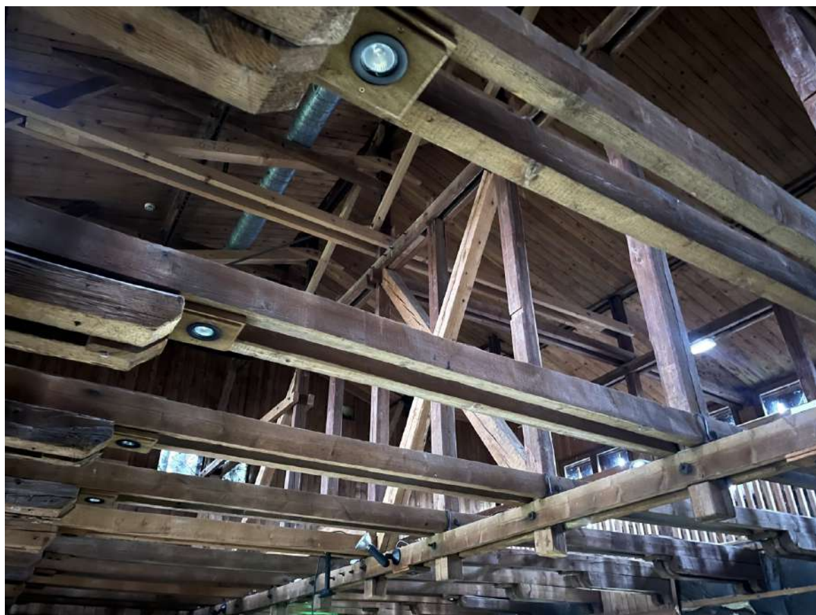
Illustration 36 : Vue de l'intérieur des combles du bâtiment du restaurant - Source ARCHIMED Environnement
