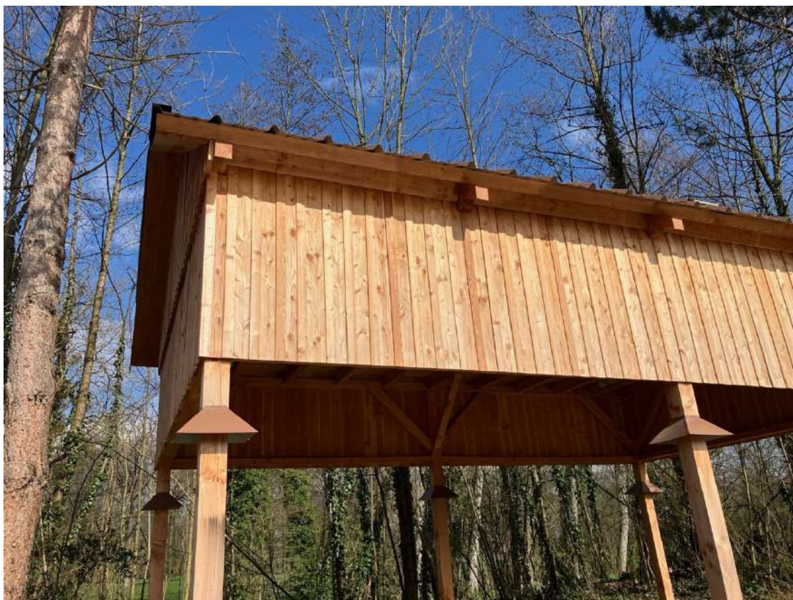
Illustration 44 : Vue sur le préau à hirondelle – Source ARCHIMED Environnement
