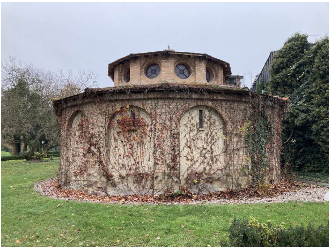
Illustration 31 : Vue de l'arrière de la chapelle – Source ARCHIMED Environnement
