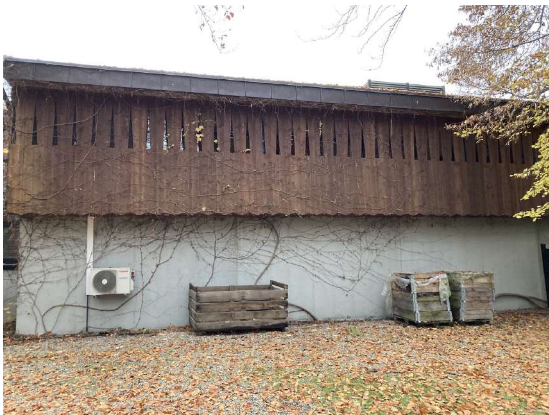
Illustration 41 : Vue d'une des façades du bâtiment de la réception- Source ARCHIMED Environnement
