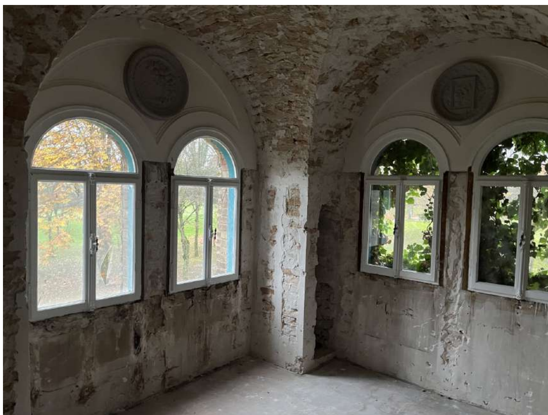
Illustration 21 : Vue de l'intérieur d'une pièce au premier étage – Source ARCHIMED Environnement
