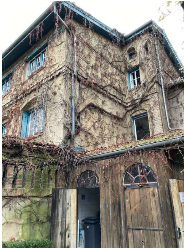
Illustration 28 : Vue de la façade Sud du château avant travaux – Source ARCHIMED Environnement
