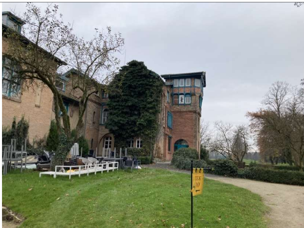
Illustration 4 : Vue vers la façade Sud-Ouest du château - Fig. 2 en date du 06/12/2022
