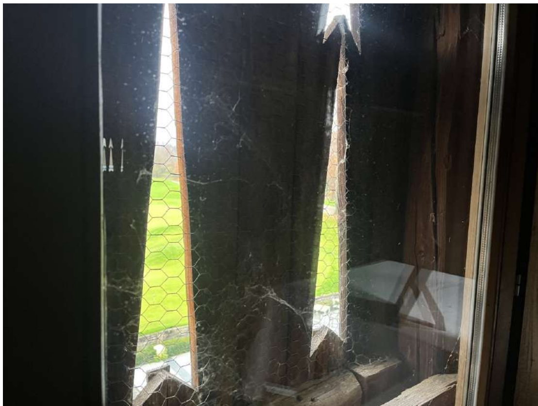
Illustration 37 : Vue de l'intérieur des fenêtres du bâtiment du restaurant - Source ARCHIMED Environnement
