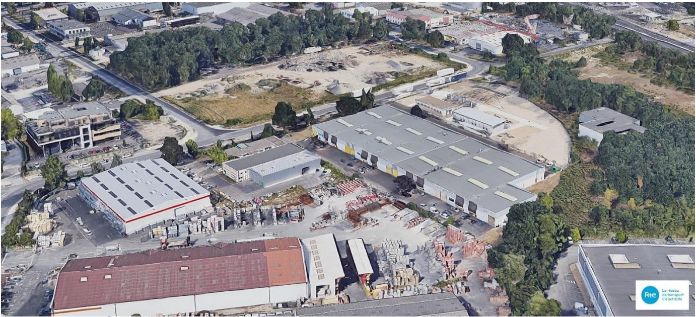
Figure 25 : Vue 3 D du site d’implantation dans son état actuel (printemps 2024)
