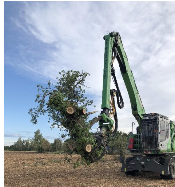
Figure 53 : Manipulation d'un tronçon d'arbre gîte potentiel afin de limiter les impacts sur les Chiroptères arboricoles Source : Egis
