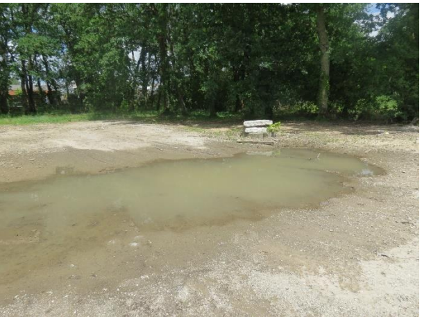
Figure 50 : Une situation à éviter, l'apparition de zones de stagnation d'eau sur le chantier au cours du printemps Source : Egis, 2024
