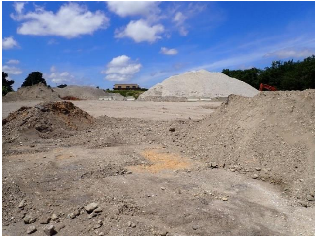
Zone de travaux, EGIS, 06/2024
