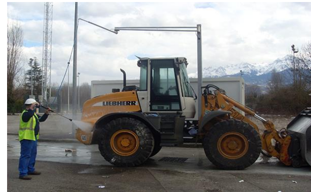
Figure 49 : Nettoyage au jet haute pression d'un engin de chantier Source : www.hp-concept.fr
