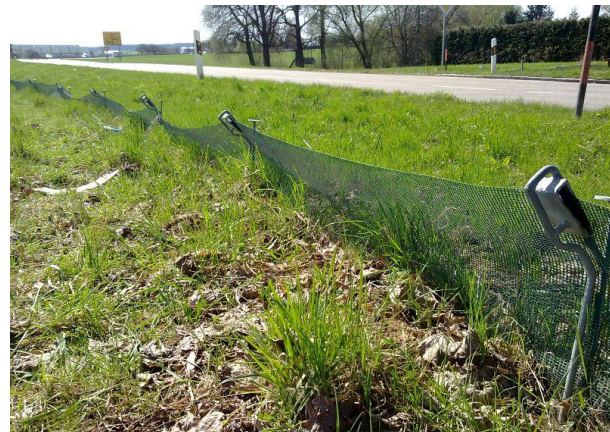
Figure 46 : Clôture « barrière à amphibiens » La bâche est inclinée de façon de permettre aux amphibiens de s'éloigner du danger (ici une route) en l'escaladant, sans possibilité de retour. Source : www.maibach-aus.at
