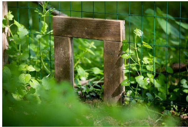
Figure 51 : Exemple de passage à petite faune aménagé dans un grillage
