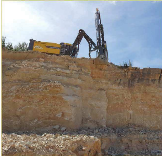
Foreuse utilisée pour la réalisation des trous de mine
