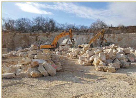
Redimensionnement des blocs d'enrochements à l'aide d'une pelle équipé d'un brise-roche hydraulique
