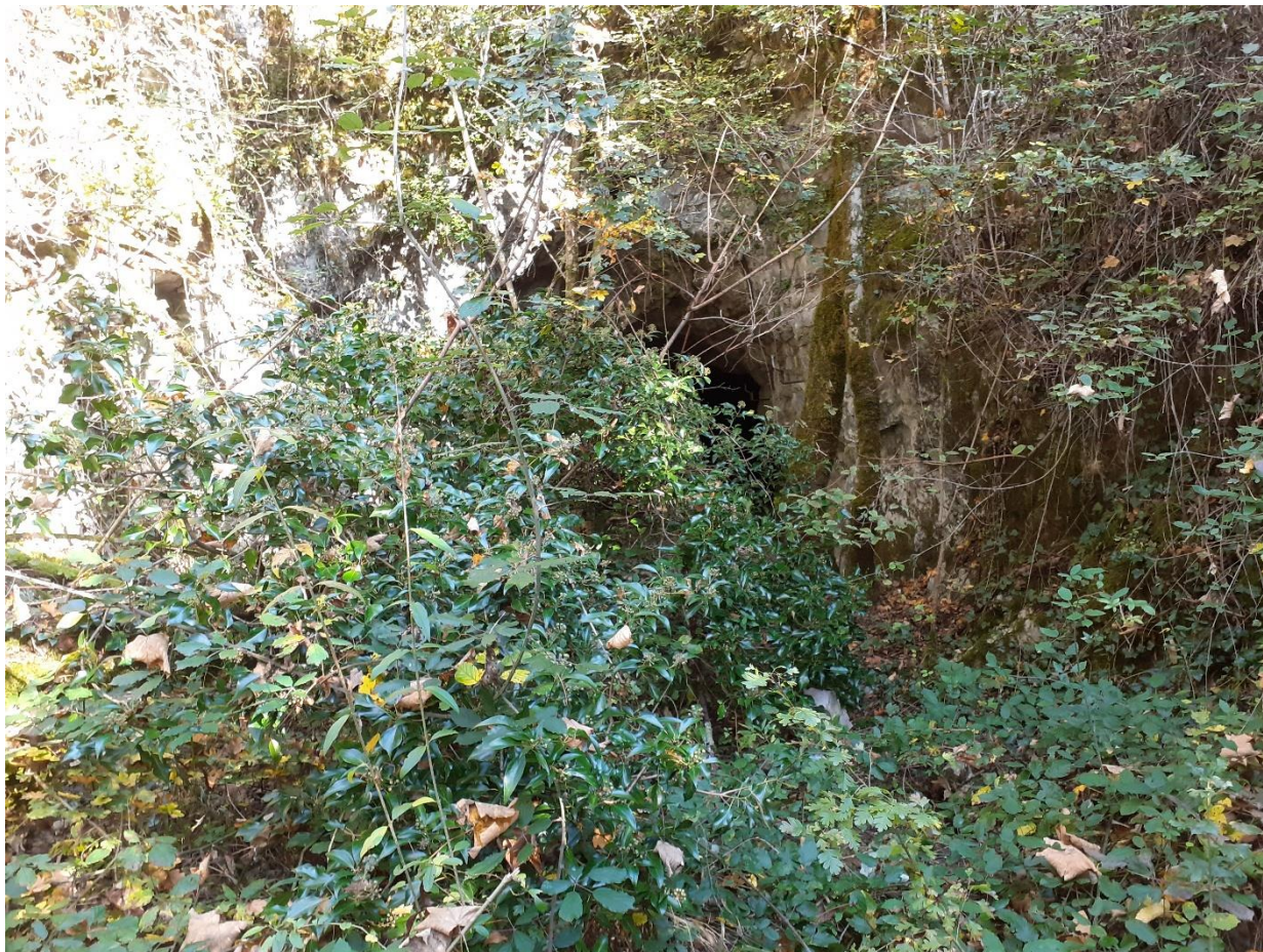
Figure 51. Galerie de la Sabla : vue extérieure de l'accès à condamner
