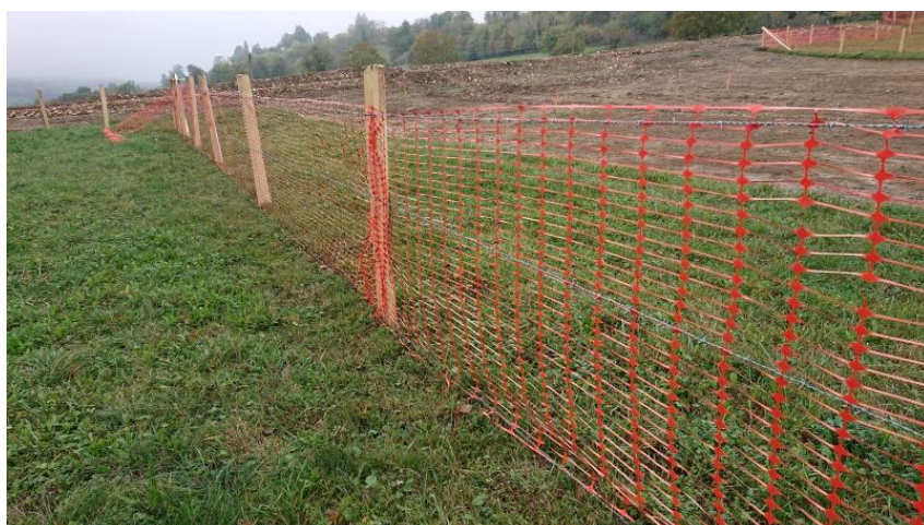
Figure 42. Délimitation d'un chantier à l'aide de piquets bois et grillage avertisseur
