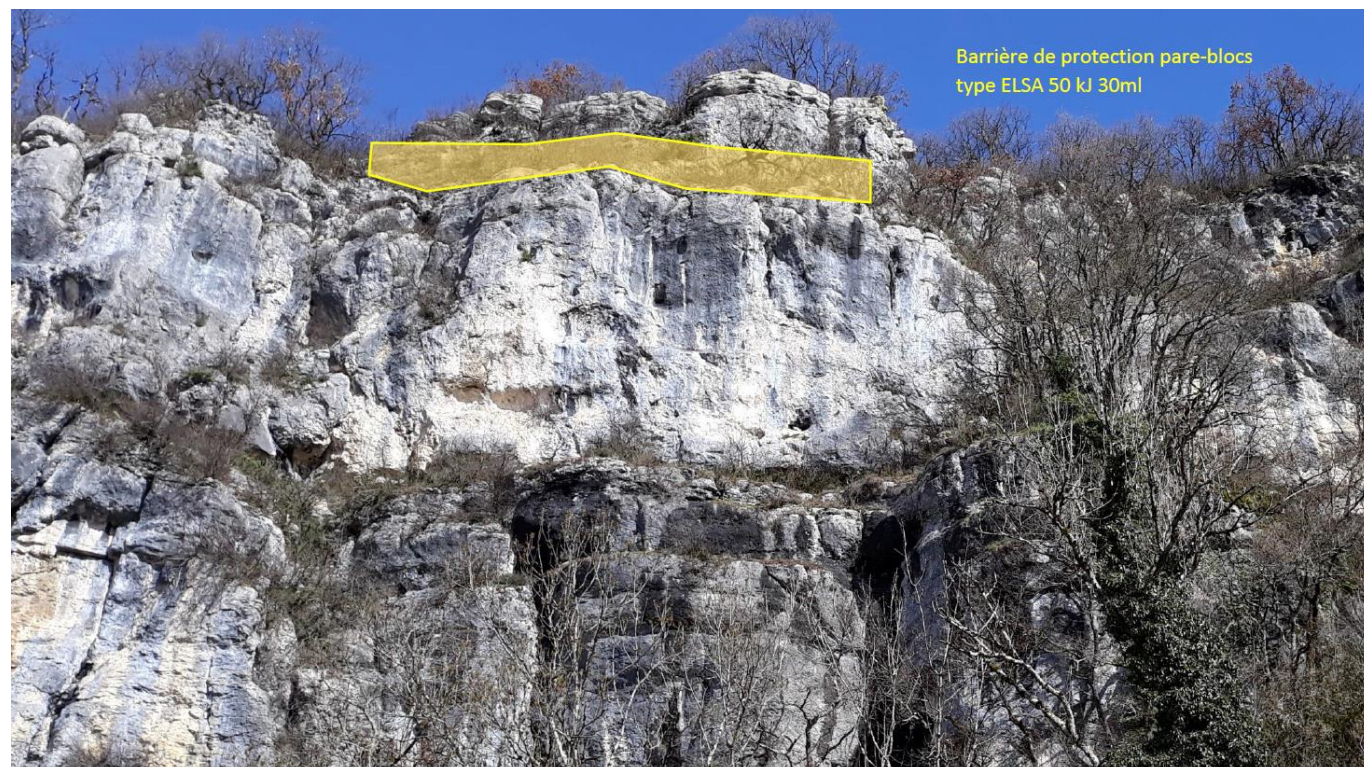
Figure 8. Schéma d'implantation d'une barrière pare-blocs en tête de falaise, zone C - CAN 2020
