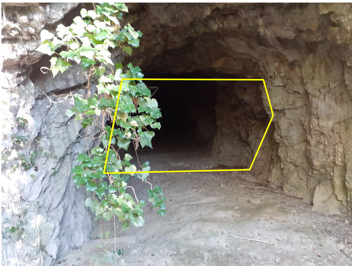
Figure 52. Galerie de la Sabla : vue rapprochée de l'accès à condamner, emplacement présumé de l'ouvrage
