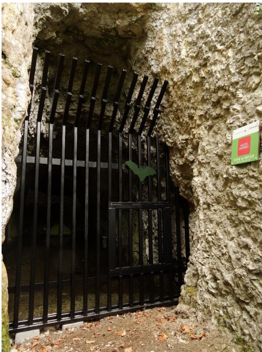
Figure 53. Exemple d'accès condamné aménagé pour le Minioptère de Schreibers , RNR de la galerie du Pont des Pierres - Photo R. Letscher
