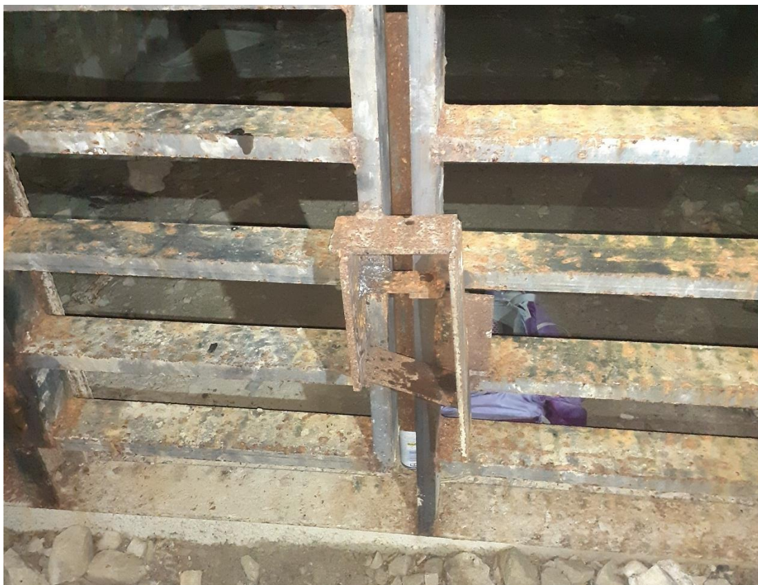
Figure 49. Mine de Saint-Champ : exemple d'accès condamné (accès inférieur), dispositif de verrouillage anti-vandalisme
