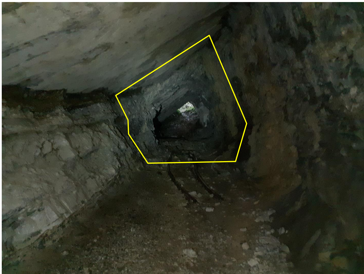
Figure 47. Mine de Saint-Champ : vue intérieure de l'accès à condamner, emplacement présumé de l'ouvrage
