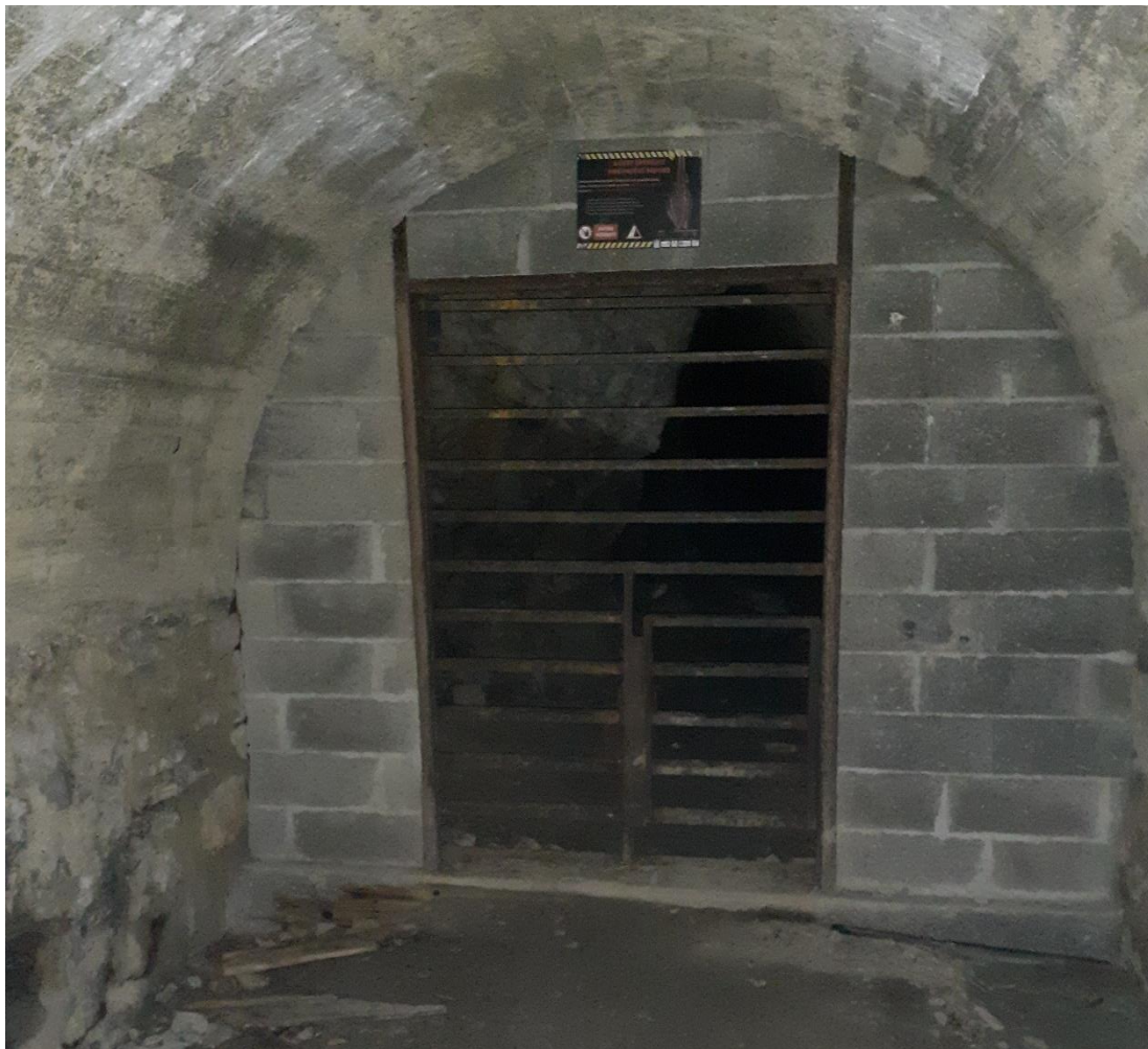
Figure 48. Mine de Saint-Champ : exemple d'accès condamné (accès inférieur) : vue générale
