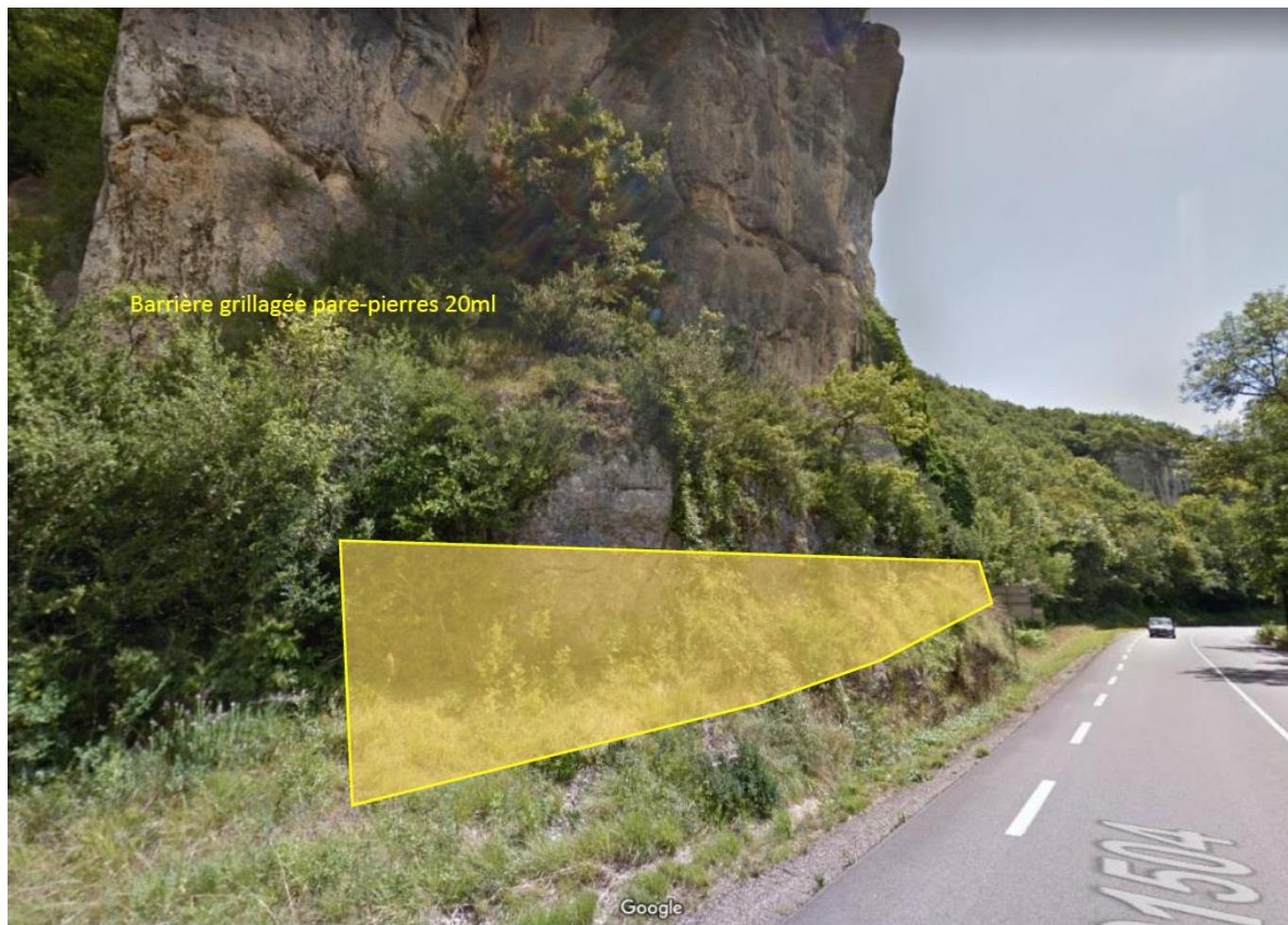
Figure 5. Schéma d'implantation d'une barrière pare-pierre en pied de falaise, zone A - CAN 2020
