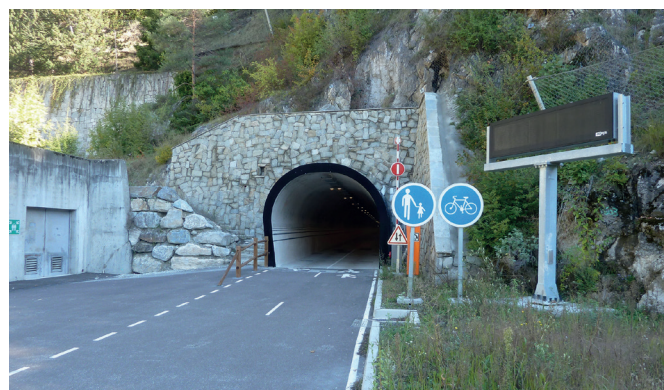
Entrée ouest de la galerie de sécurité côté Moutiers (© DIR Centre-Est)
