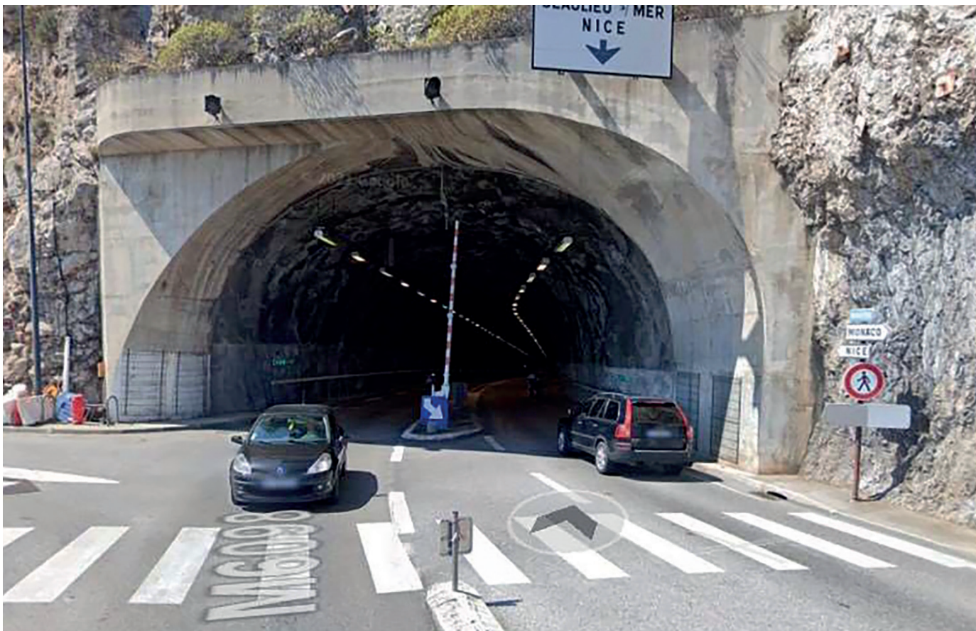
Tête est du tunnel de Cap Estel (© Nice Métropole)
