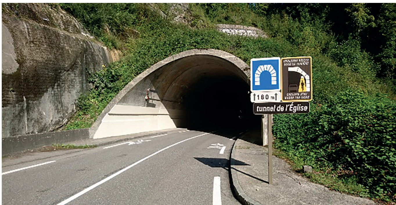
Tunnel du pont de l'Église (© CETU)
