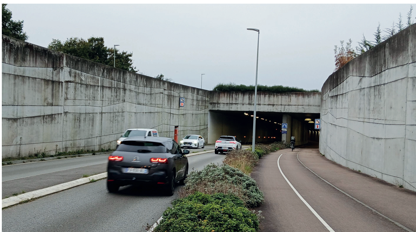
Tête est du tunnel de Kérino (© Cerema)
