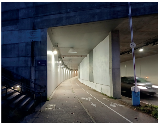
Espace dédié aux modes actifs du tunnel de Kérino (© Cerema)
