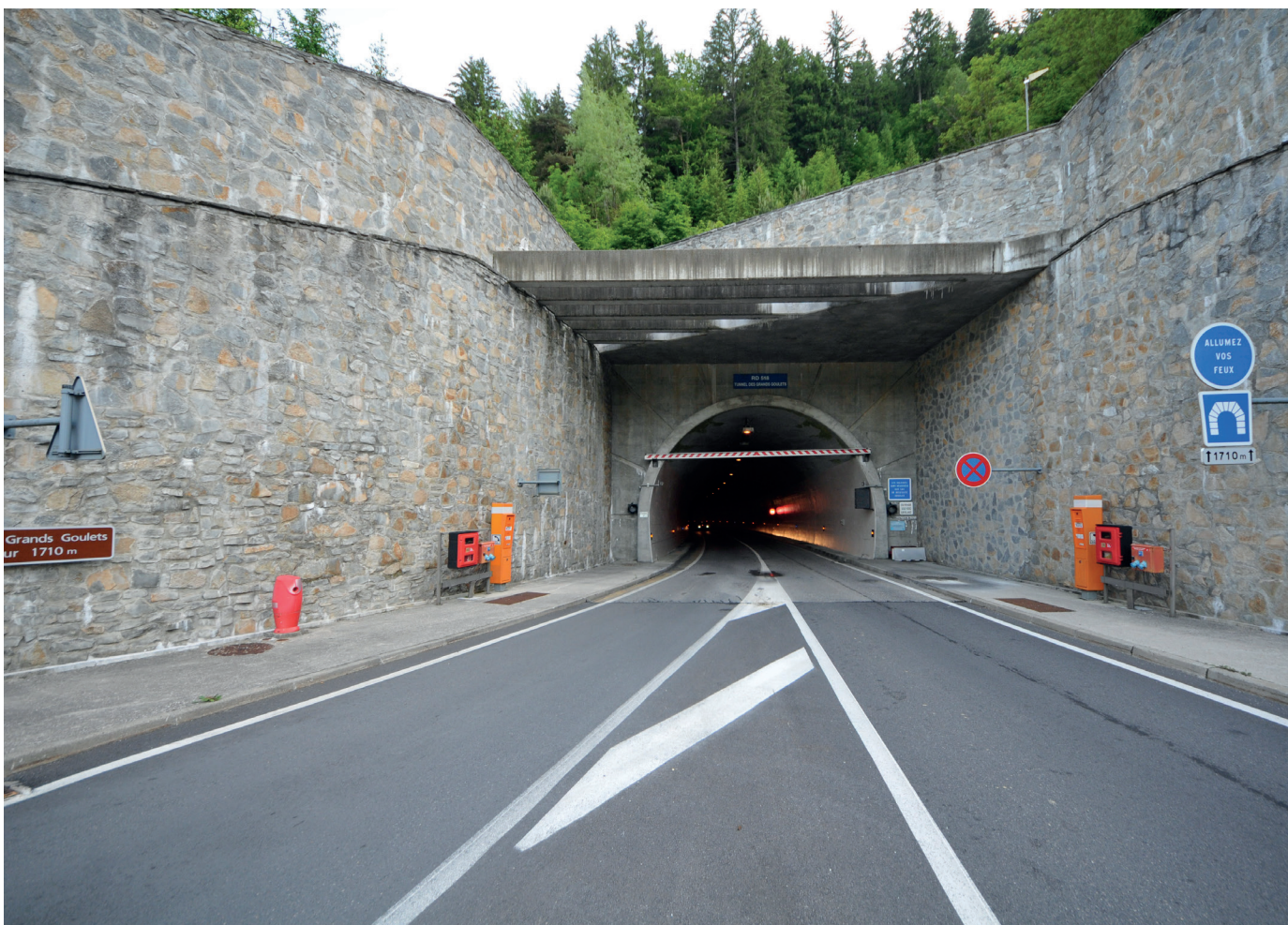
Tête sud du tunnel des Grands Goulets (© CD26)
