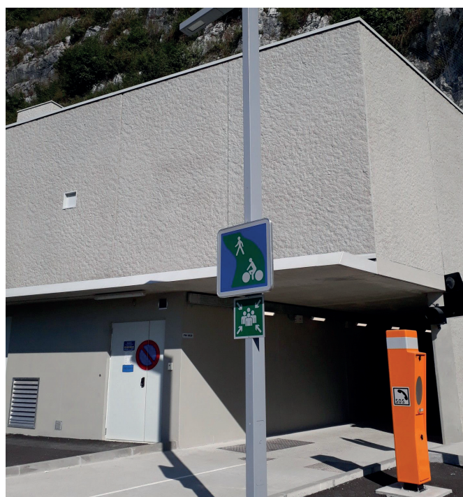
Entrée galerie côté Yenne à l'ouest à 32 m du tunnel routier (© CD73)
