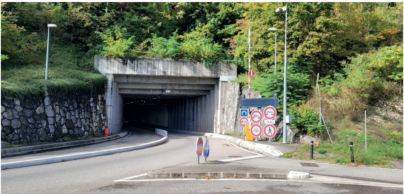
Entrée tunnel routier côté Bourdeau (© CETU)
