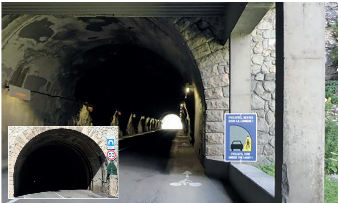
Tunnel du Villaret-du-Nial – Tête sud (© CD73)
