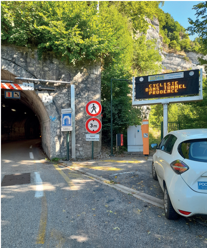
Message de présence cycliste dans le tunnel de Saint-Pancrasse (© CD38)
