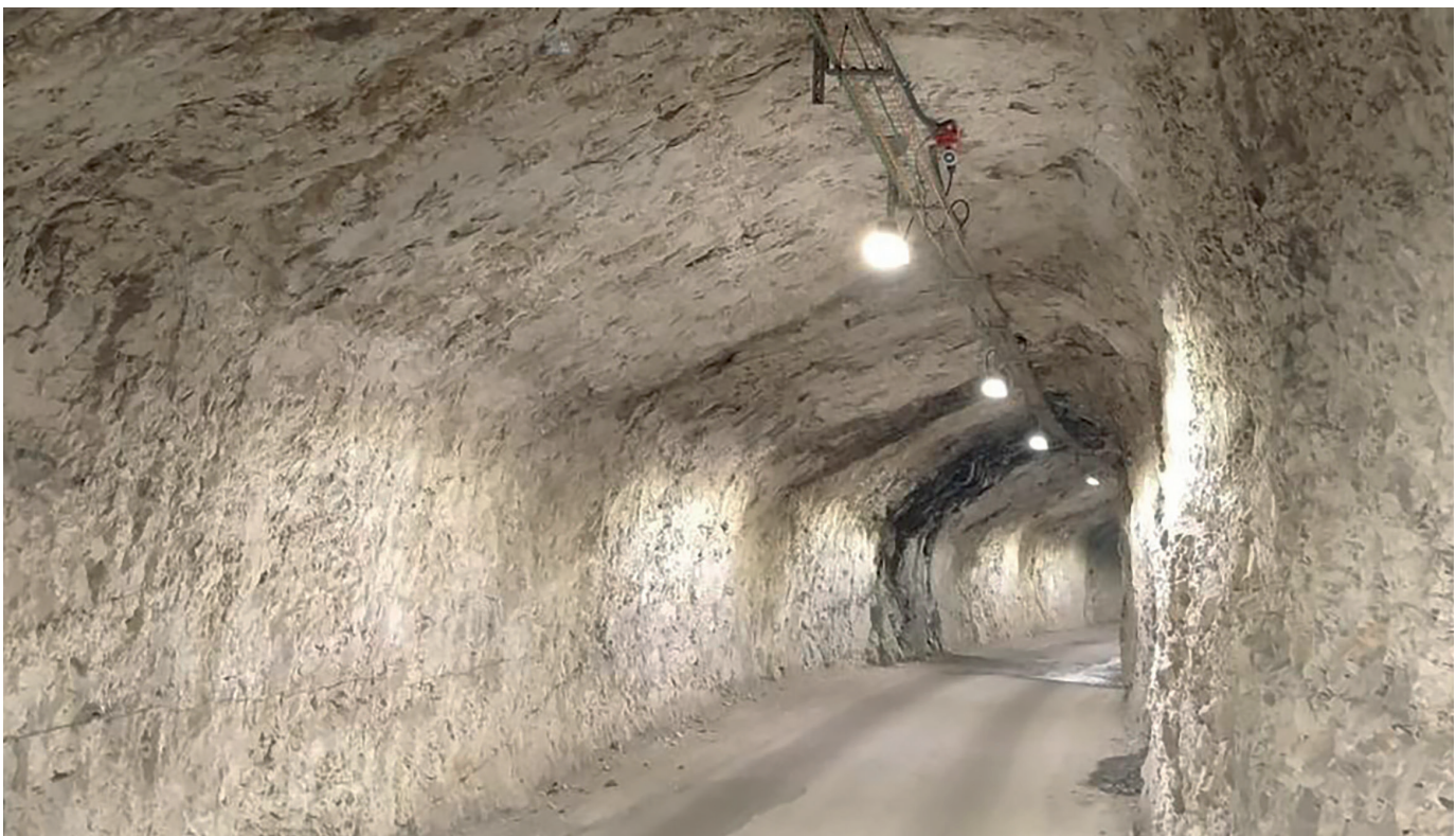
Intérieur du tunnel des Écouges après travaux (© CETU)
