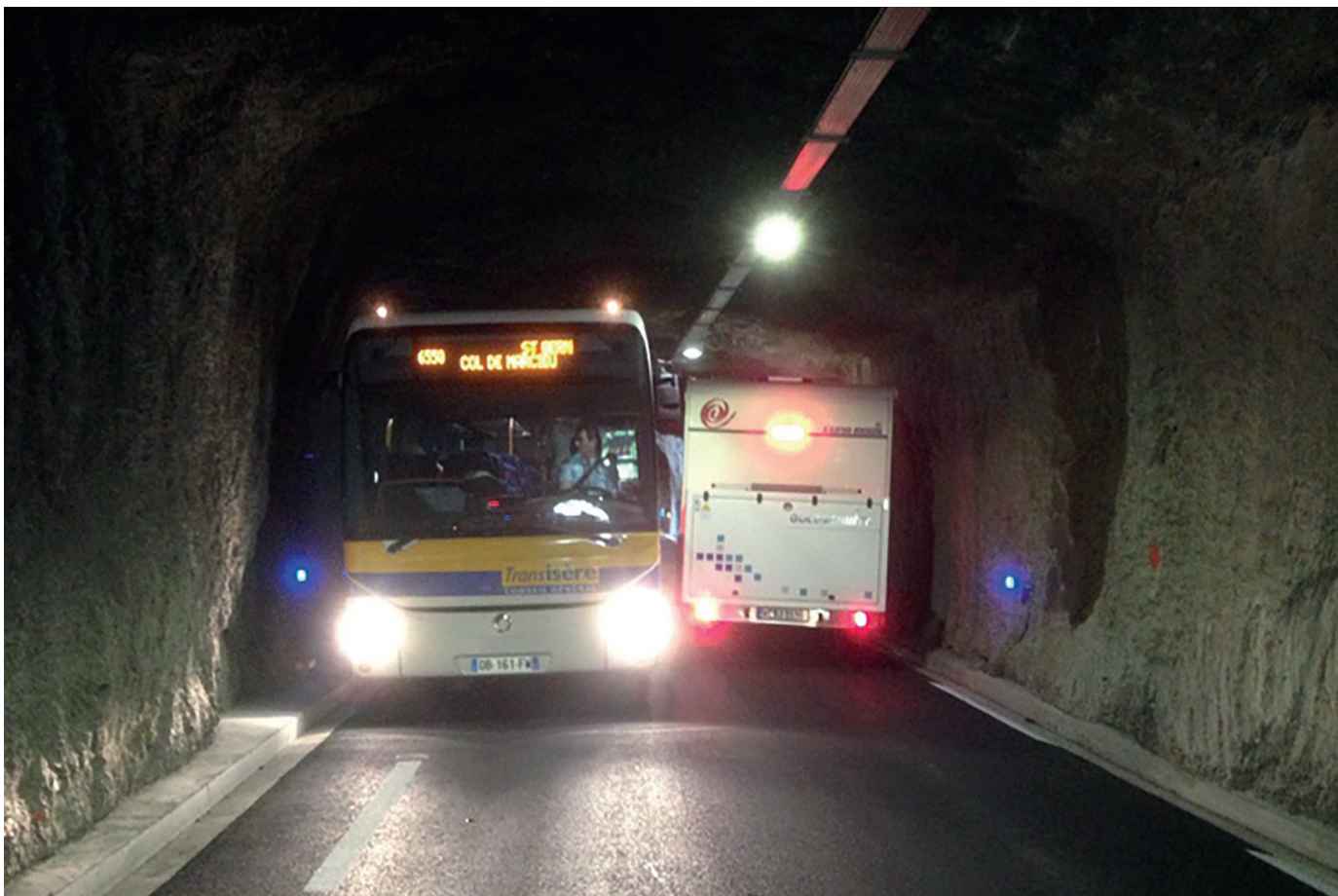
Croisement de véhicules de grande dimension dans le tunnel de Saint-Pancrasse (© CD38)
