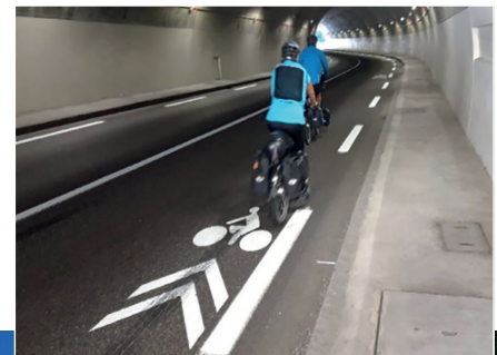
Marquage de positionnement pour les cyclistes (© CETU)
