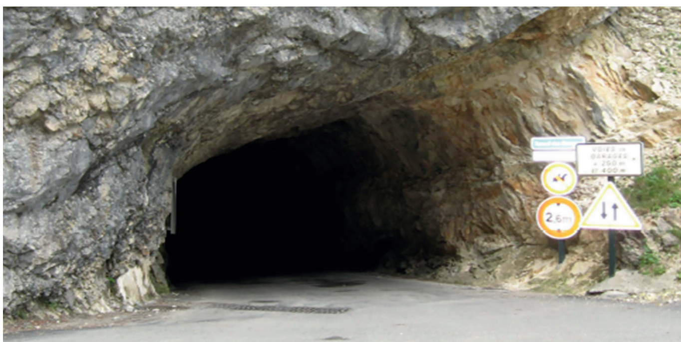
Les deux têtes de tunnel des Écouges avant aménagement (© CD38)
