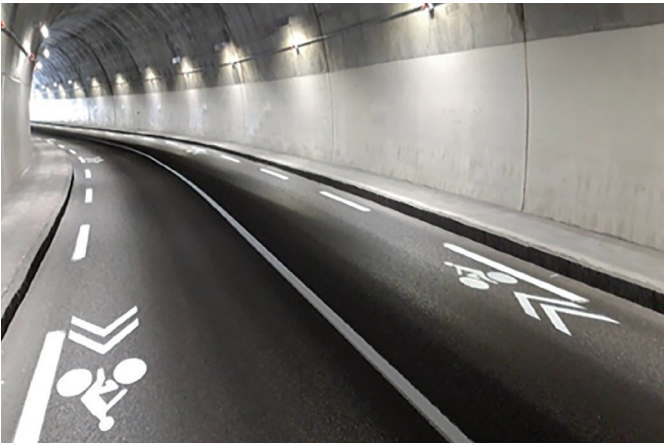
Bandes latérales éclairées pour la circulation des cycles dans le tunnel de Bioge (© CETU)
