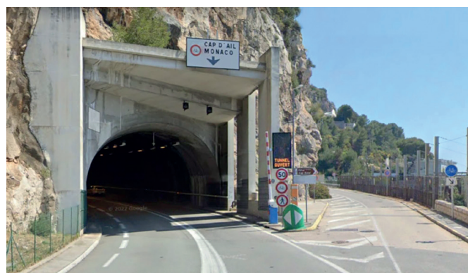
Tête ouest du tunnel de Cap Estel (© Nice Métropole)
