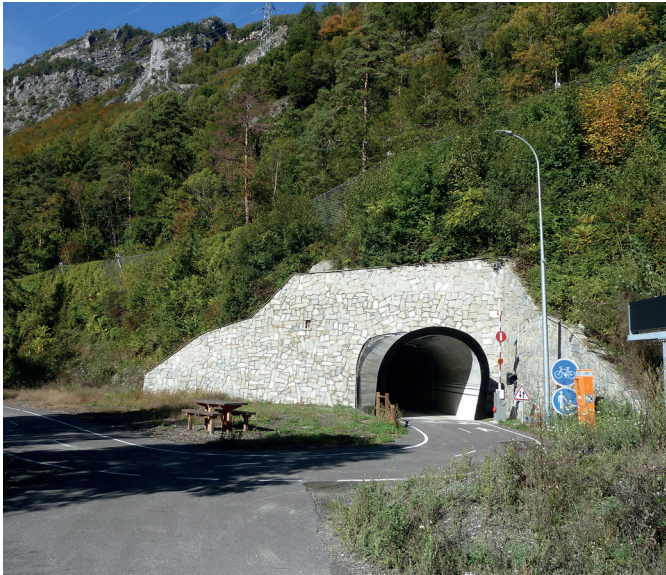
Entrée est de la galerie de sécurité côté Aime (© DIR Centre-Est)
