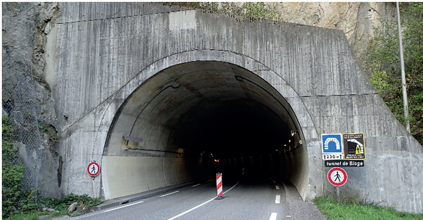
Tunnel de Bioge (© CETU)
