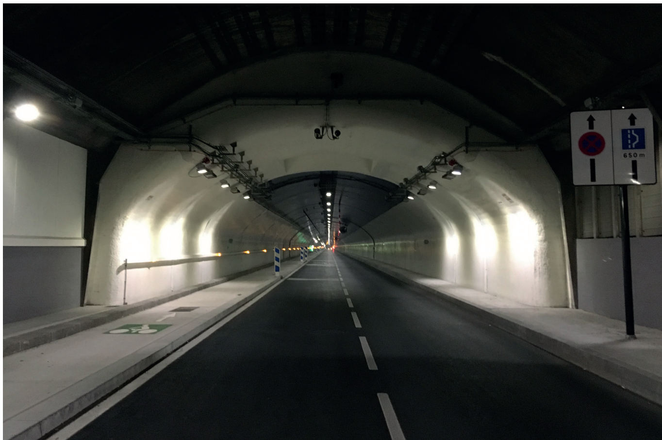
Tunnel Jenner après rénovation (© Egis)
