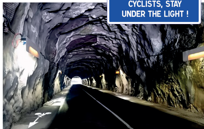
Le tunnel d4 Villaret-du-Nial après aménagement en 2017 (© CD73)
