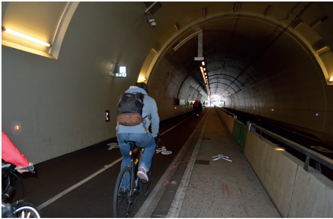
Tunnel modes doux de la Croix-Rousse (© CETU)
