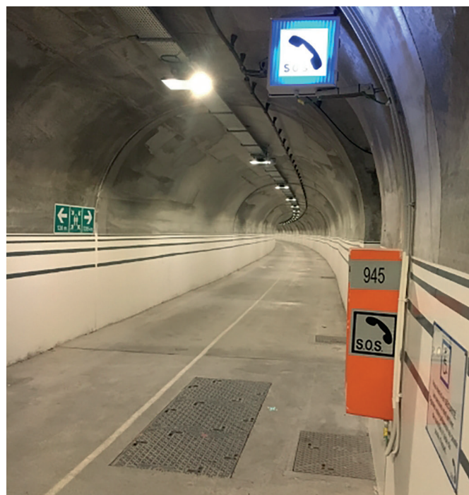
Intérieur de la galerie de sécurité (© CETU)
