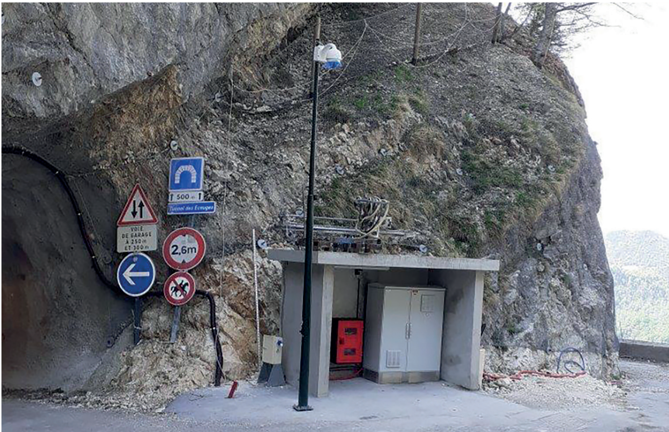
Tête sud du tunnel des Écouges après travaux (© CETU)
