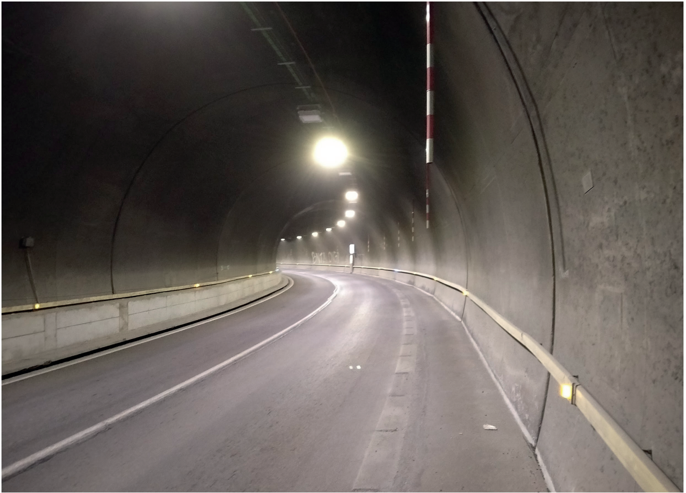
Intérieur du tunnel de la rampe des Commères – sens montant (© CD38)
