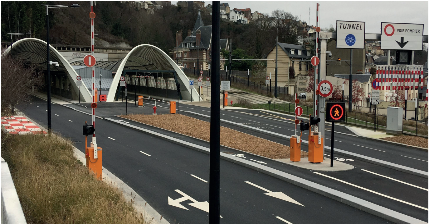
Tête sud du tunnel Jenner après rénovation (© Egis)
