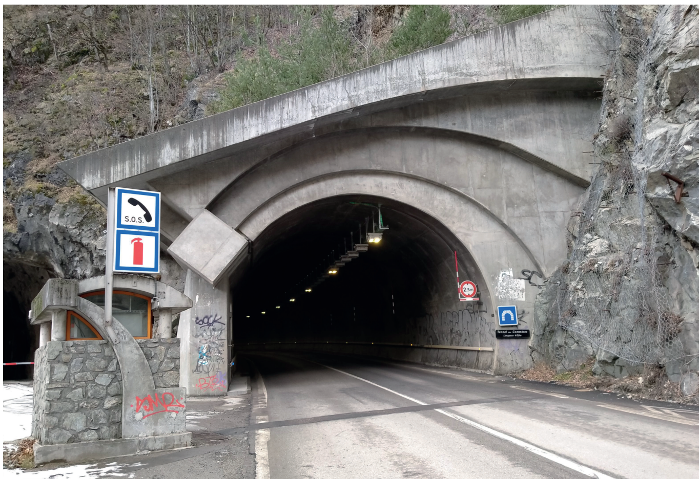
Tête nord du tunnel de la rampe des Commères (© CD38)
