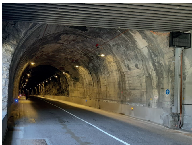
Tunnel du Chevril (© CD73)
