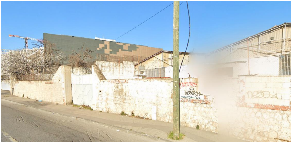
Figure 3 : Murs tout autour du site, vu de l'extérieur © GoogleMaps
