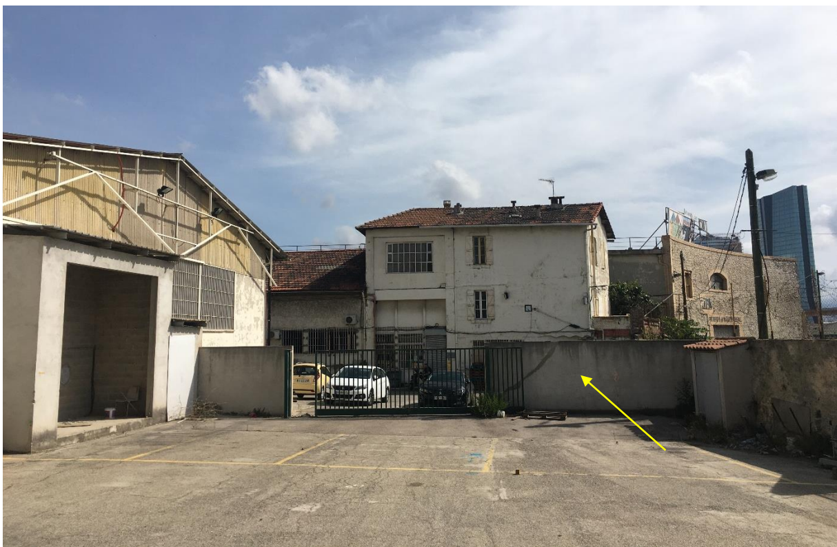
Figure 4 : Murs tout autour du site, vu de l'intérieur © EODD, 2022
