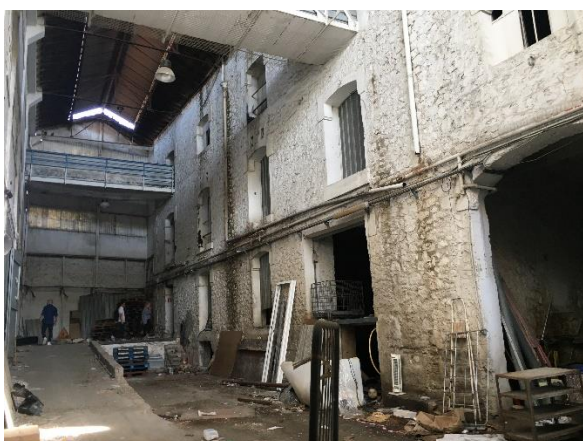
Figure 5 : Construction abandonnée © EODD, 2022
