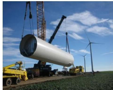
*Figure 5 : Illustration du montage d'une éolienne – mât et rotor (source : ABO Wind, 2014)*
