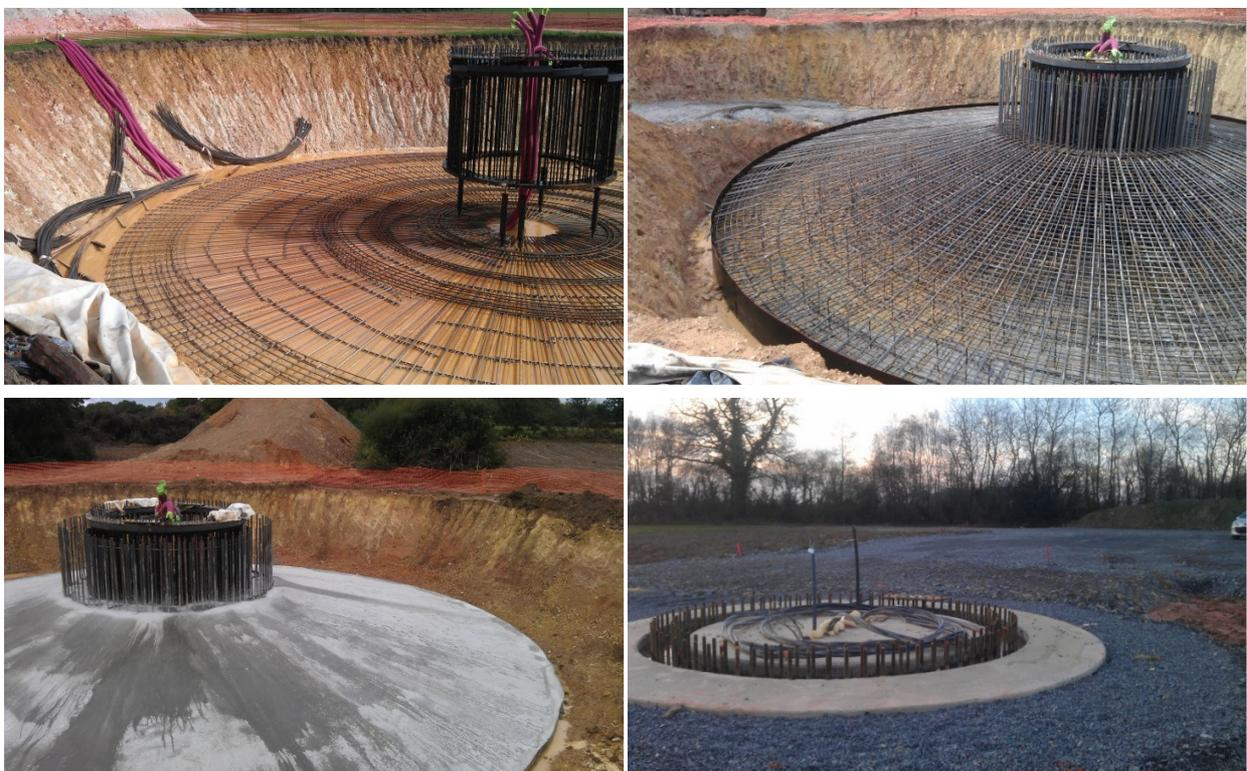
*Figure 4 : Illustration du montage d'une éolienne – fondations (source : ABO Wind, 2013)*
