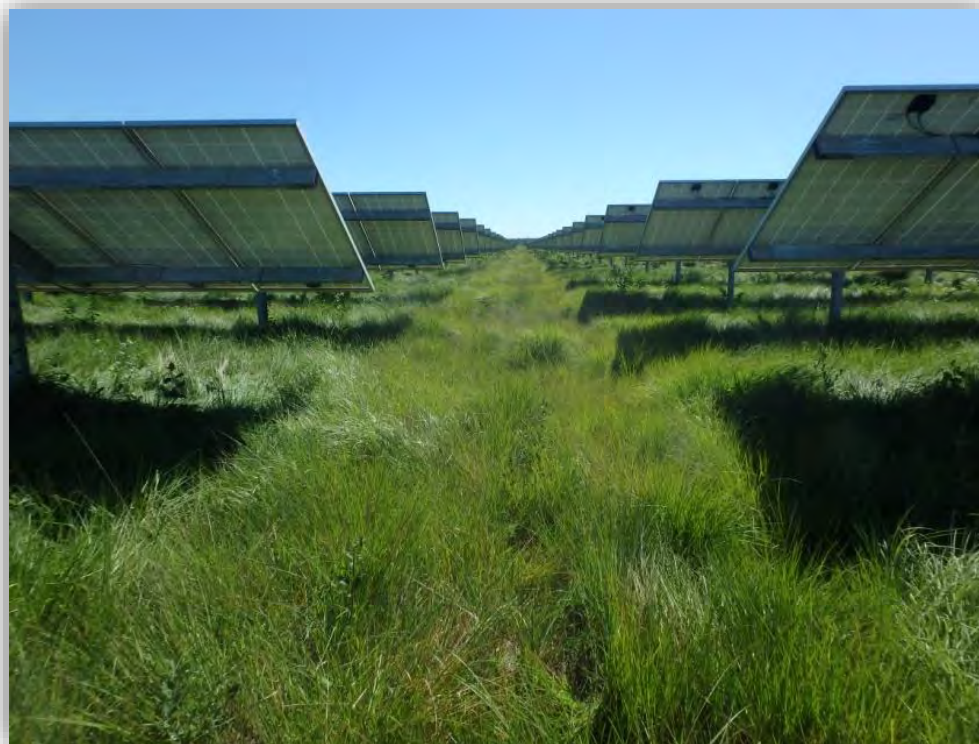
Photo 22 : Illustration d'une végétation non broyée sous des panneaux en exploitation au mois de mai
