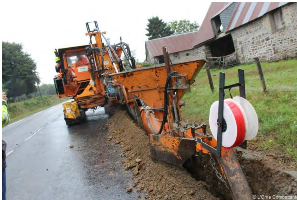
Photo 11 : Illustration d'un forage dirigé pour l'enterrement d'une ligne électrique le long d'une route
