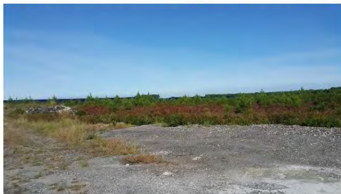
Figure 2 : équipement zone sud et plateforme
