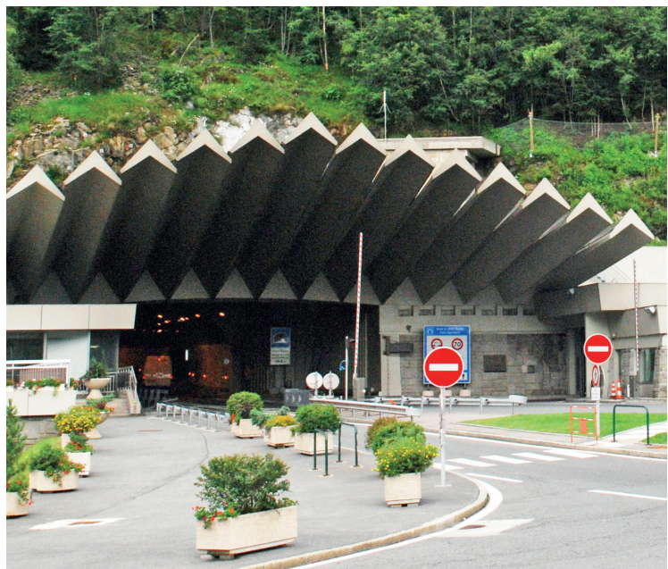
Entrée du tunnel routier du Mont-Blanc (côté français).
