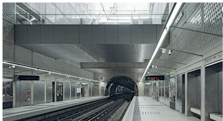
La station de métro Hôpital Lyon Sud et son arrière-gare (au fond).
