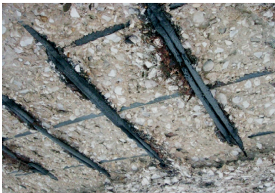
Écaillage de béton armé après un incendie.
