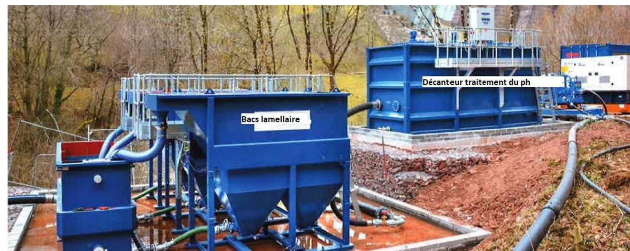
Figure 58 : Exemple d’installation de traitement des eaux par des éléments modulaires (Source : Groupement Intencités 15)
