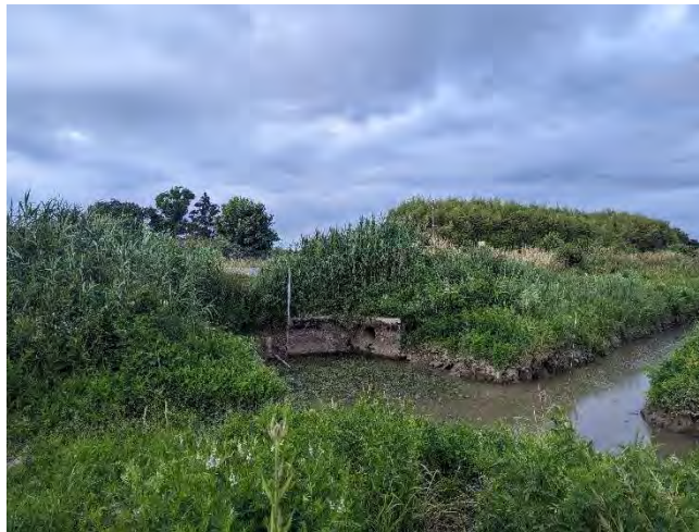
Obstacle hydraulique entre le Grand canal et les barthes de Lahonce
