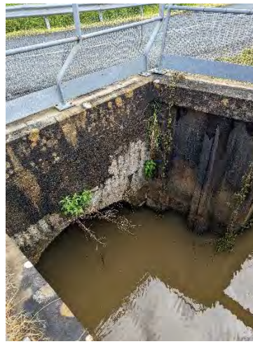
Ouvrage côté RD831
