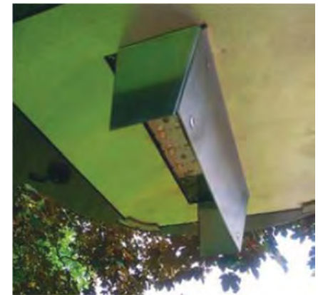
Lampe équipée d'un coupe-flux pour diriger la lumière vers le sol (Source : Trame noire OFB)
