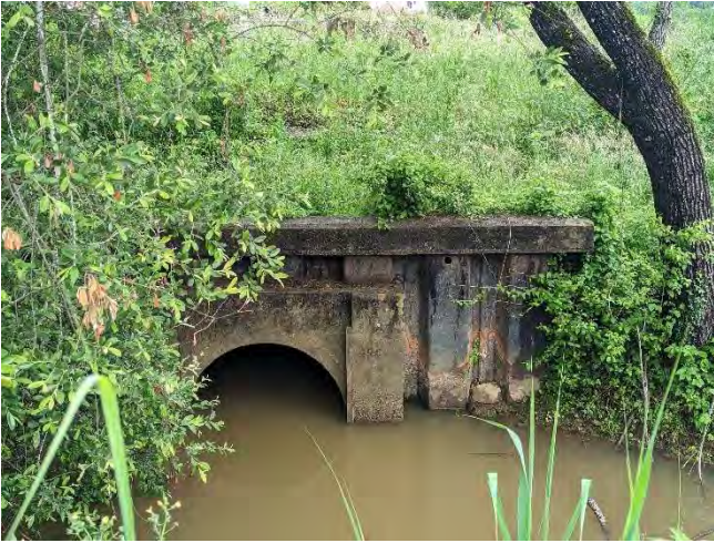
Ouvrage côté bassins Irauldenia
