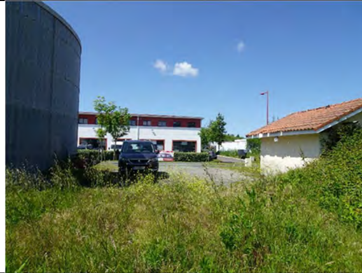
Imperméabilité du sol – Secteur 22.
