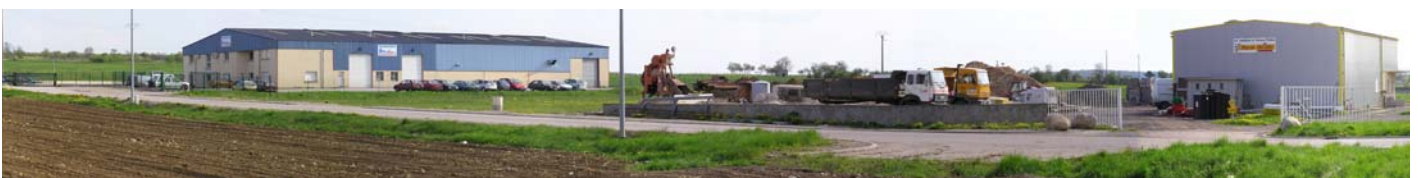
La qualité des constructions et des aménagements de leurs abords conditionne la réussite de l'implantation des zones artisanales ou industrielles. Gironcourt-sur-Vraine
