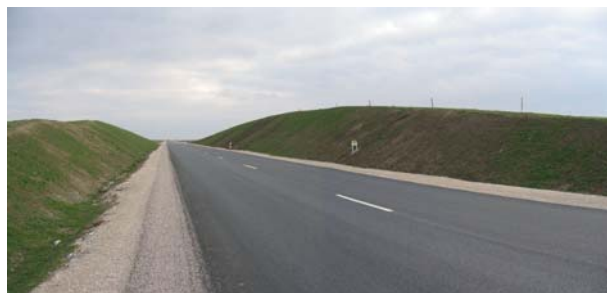
Une meilleure insertion paysagère des ouvrages routiers est à rechercher. RD 460. Attigny
