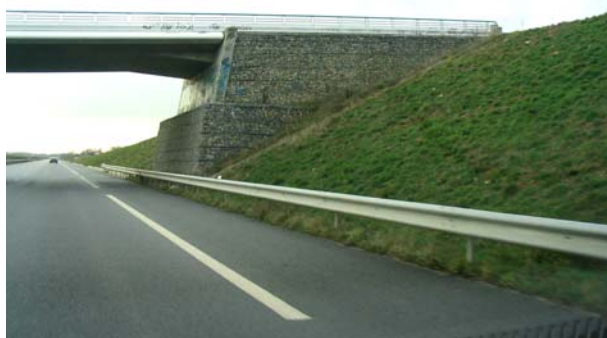
Les ouvrages d'art forment des événements et des repères dans le parcours. La silhouette est mise en valeur par le traitement sobre du sous-bassement en gabion. Uxegney
