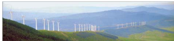
Un exemple de projet éolien calé sur les lignes de force d'un paysage montagnard en Navarre espagnole.
