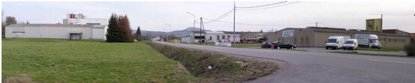
La zone d'activité, pourtant située en entrée de bourg, ne comporte pas de projet global d'aménagement. Celui-ci se résume, pour le moment, à l'implantation de bâtiments. Corcieux
