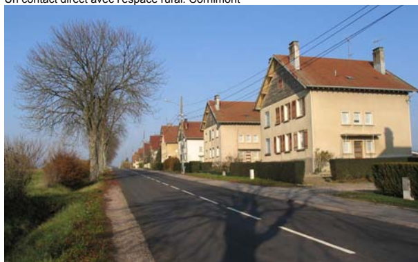
Des constructions structurant fortement le paysage. Darnieulles
