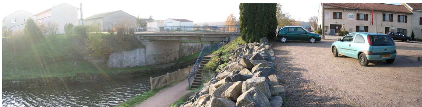
Le long du canal, des aménagements de berges à l'impact paysager discutable.
