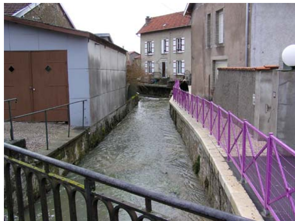
Passage aménagé en bord de rivière malgré l'exigüité des lieux. Martigny-les-Bains
