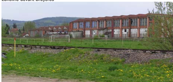
Les anciennes usines offrent des opportunités foncières pour des opérations de renouvellement urbain. Laveline-devant-Bruyères
