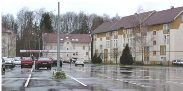
Des habitations donnant directement sur le parking d'un supermarché : de nouveaux contacts à instaurer. Thaon-les-Vosges
