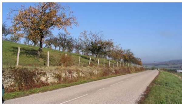
Mur de soutènement en pierre en voie d'enrichissement le long de la route. Ubéxy
