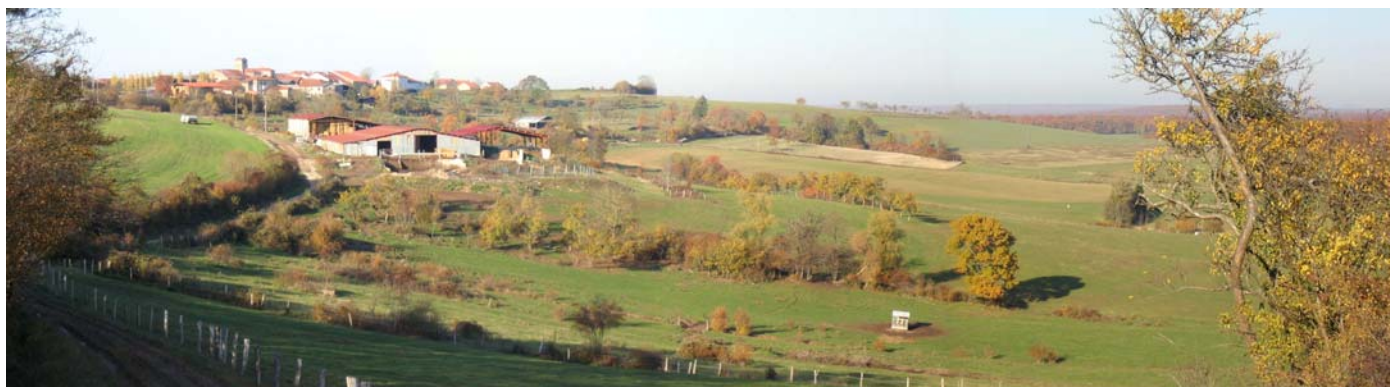
Des bâtiments imposants qui changent considérablement la silhouette du village.
