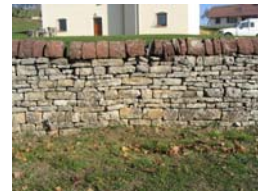
Le mur en pierre. Bagnécourt
