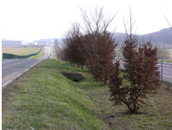
Aménagement de l'emprise entre RN 57 et RD 157 : un traitement judicieux est possible lorsque les emprises sont suffisantes. Nomexy
