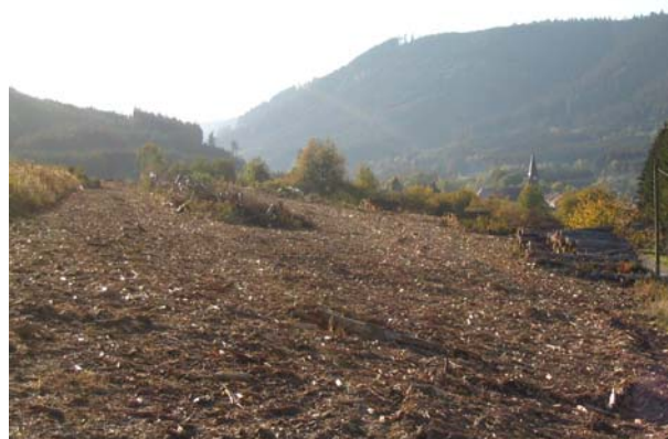
Broyage des rémanents en bord de route. Raon-sur-Plaine
