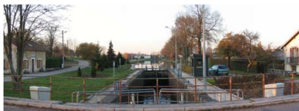
Mettre en valeur les ouvrages du canal en s'appuyant sur le vocabulaire spécifique de cet ouvrage : alignement d'arbres, maçonnerie de pierre, enherbement. Girancourt
