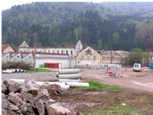
La démolition d'anciens bâtiments d'usine est un préalable parfois nécessaire pour pouvoir tirer parti de certaines emprises. Rupt-sur-Moselle
