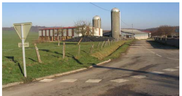
Les hangars agricoles et leurs annexes restent extrêmement prégnants dans le paysage ouvert du Xaintois. Oëlleville
