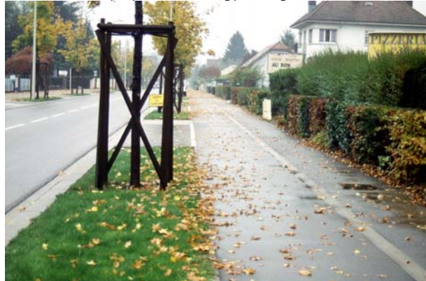
L'aménagement des abords de la voie permet d'affirmer le caractère de la rue. Moyenmoutier
