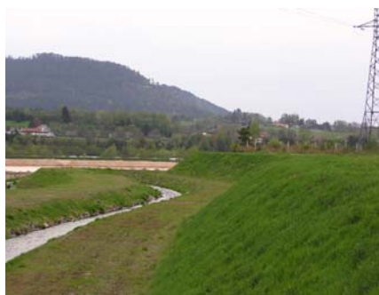
Des talutages très raides qui n'anticipent pas la requalification du site.
