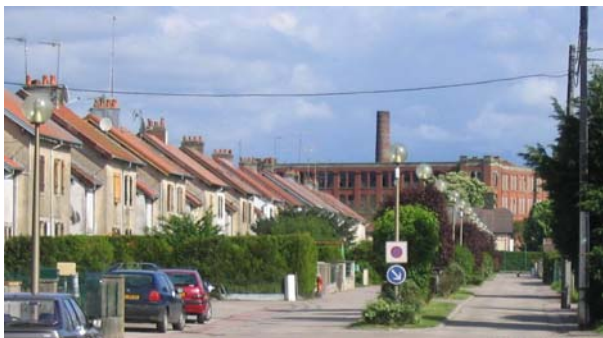
Mise en valeur de maisons ouvrières par un aménagement de qualité des espaces publics qui redonne une souplesse à la rue dans un espace très cadré par le bâti. Vincennes
