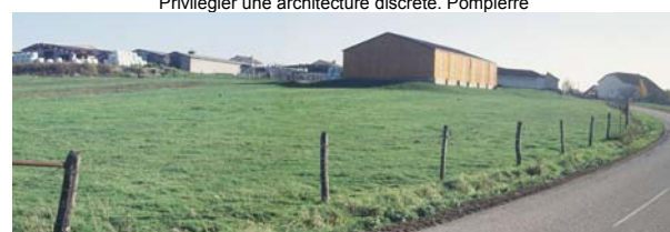
Eviter les positions en belvédère, le long des axes d'entrée dans le village. Gorhey
