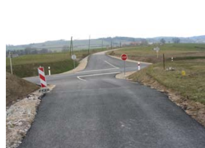
L'abus des remblais-déblais qui masquent les vues sur le paysage.
