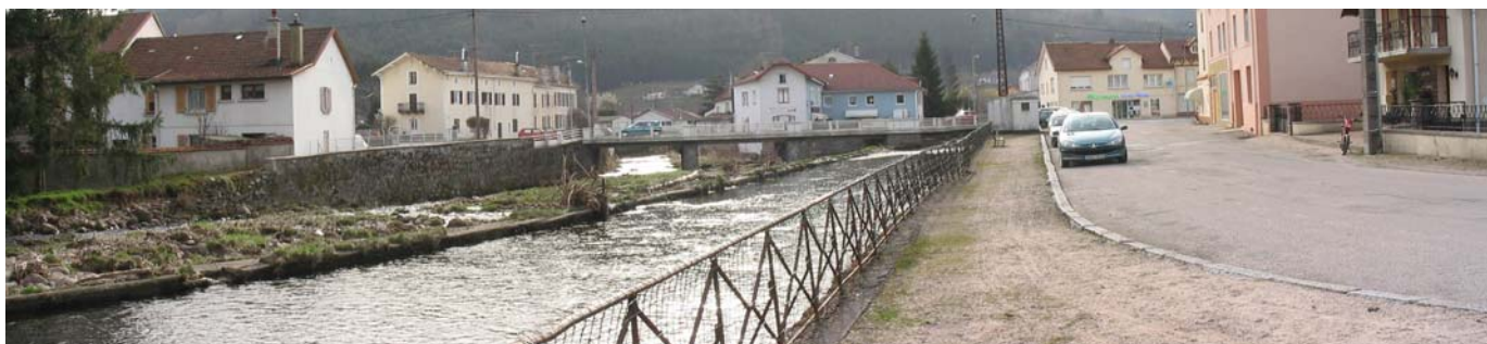
Le passage de l'eau dans la ville constitue un événement à mettre en valeur par le traitement de ses abords, des ponts, des espaces publics à proximité, des accès, et des vues. Granges-sur-Vologne
