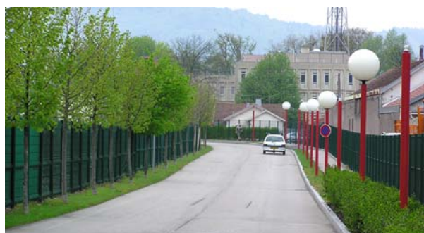
Un traitement soigné des arrières des parcelles et des voiries de desserte secondaire. Remiremont
