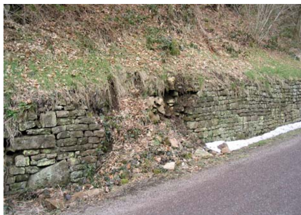
Défricher et entretenir les murs de soutènement qui accompagnent les routes. La Croix-aux-Mines
