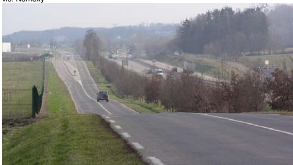
D'importantes infrastructures, ici la RD 157 et la RN 57, suivent le fil de la vallée, s'étalant ou se rapprochant au gré des terrasses et du fond de la vallée. Nomexy
