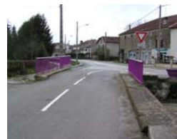
Le pont. Martigny-les-Bains
