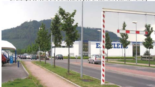
La plantation de la voirie primaire de la zone commerciale permet d'assurer la hiérarchie des circulations et d'offrir une unité au paysage souvent hétéroclite de ces quartiers. Saint-Dié-des-Vosges
