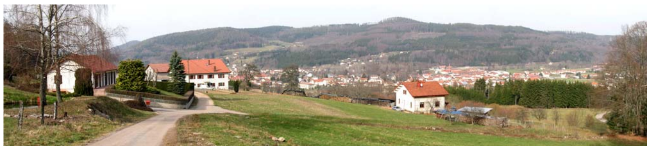
L'urbanisation tend à s'étaler anarchiquement à travers la vallée, grimpant de façon éparse à l'assaut des coteaux. Granges-sur-Vologne
