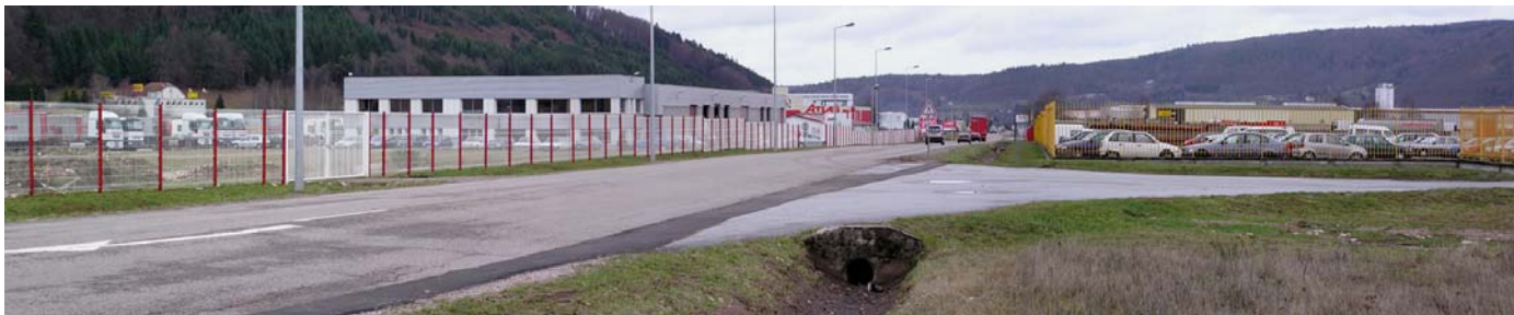
Les installations industrielles sont venues s'implanter le long de la RD 157, transformant considérablement le paysage avec lequel la route doit retisser de nouveaux liens : les limites de parcelles doivent être aménagées dans un projet global. Saint-Nabord
