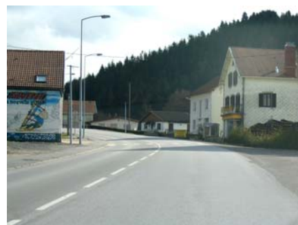
L'aménagement « routier » de l'accotement à travers le bourg.
