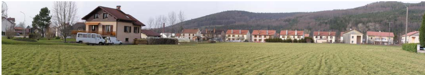
L'urbanisation progresse au coup par coup, laissant des « dents creuses ». Elle comble rapidement l'espace en le banalisant, sans le structurer. Les maisons ouvrières (en arrière plan) proposent à l'inverse un mode d'habitat plus dense et très structurant qui tranche avec les formes urbaines diluées et anarchiques des pavillons. Granges-sur-Vologne
