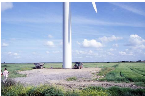
Soigner les abords et les voies d'accès de chaque éolienne. Vendée
