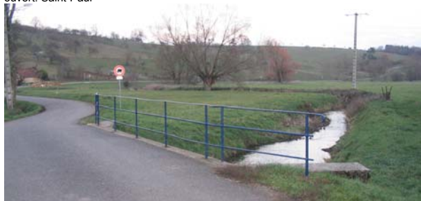
Des cours d'eau qui se découvrent seulement au niveau des ponts routiers. Ramécourt
