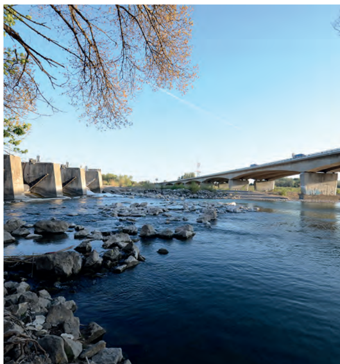
PONT DE L'A7 ET CENTRALE ÉLECTRIQUE À BONPAS - CAUMONT-SUR-DURANCE
