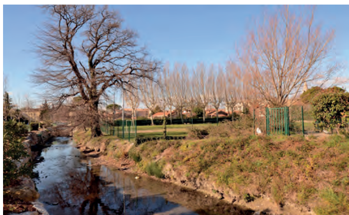
CANAL DE VAUCLUSE
