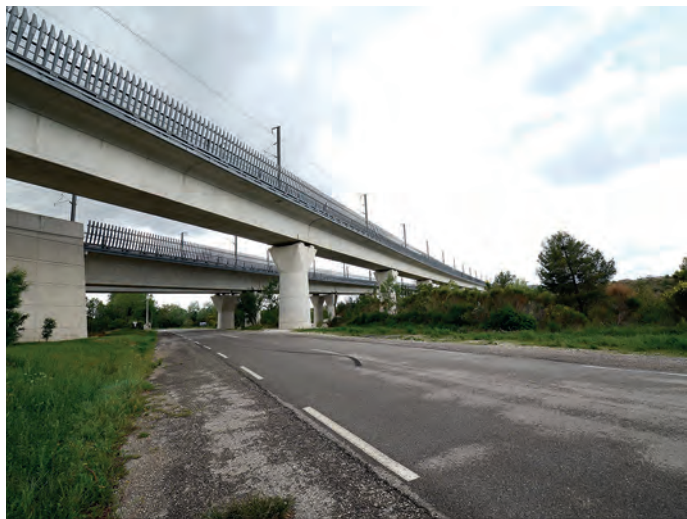
PONT DU TGV COURTINE - AVIGNON
