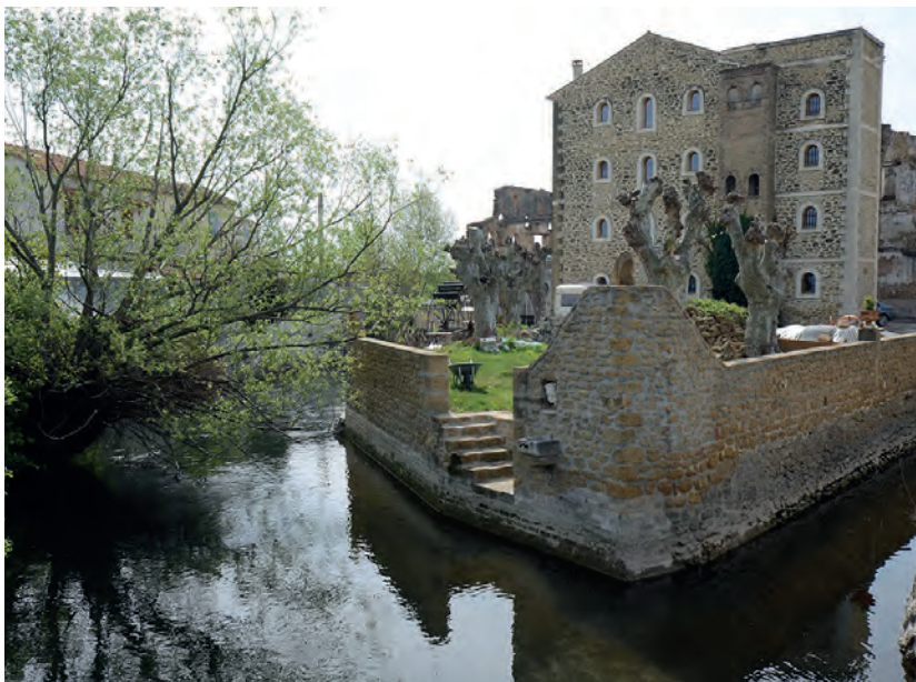
USINE DE VALOBRE ENTRAIGUES
