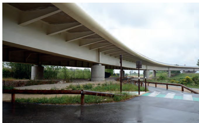
PONT DE LA N1007 - AVIGNON
