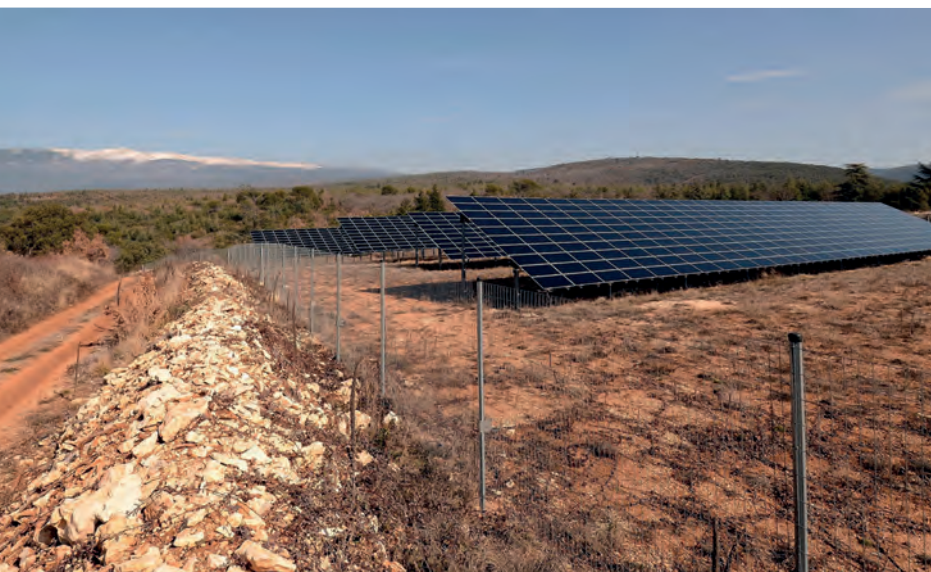
CENTRALE PHOTOVOLTAÏQUE DE BLAUVAC
