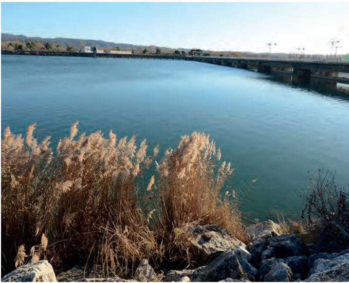
LE BARRAGE DE MALLEMORT SUR LA DURANCE - MERINDOL
