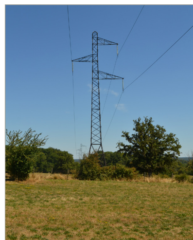
Figure n°23 : Ligne aérienne à 225000 volts PUSY - ROLAMPONT - Z LA RIGOTTE à Malvillers
