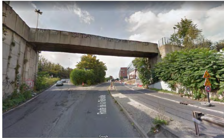
Figure 98 : Vue de la passerelle actuelle et de ses appuis
