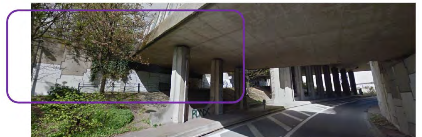
Figure 94 : Vue en arrière-plan du parement en sol renforcé conservé (depuis la RN 410 depuis le Sud) et contre lequel est prévu l'OA1
