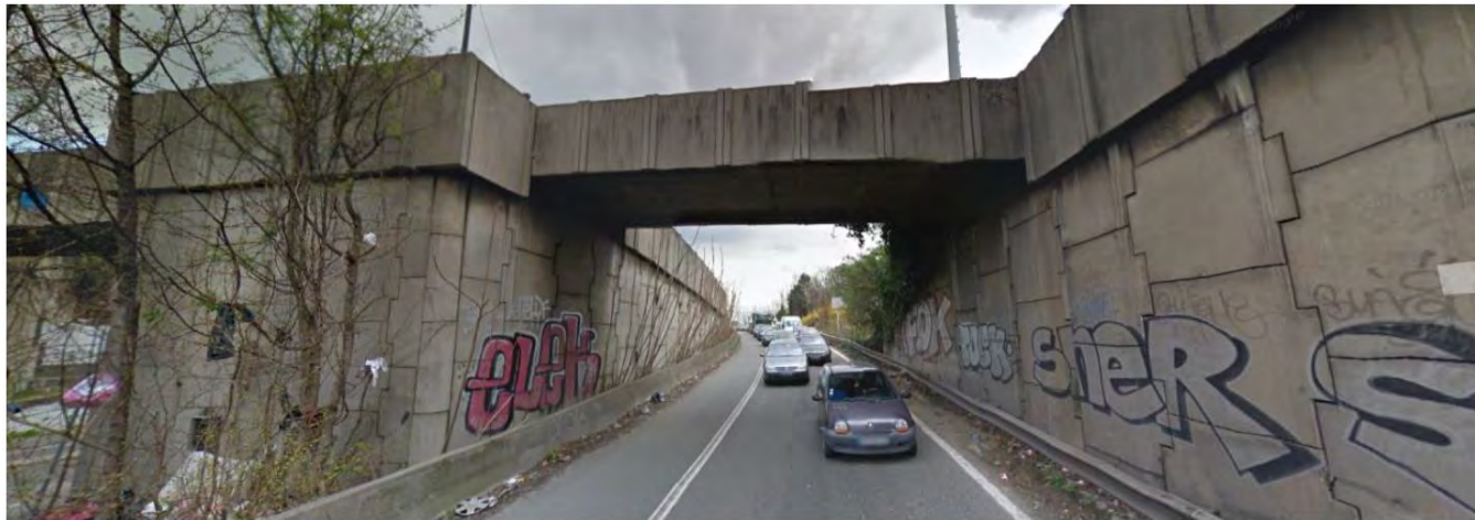
Figure 101 : Vue du passage supérieur à démolir au niveau du futur OA2 (approximativement) portant le cheminement piétonnier et vue du belvédère sur la gauche (point de vue depuis la bretelle – observateur faisant face à l'Est)
