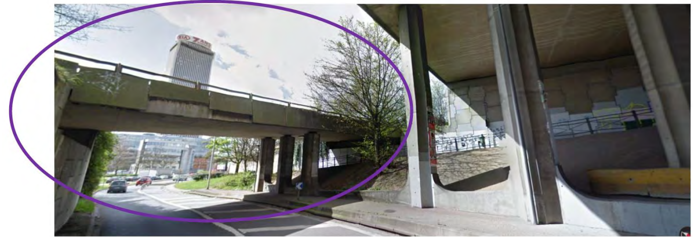
Figure 93 : Vue de l'ouvrage d'art de franchissement de la RN 410 (à gauche) et du cheminement piéton (à droite) par la bretelle actuelle (vue depuis le Nord)
