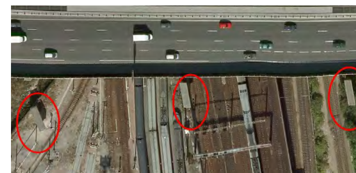
Figure 1 : 3 piles de ponts non utilisées
