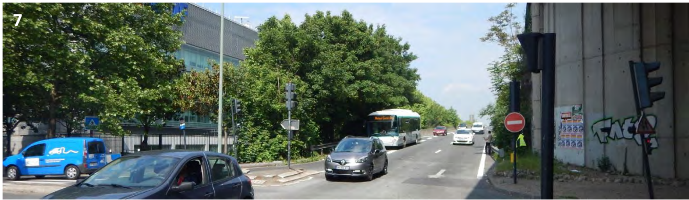
7 La sortie de l'échangeur de l'A86 ne permet pas d'échappées visuelles. En effet, d'un côté les délaissés liés aux contraintes techniques de l'ouvrage forment un écran végétal entre les bâtiments et l'A86. Et de l'autre côté de la bretelle de décélération, la disposition de l'ouvrage au-dessus du terrain naturel forme d'un un écran opaque.
