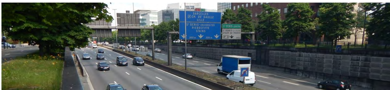
Photo 31 : L'autoroute A1 au niveau de la ZAC Landy-Pleyel
