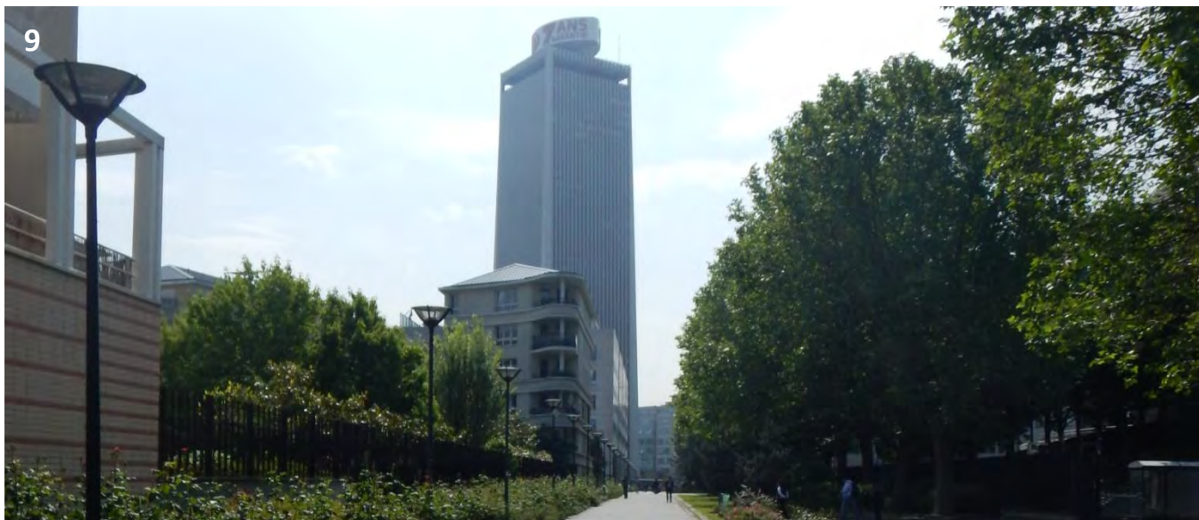
9 Depuis l'allée de la Seine le front bâti forme une barrière visuelle en direction de l'ouvrage de l'A86. La tour Pleyel devient le seul édifice à se démarquer dans ce tissu urbain par le contraste de taille qui existe entre les différents éléments bâtis du secteur.
