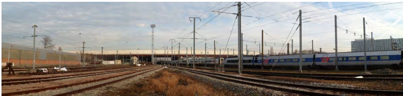
Photo 30 : Le faisceau ferré depuis le Technicentre de Landy et le pont de l'A86 en arrière-plan
