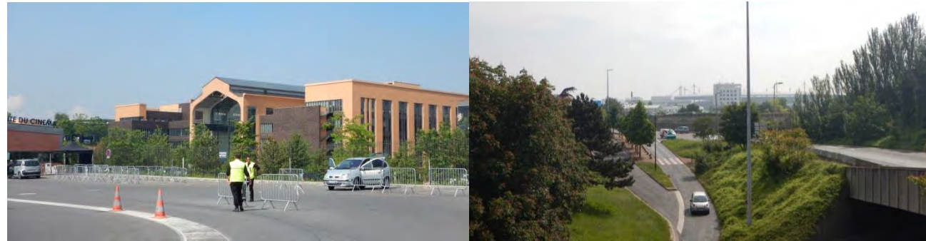
Photo 34 : La cité du cinéma et le stade de France vue depuis une passerelle piétonne aux abords de l'A86
