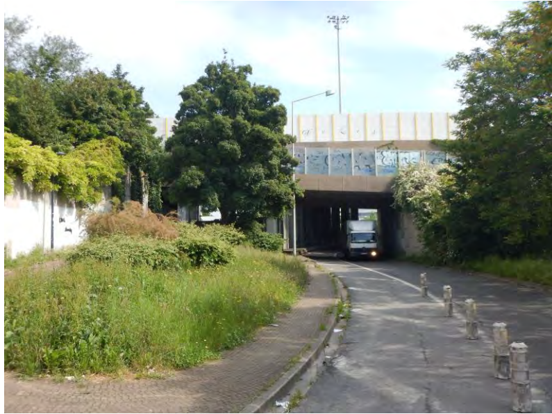
Photo 5 : RD410 sous ouvrages A86
