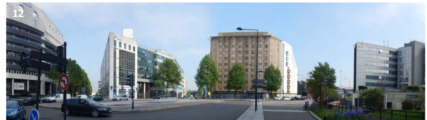
12 Depuis le Boulevard Anatole France les vues sont bloquées par l'infrastructure de déplacement, les délaissés liés aux contraintes techniques de cet ouvrage forment un écran végétal permettant de limiter son impact visuel.
