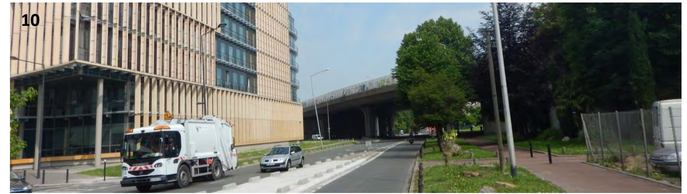
10 Depuis le Boulevard de la Libération l'ouvrage de l'A86 repose sur une structure ajourée pour permettre le passage de la voie de circulation. Néanmoins, les perspectives restent limitées par présence de bâtiments sur les bords de l'avenue.
