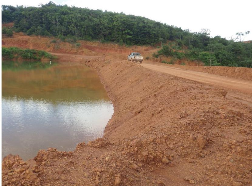
Le sommet de digue, occupé par la piste d'accès, est convenablement bombé et les eaux pluviales y sont gérées correctement ; le talus aval comporte une petite érosion coté Nord (rive gauche) sans gravité car concernant le terrain naturel, et on observe de petites fuites en pied (fuites au contact terrain naturel-remblai par suite d'une absence d'ancrage latéral), également sans gravité car maîtrisées par le massif de latérites graveleuses mis en place en pied de digue.
