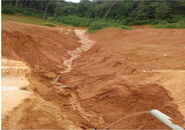
**Ecoulement de la surverse dont une partie du chenal est creusée dans du remblai**
