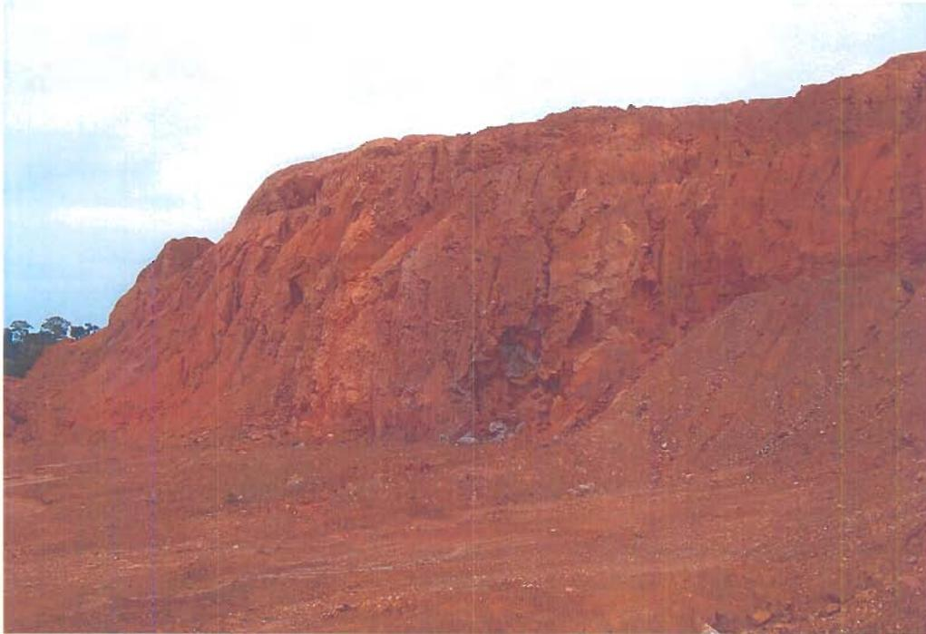
Filon VIRGILE, partie nord du talus ouest ; on remarque une diaclase faiblement pentée vers le talus induisant un dièdre déversant. D'autres diaclases subverticales à pendage favorable induisent des instabilités de faible volume (arrachement en pied de talus, ..).
