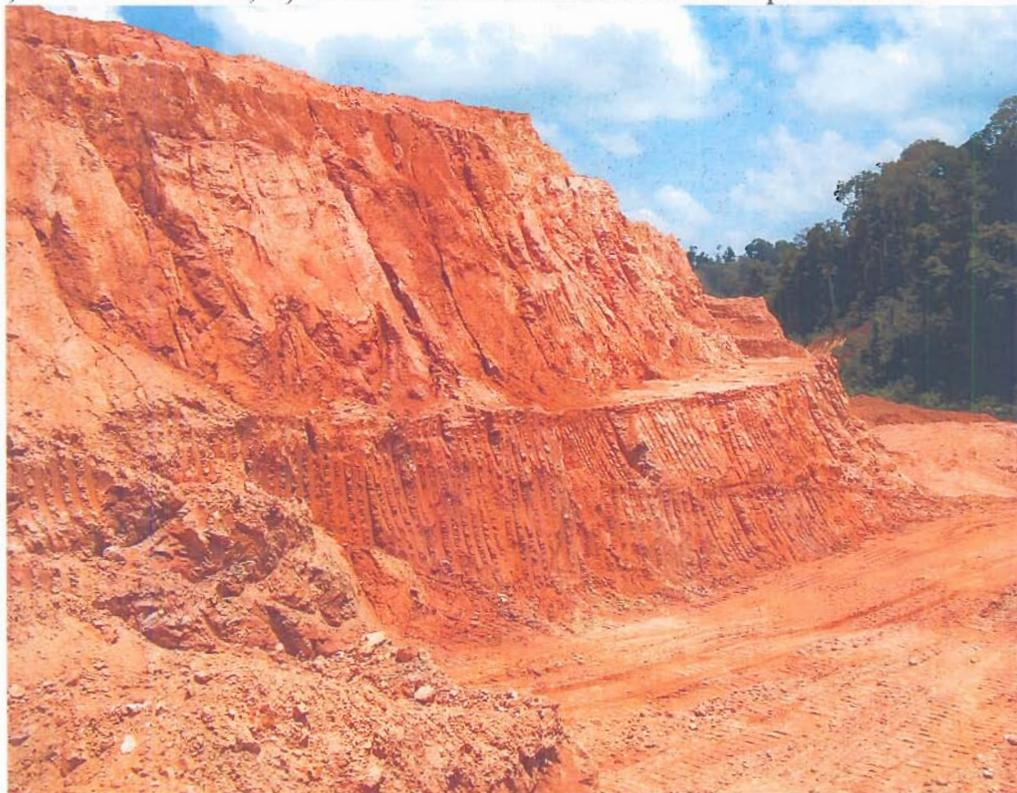
Chantier OVIDE, actif actuellement, partie sud du talus est ; très peu de discontinuités sont observables dans les talus (principalement des filonnets de quartz subhorizontaux) sur lesquels aucun désordre n'est apparu, les instabilités éventuelles apparaissant la plupart du temps avec la décompression à moyen terme des matériaux (quelques mois).
