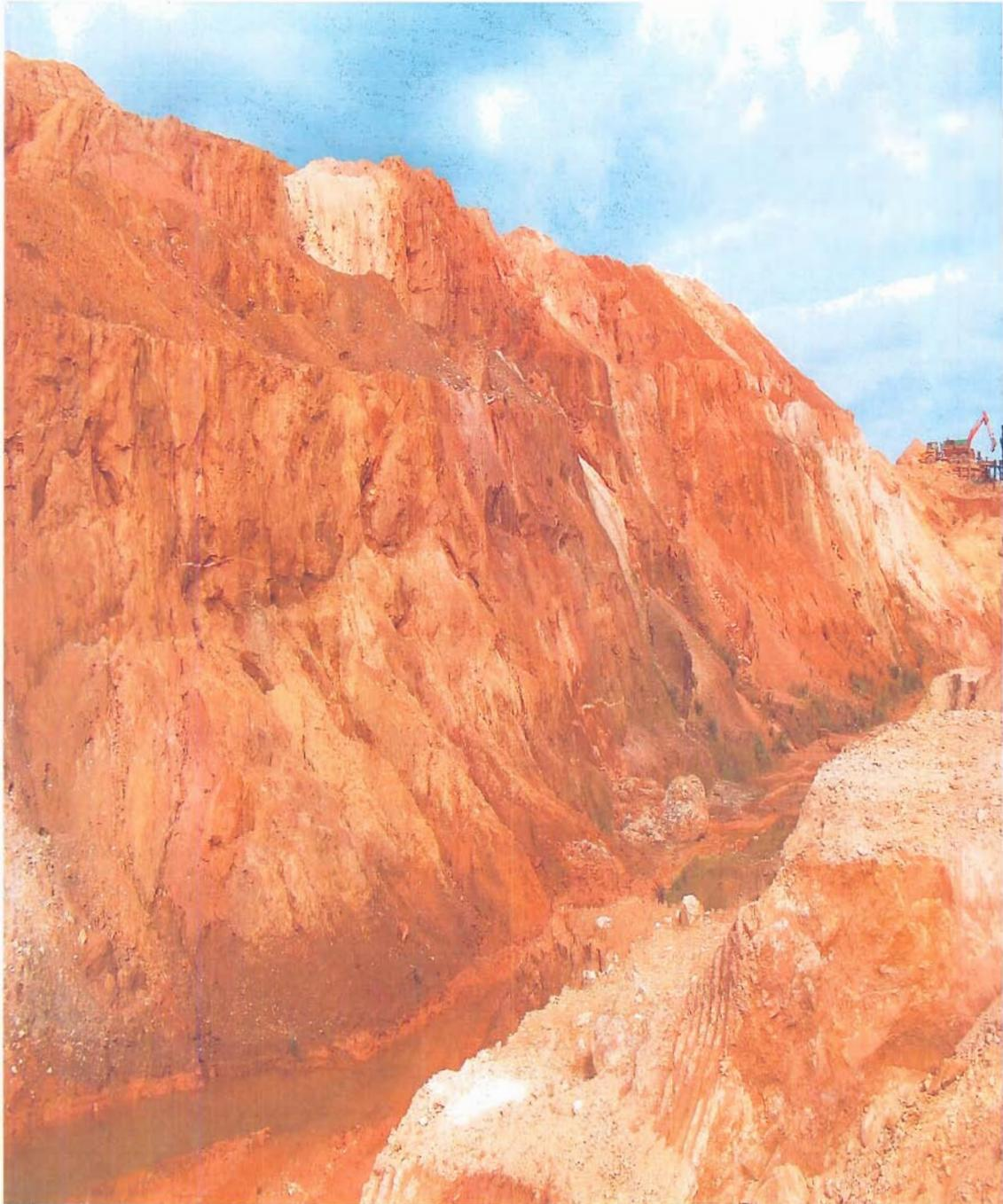
Filon CESAR, vue d'ensemble du talus est depuis le nord. La stabilité d'ensemble de la tranchée apparaît convenable, mais de nombreux désordres apparaissent à plus petite échelle, avec des dièdres de faible volume liés à la fracturation et des mouvements de matériaux liés à des défauts de maîtrise des eaux pluviales ou à une géométrie des talus inadaptée (stockage de stériles, forts talus raides, ..)..
