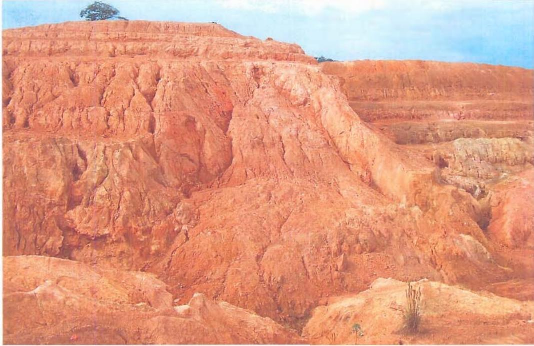
Filon VIRGILE, partie centrale du talus ouest ; vue d'ensemble du grand glissement provoqué par l'intersection de deux failles avec un pendage défavorable (pendage dirigé vers l'intérieur du chantier). Les talus voisins au-delà de ces deux fractures apparaissent de bonne tenue générale.
