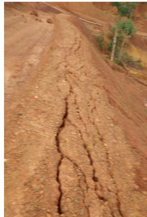
Une fissuration fraîche existe aussi en partie centrale sur le redans aval avec une série de fissures concentriques, sans fuite ni déformations en aval ; peut-être s'agit il seulement d'un affaissement de la bordure en crête de talus mais ce point nous paraît devoir être surveillé de façon à parer à toute évolution.
