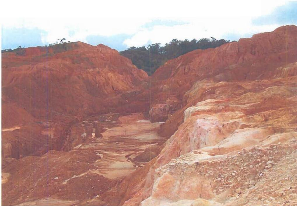
Filon VIRGILE, vue d'ensemble depuis le sud. On note d'une façon générale l'importance des volumes de terres transportés par l'érosion pluviale lorsque ses eaux se déversent vers le chantier, et surtout lorsque des remblais stériles se trouvent installés dans le bassin versant immédiat du chantier.
