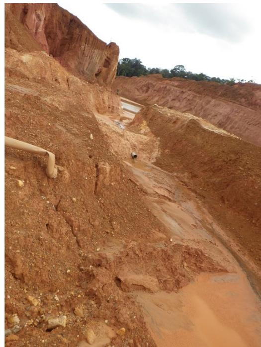
**Vues de l'évacuateur de crue depuis l'amont et l'aval avec le profond canyon d'érosion dans les remblais.**
