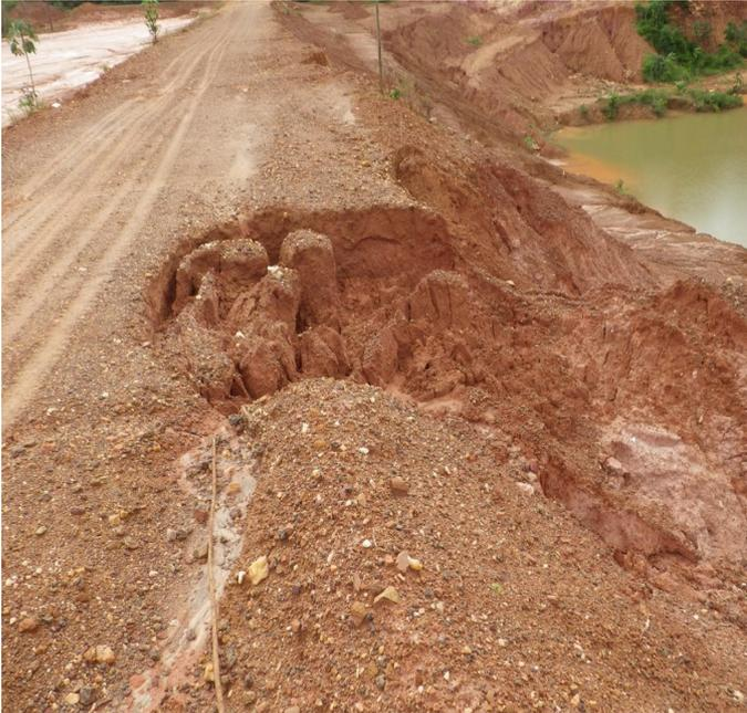
**Canyon d'érosion en partie Nord de la digue, consécutif à un défaut de maîtrise des eaux pluviales de la piste d'accès.**
