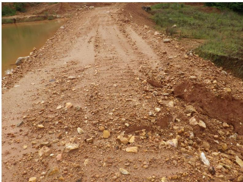
Cette situation se trouvera ici de nature à conduire à un risque de rupture au moins partielle de la digue D2 aval en cas de vidange rapide de ce bassin aval et il conviendra ici dans tous les cas de réaliser une vidange très lente de cet ouvrage afin de permettre la désaturation du pied de digue et éviter ainsi de tels risques de rupture.
