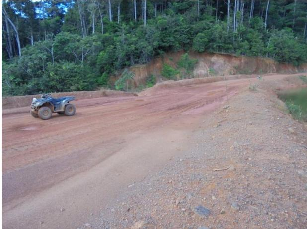
**Dépression en milieu de digue et apparition d'un canyon d'érosion**
