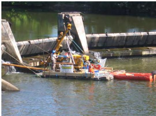
Les prélèvements seront réalisés à partir d'un ponton sur lequel sera positionnée la sondeuse pouvant supporter une machine de forage (voir photos jointes en annexe) et permettant un travail en toute sécurité. Sur chaque point le ponton sera stabilisé à l'aide de pieds rétractables et adaptables lui permettant d'avoir une assise sûre pour la réalisation des carottages.
