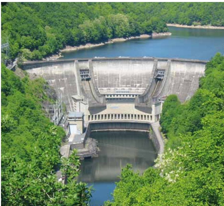
Station de Transfert d'Énergie par Pompage
