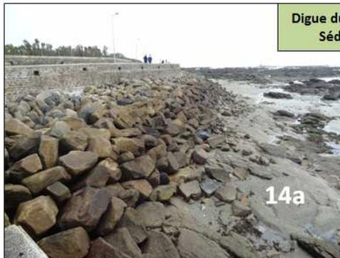
Digue du port en béton qui bloque les sédiments :
