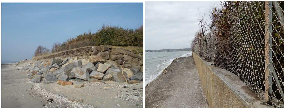
**Figure 112 : Dommages observés sur les enrochements situés à l'est de la plage de Kerleven (photos Egis, 20 janvier et 24 février 2014)**
