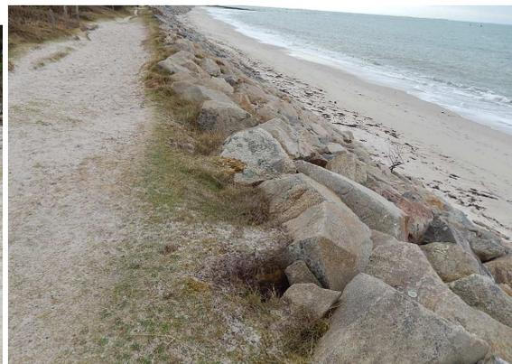
**Figure 97 : Traces de franchissements et d'érosion au niveau de la protection longitudinale en enrochements (photos Egis, 24 février 2014)**
