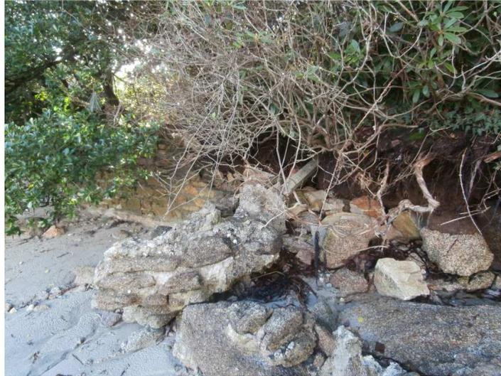
**Figure 138 : Dommages observés sur le muret de protection à l'ouest de la plage de la Belle Etoile (photo réalisée par la commune)**
