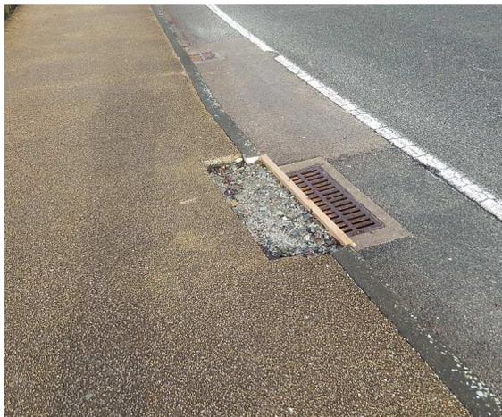
**Figure 131 : Réfection des grilles des caniveaux par la commune (photo Egis 24 février 2014)**
