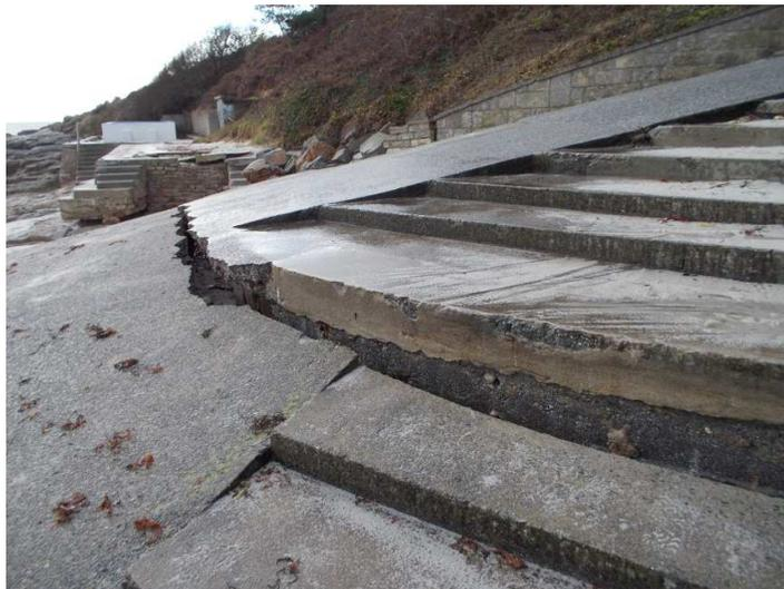
**Figure 81 : Rupture visible dans l'escalier d'accès de la plage des Dunes (photo Egis, 20 février 2014)**
