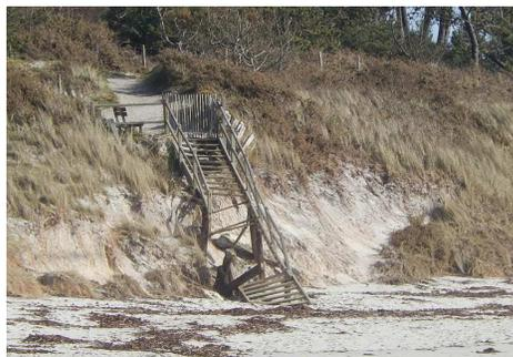
**Figure 83 : Erosion à l'extrême est de la plage des Dunes, au niveau de la pointe de Beg Meil (à gauche) et à l'est immédiat de l'escalier d'accès de la plage (à droite) (photos Egis, 20 et 24 février 2014)**
