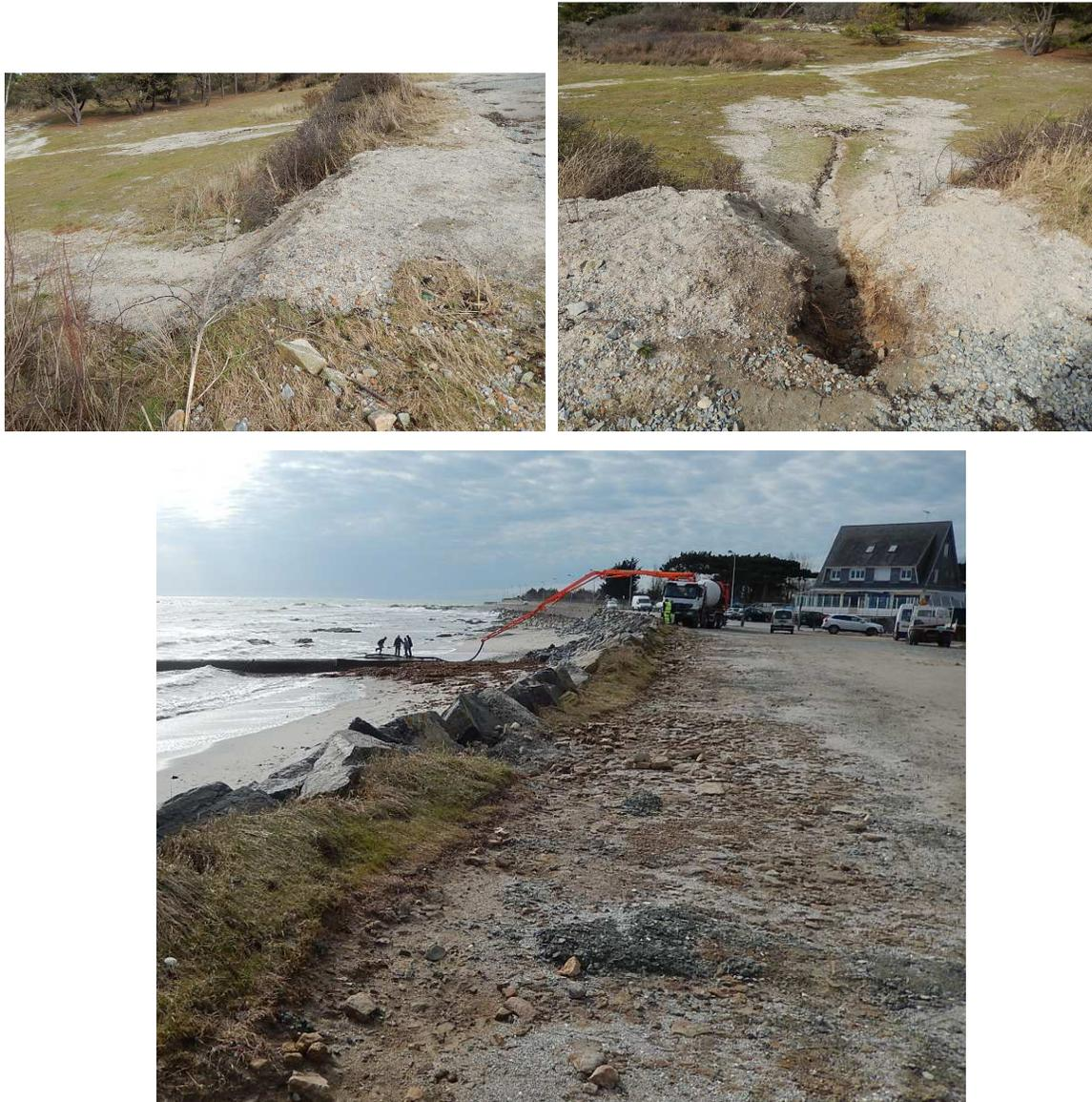
**Figure 89 : Traces de franchissements et d'écoulements sur le parking (photos Egis 24 février 2014)**
