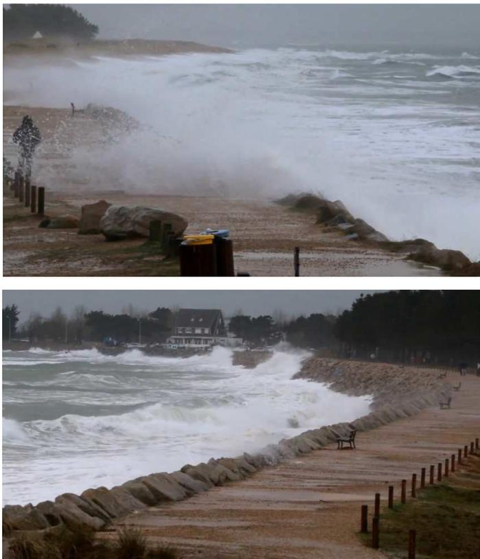
**Figure 94 : Phénomène de franchissement observé le 1<sup>er</sup> janvier 2014 sur les enrochements situés à l'est de la pointe de Moustierlin (capture sur vidéo [www.youtube.com](http://www.youtube.com))**
