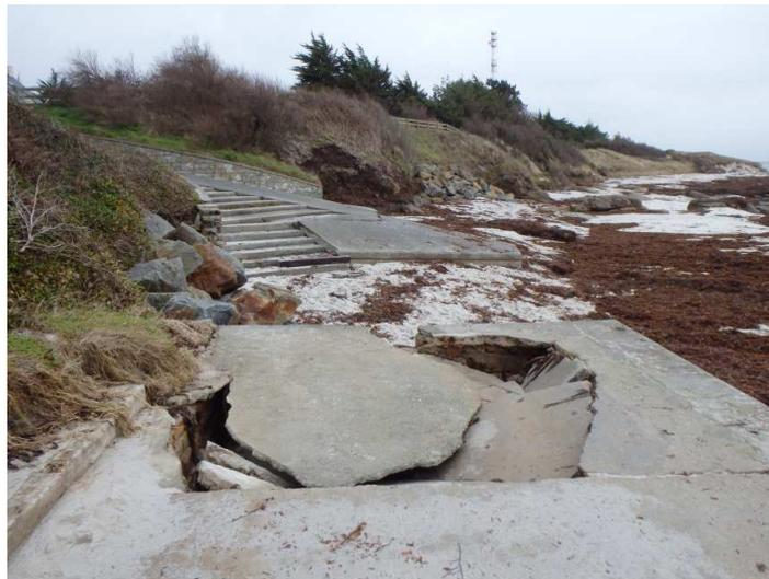
**Figure 82 : Dommages observés sur l'ouvrage présent plage des Dunes (photo Egis, 20 février 2014)**
