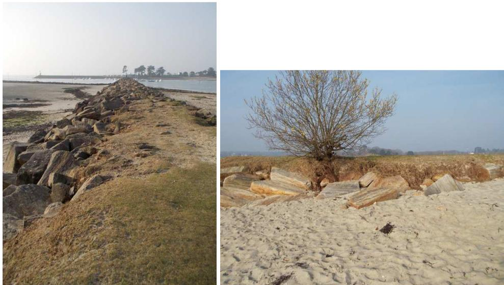
**Figure 111 : Dommages observés en tête de l'épi en enrochement situé à l'ouest de la plage de Keleven (photo Egis)**
