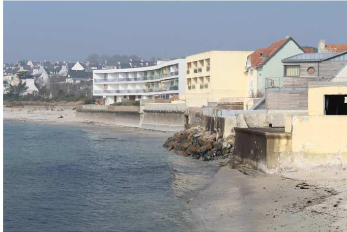
**Figure 128 : Enrochement provisoire mis en place au niveau de la plage des Sables Blancs (photo fournie par la Mairie)**
