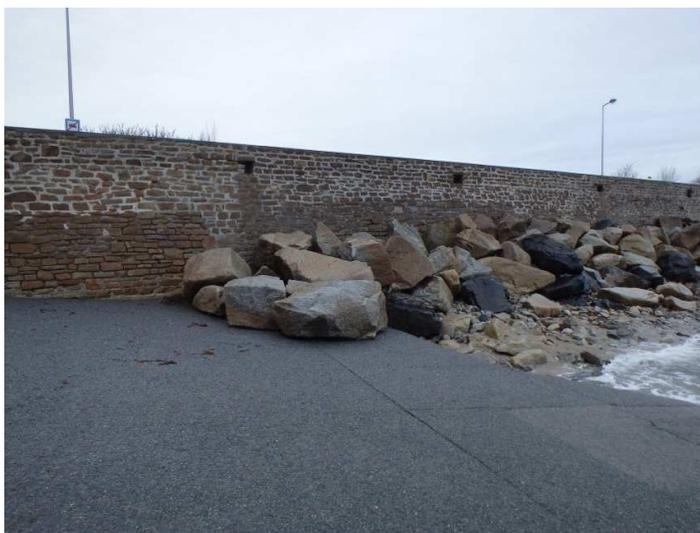
**Figure 95 : Dommages observés sur les enrochements de la corniche de la pointe de Moustierlin (photo Egis, 20 février 2014)**
