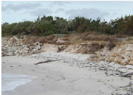
**Figure 96 : Erosion observée dans la dune de part et d'autre de l'enrochement situé au droit du monument aux fusillés (photos Egis, 20 et 24 février 2014)**
