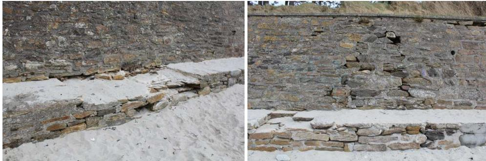
**Figure 137 : Dommages observés au niveau du mur de protection de la plage du Porzou (photo réalisée par la commune)**
