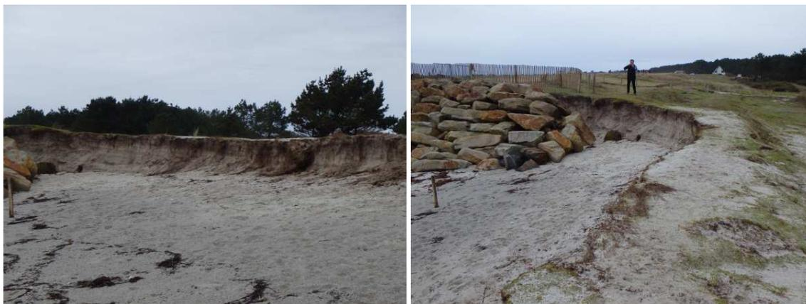
**Figure 84 : Erosion de la dune visible au droit de l'enrochement de la plage de Cleut Rouz (photo Egis, 20 février 2014)**
