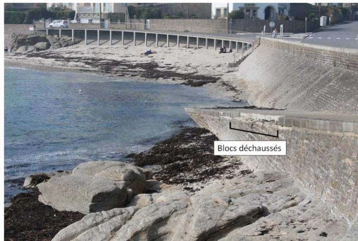
**Figure 135 : Déchaussement de blocs au niveau de la cale de la plage de Rodel (photo réalisée par la commune)**
