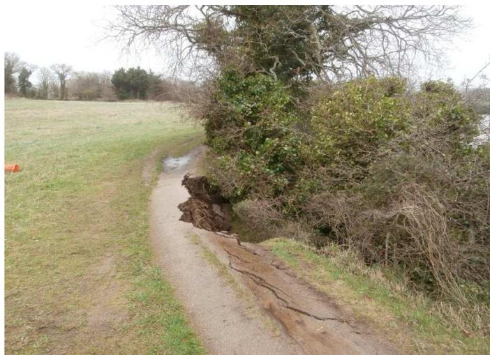
**Figure 142 : Effondrement le long du sentier au niveau de l'anse du Moulin de la Mer (photo réalisée par la commune)**
