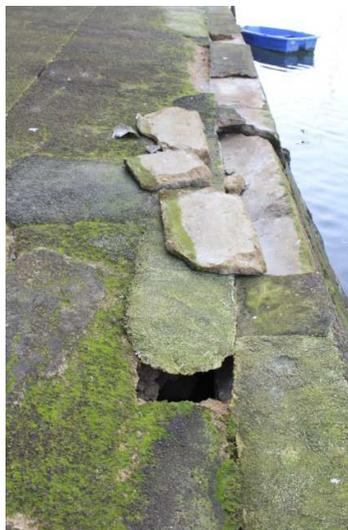
**Figure 136 : Dommages constatés sur le quai de la Ville Close, au droit de la porte au Vin (photo réalisée par la commune)**
