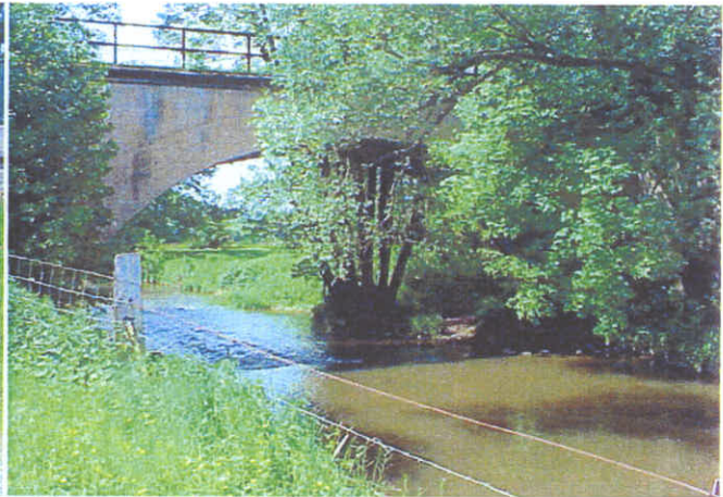
10 - ancien pont SNCF à Sormonne
