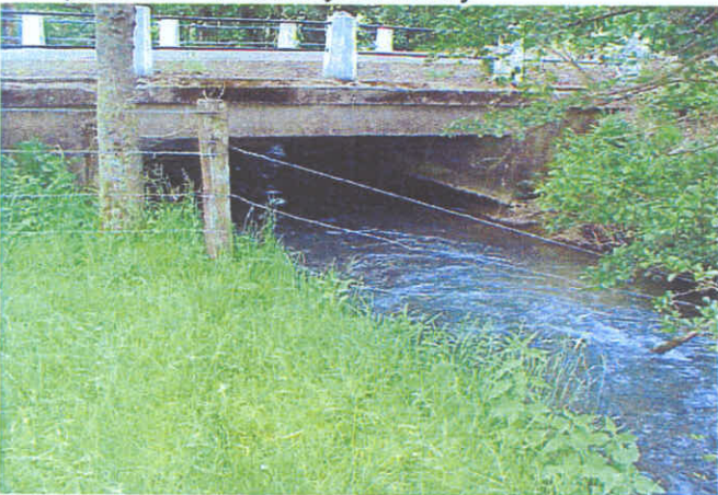
21 - Pont sur le Thin à Saint-Marcel
