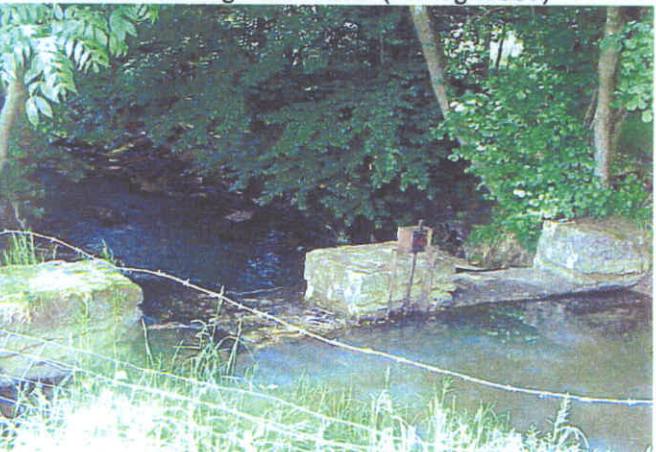
29 - Seuil sur le Charroué à Tournes
