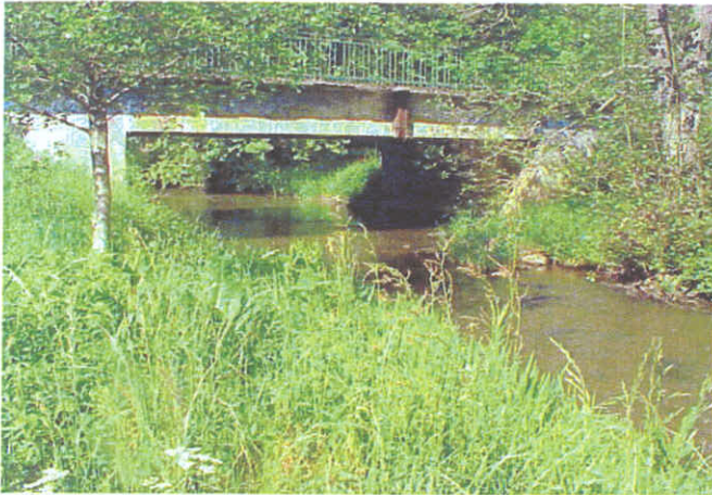
1 - pont sur la Sormonne à Chilly
