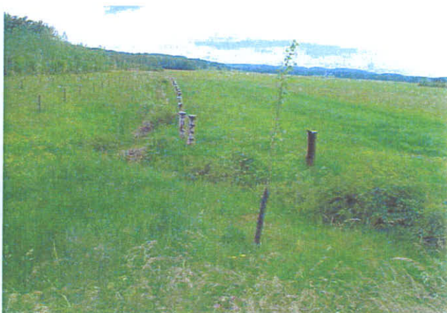
10 - drain d'amenée au pont D2 de décharge RD
