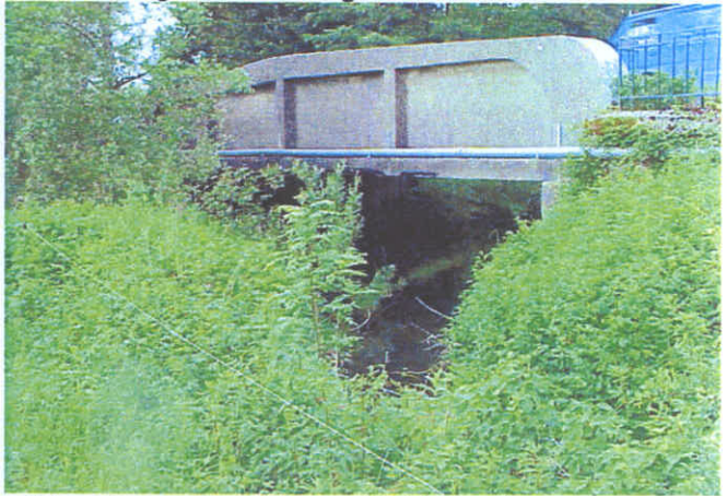
14 - ouvrage de décharge RG à Haudrecy
