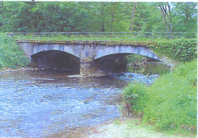
7 - pont sur la Sormonne à Murtin-Bogny
