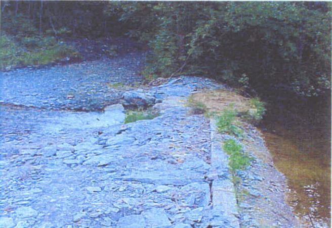
27 - Seuil de l'étang Pierka aval (Rimogneuse)
