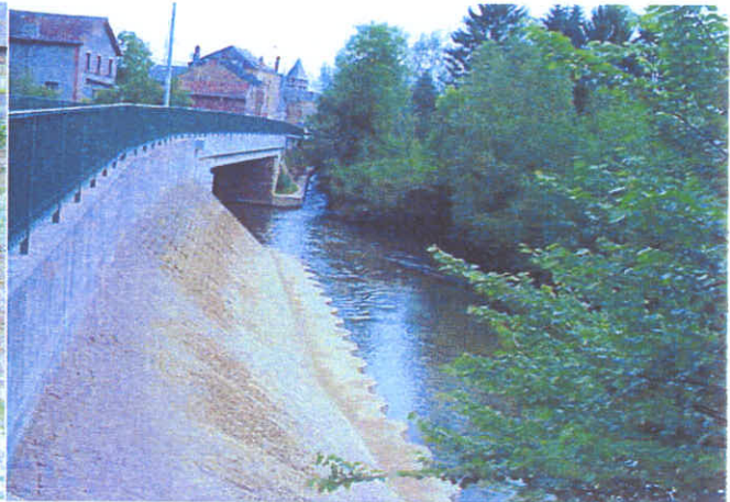
18 - pont sur la Sormonne à Warcq
