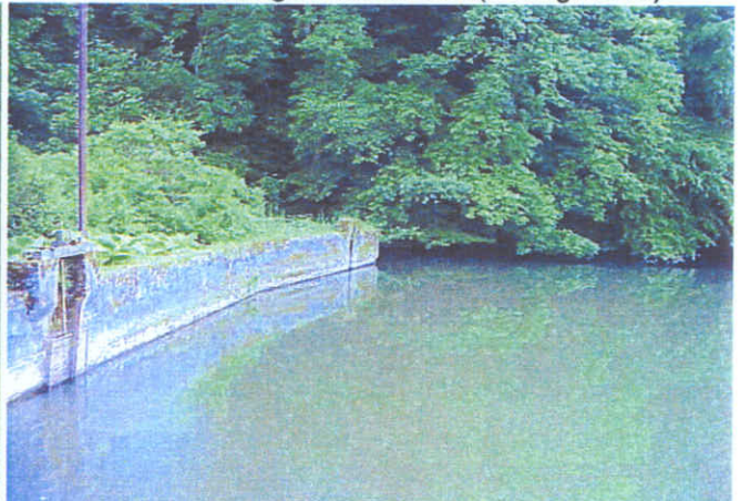
28 - Barrage sur la Rimogneuse (Châtelet)
