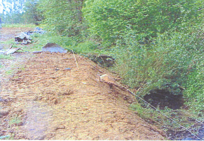
29 - remblai dans le ruisseau de Basigny à Cliron
