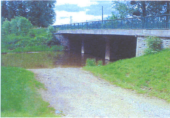
9 - pont D978 à Sormonne
