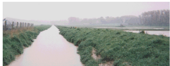
Figure 28 – Lèvre (sur le côté droit du lit) perchante le lit mineur avant le débordement
