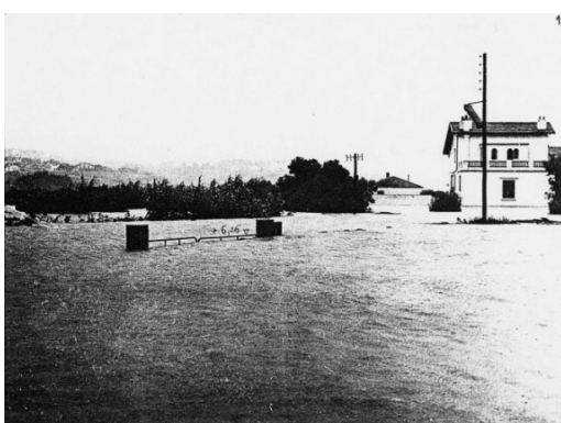
Figure 2 - débordement de l'Urabia à Bidart en bordure de la RN 10, 24 septembre 1959 (source: subdivision de l'équipement)
