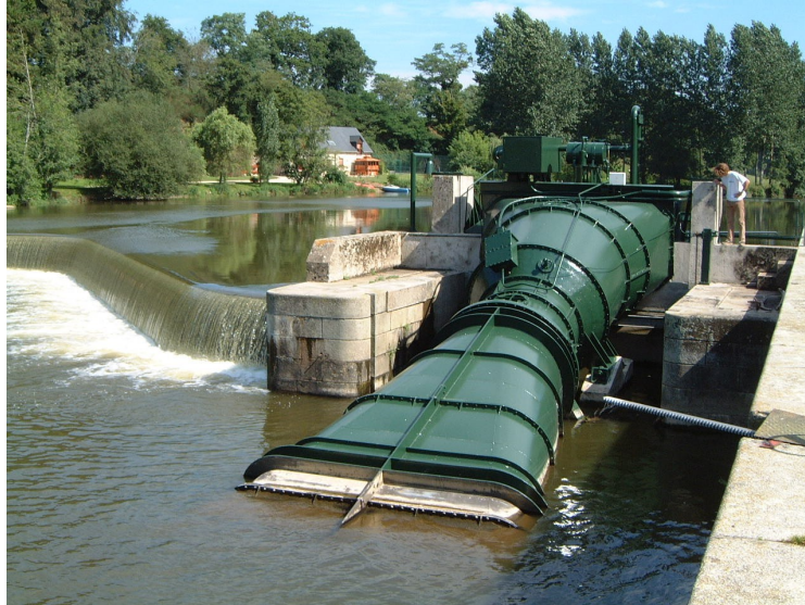
Figure 16 – Microcentrale sur la Mayenne (53 © photo DHI)
