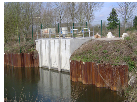
Figure 17 - Station de pompage sur la Somme à Abbeville (80)
