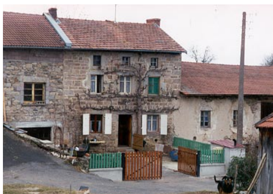
poirier palissé sur façade
