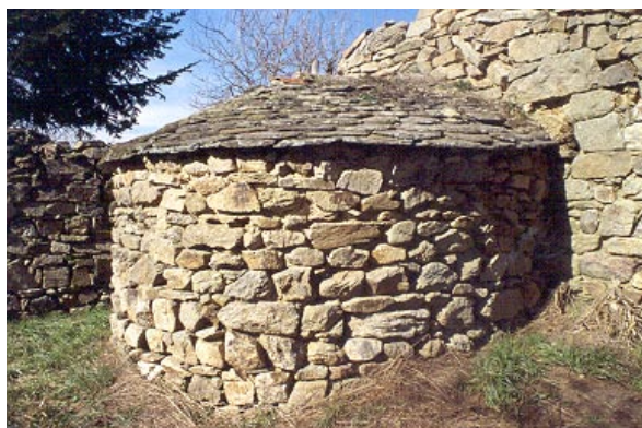
four traditionnel, accolé à la bâtisse
