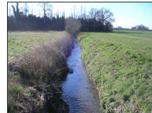
Section rectiligne du ruisseau du Prieuré
