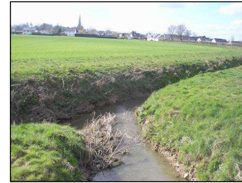
Le "ruisseau de La Gestière" avant sa confluence avec le ruisseau du Prieuré
