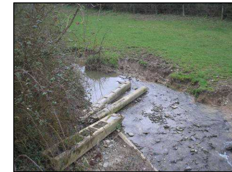
Passage bovin sur le ruisseau de La Mare Chartire La Mardelle (Bazougers)
