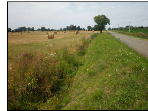
Fossé en bordure de route A fonction hydraulique
