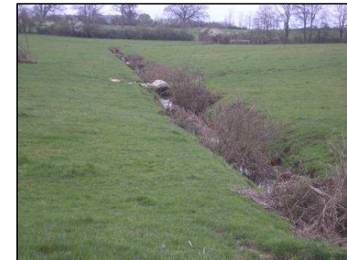
Section rectifiée du ruisseau de La Mare Chartier, Les Bourgonnières (Bazougers)
