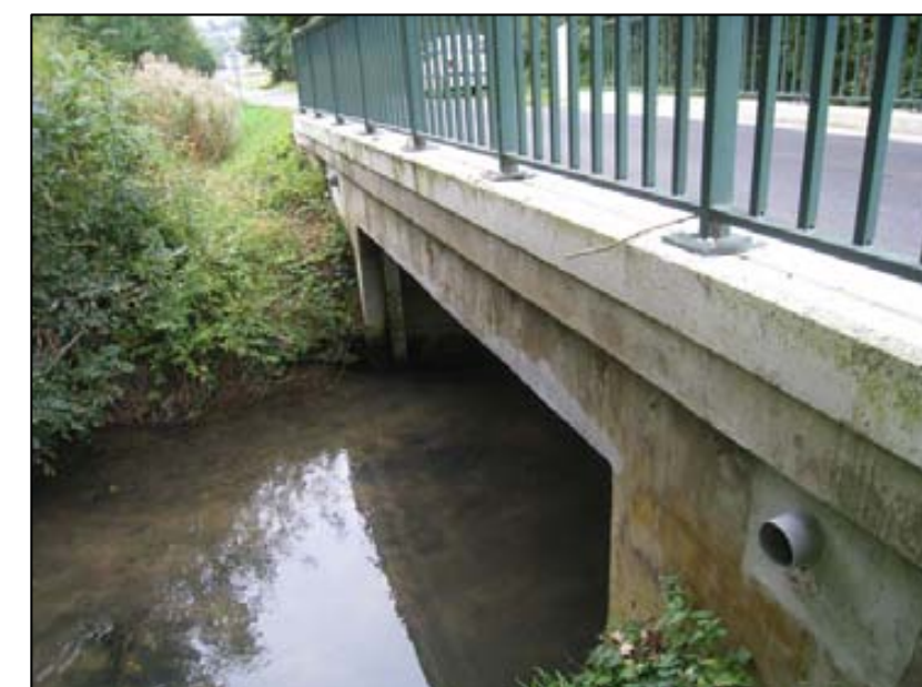
Photo 20 : Rétablissement du Thin sous la RD 9
