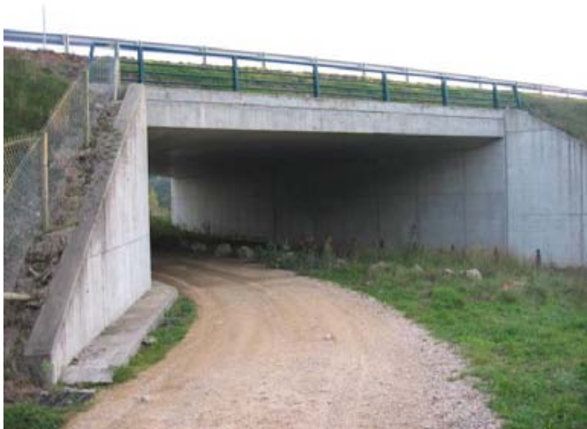
Photo 37 - Exemple d'ouvrage mixte agricole – grande faune (A89), cliché EGIS
