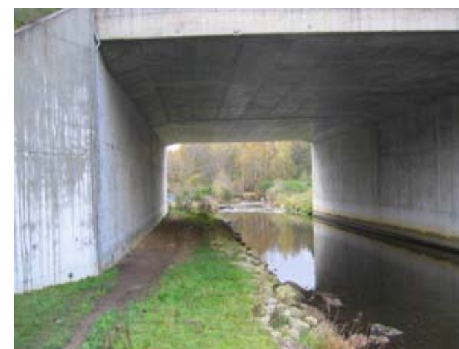
Photo 36 - Exemple d'ouvrage mixte hydraulique – grande faune (A89) avec banquette simple, cliché EGIS
