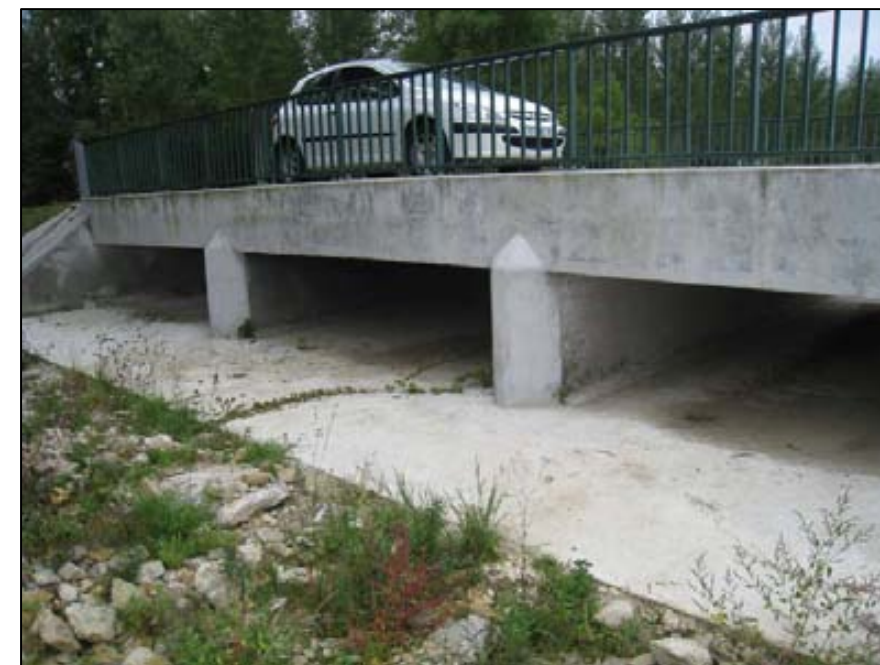
Photo 24 : Ouvrage de décharge sous la RD 2
