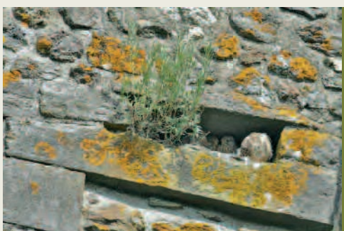
Vieux mur occupé par une famille de Faucons crécerelle
