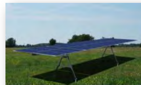
Figure 5 : Exemple tracker en position plane (soleil au zénith).
