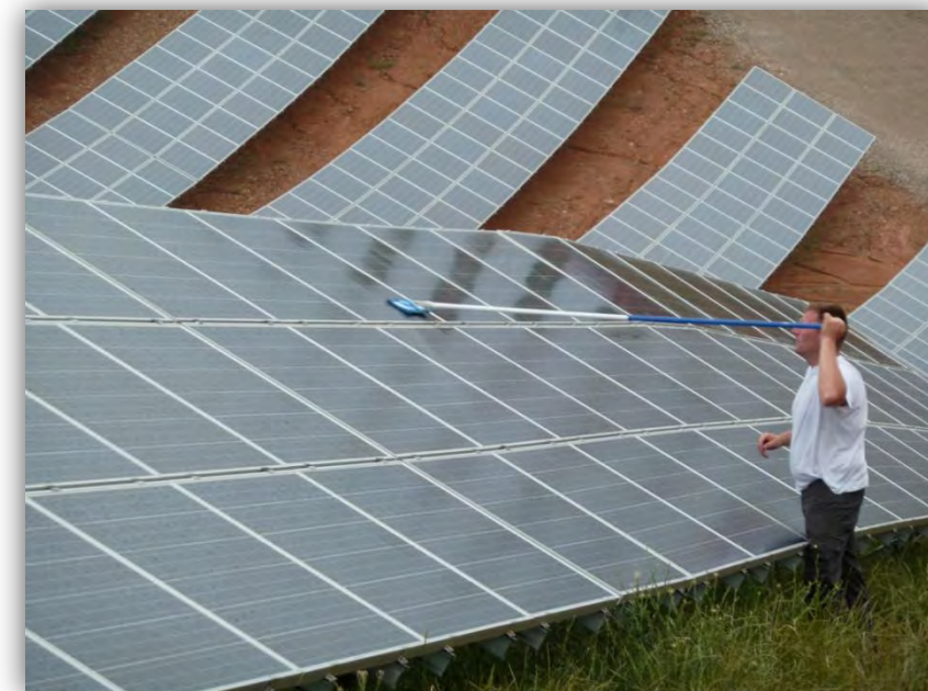
Figure 8 : Nettoyage des panneaux de la centrale des Mées au chiffon doux et à l'eau minérale
