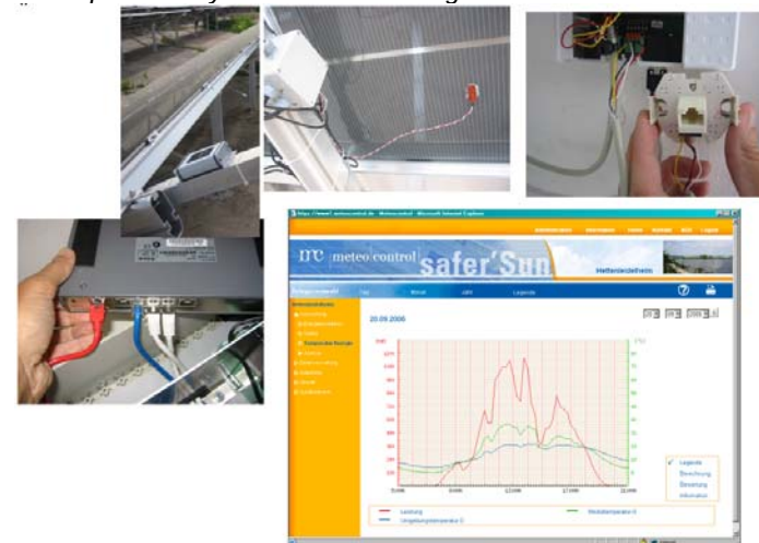
Figure 3: Mise en place du système de monitoring
