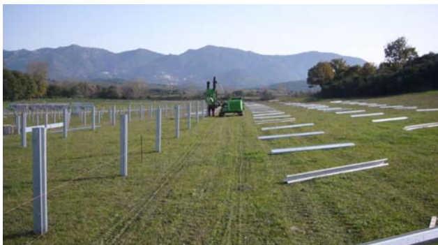
Photo 4 : Exemple de mise en place de pieux battus
