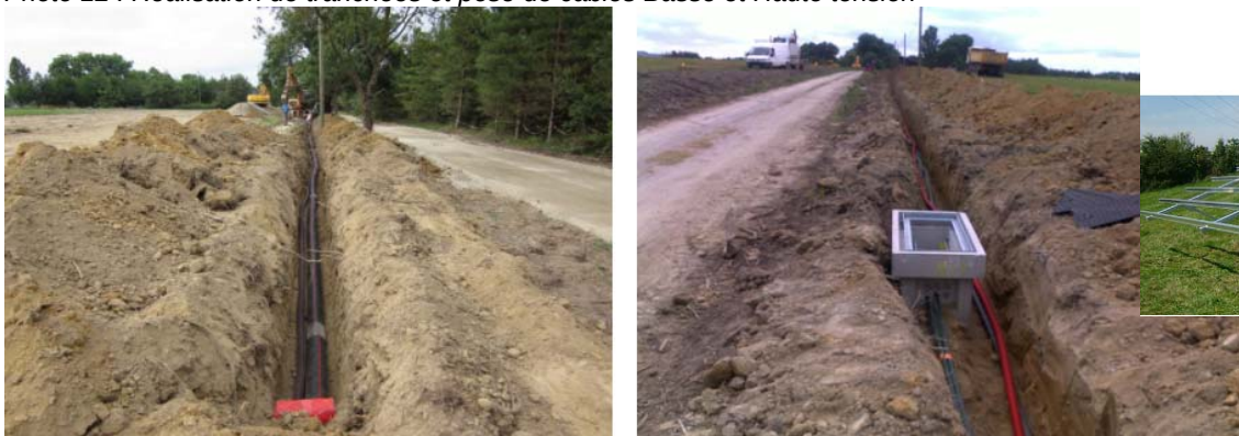
Photo 12 : Réalisation de tranchées et pose de câbles Basse et Haute tension
