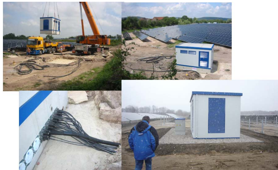
Photo 17: Raccordement de câbles solaires en coffret électriques (boîtes de jonction) et inspection
