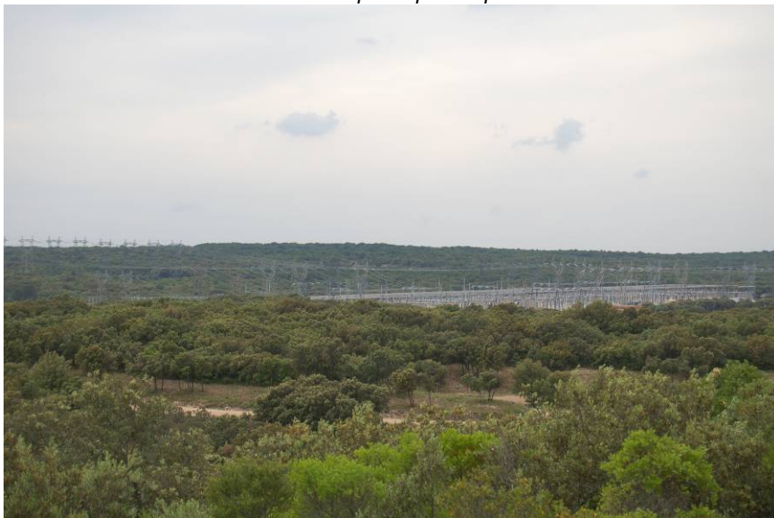
Photo 24 : Vue sur la centrale électrique depuis la piste DFCI Y14
