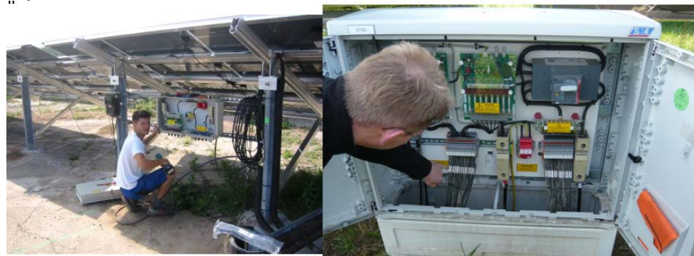
Photo 17: Raccordement de câbles solaires en coffret électriques (boîtes de jonction) et inspection
