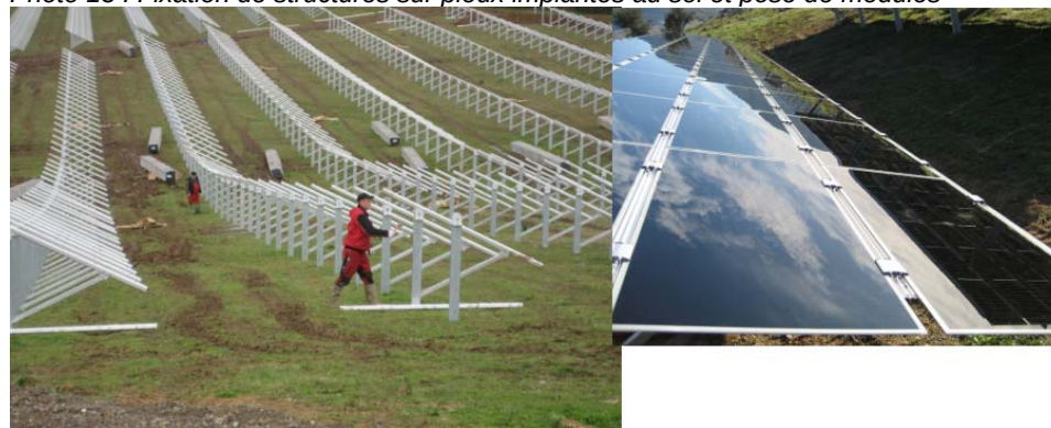
Photo 14 : Pose des tables photovoltaïques
