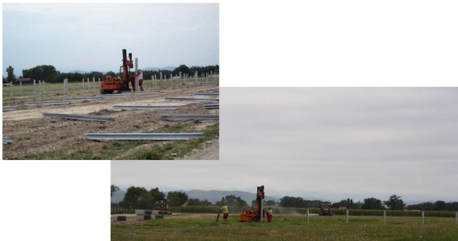
Photo 11 : Piquetage et positionnement des pieux
