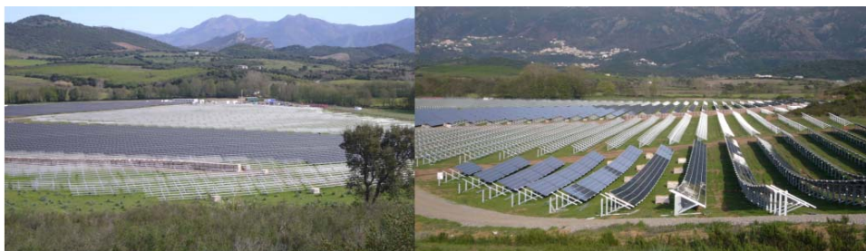
Photo 15 : Pose des tables photovoltaïques (2)
