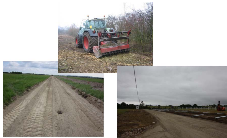
Terrassement et réalisation des pistes d'accès
