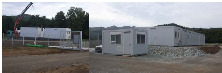
Photo 10 : Mise en place des installations de chantier
