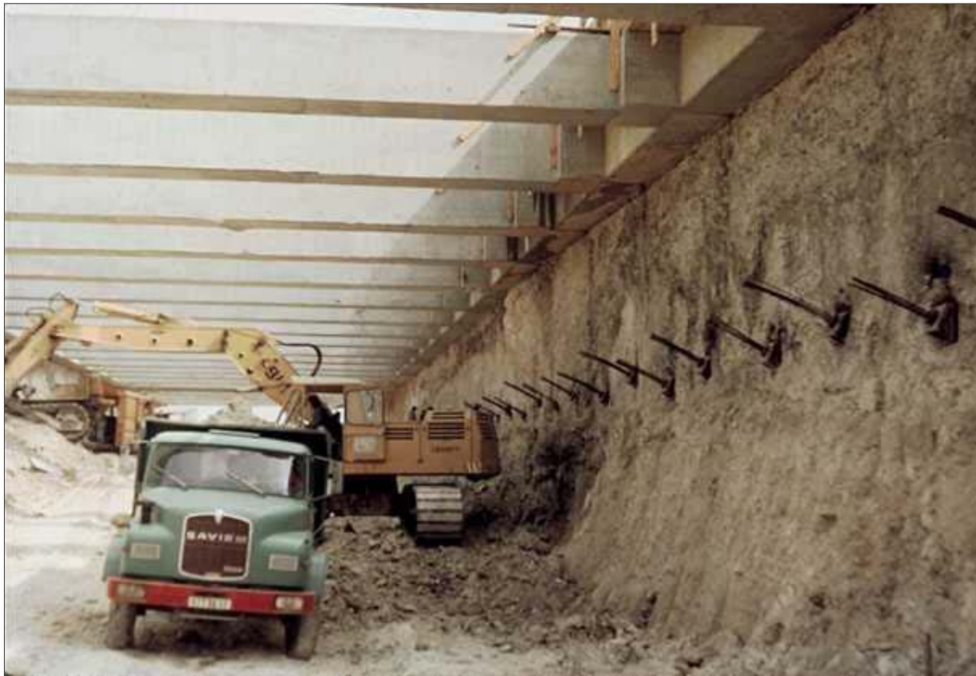
Paroi ancrée par des tirants précontraints et butonnée Excavation devant la paroi
