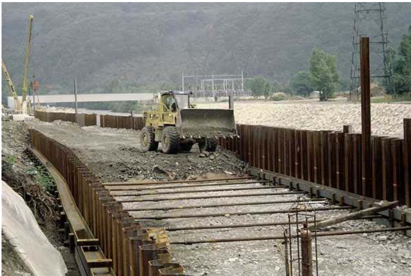
Remblaiement sur un lit de tirants d'ancrage passifs
