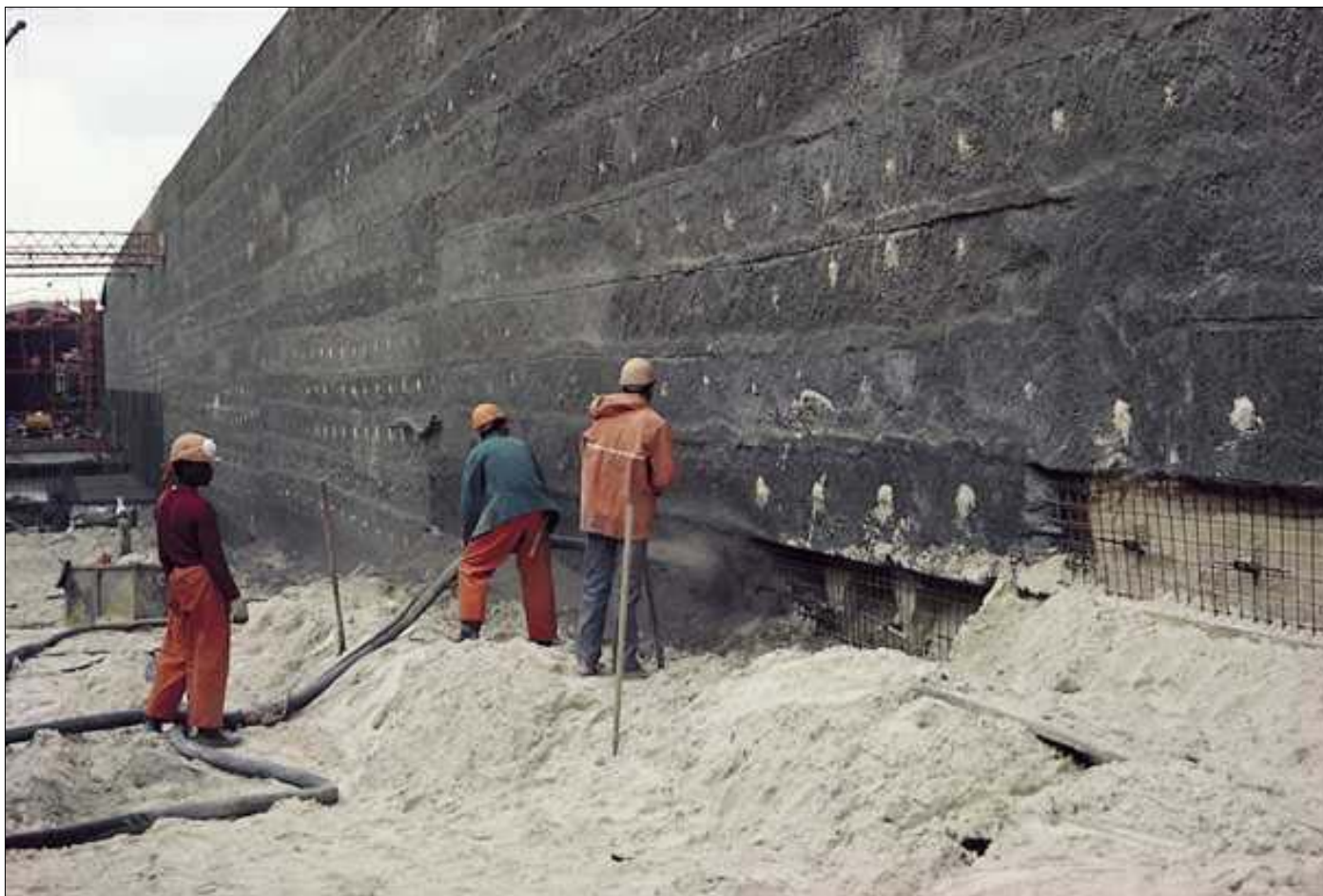
Projection du béton sur nappes de treillis soudé
