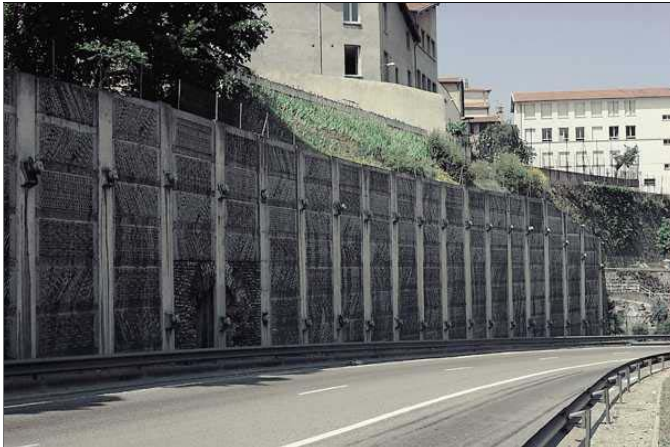
Paroi parisienne ancrée par des tirants précontraints
