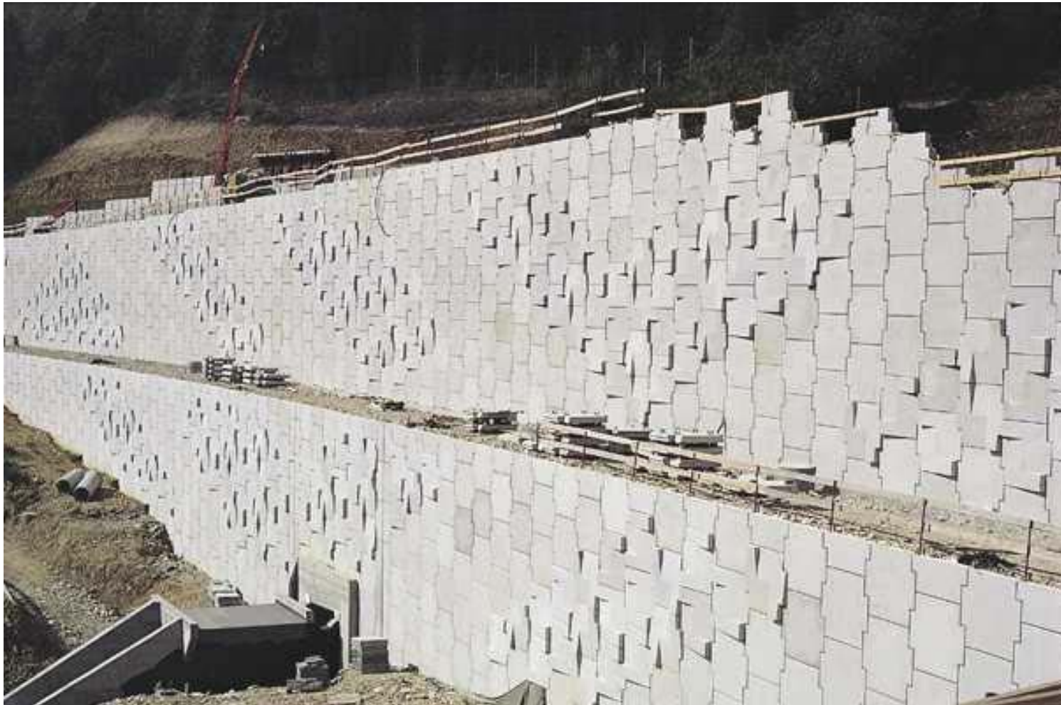
Procédé Terre Armée disposé en gradins
