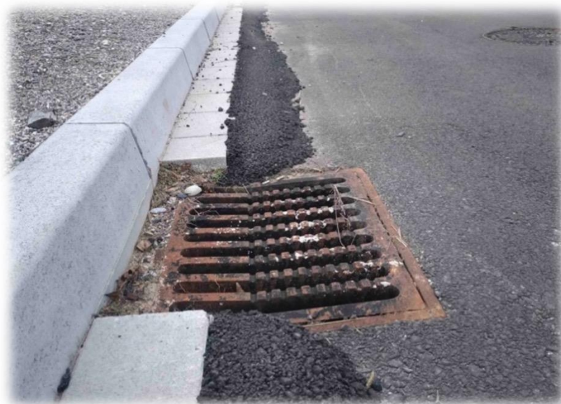
Figure 5 : vue d'un avaloir non adapté aux amphibiens et source d'une mortalité accrue. AdT, Holtzheim, novembre 2018.
