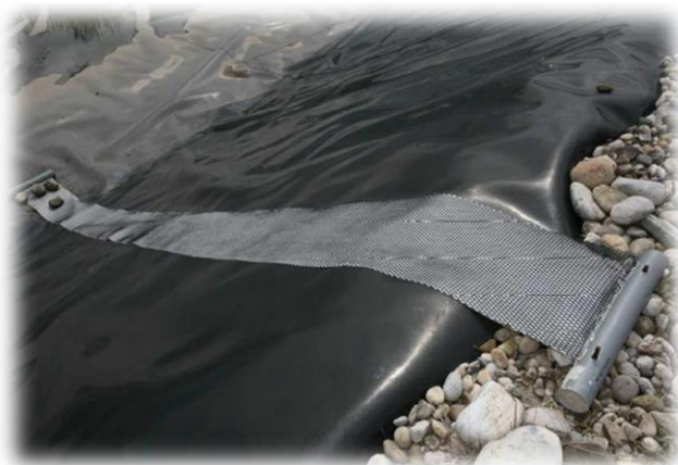
Figure 13 : vue sur le dispositif en géomembranes au sein des bassins échappatoires, Photo extraite du guide « Neutraliser les pièges mortels pour la faune sauvage » réalisé par le Conseil Général de l'Isère.
