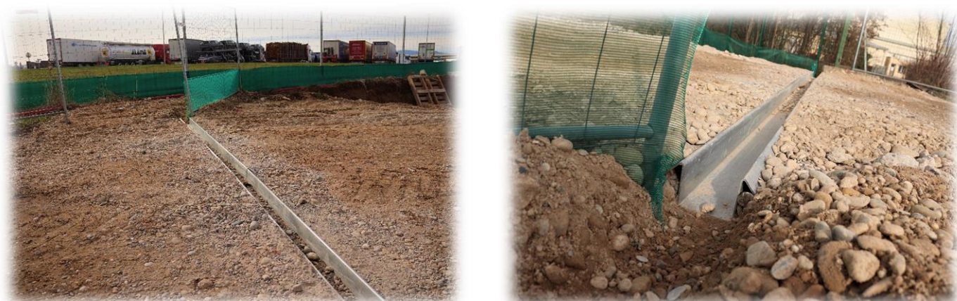
Figure 8 : vues sur le caniveau mis en place sur DUPPI 1. AdT, Duppigheim, février 2024.
