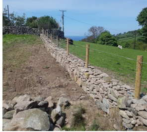
▲ Muret en pierre sèche, muret et clôture (piquet bois et grillage à moutons), ganivelle, poteau bois et fils en acier galvanisé.
