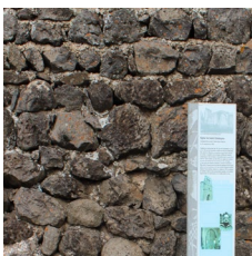
Moellons de basalte liés à la chaux
