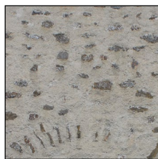
Enduit à « joints beurrés »
