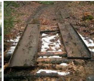
Franchissement de cours d'eau en utilisant des passerelles aciers.
