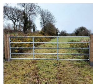
▲ Barre pivotante, se referme automatiquement, portail en acier galvanisé, se referme automatiquement, enjambement en acier galvanisé.
