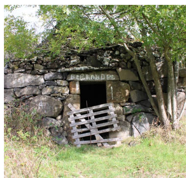
▲ Éviter le développement de la végétation sur les murs. Éviter les matériaux exogènes (traverses), les enrochements avec blocs de pierre disproportionnés, les joints au ciment visibles, les parpaings...
