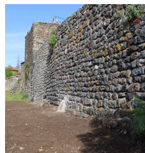
▲ Murs de soutènement plus importants renforcés par un liant à la chaux permettant un transfert d'humidité
