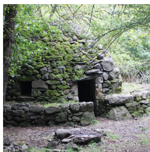
▲ Murs de soutènement plus importants renforcés par un liant à la chaux permettant un transfert d'humidité
