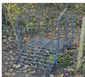
▲ Barre pivotante, se referme automatiquement, portail en acier galvanisé, se referme automatiquement, enjambement en acier galvanisé.
