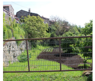
▲ Muret en pierre sèche, muret et clôture (piquet bois et grillage à moutons), ganivelle, poteau bois et fils en acier galvanisé.
