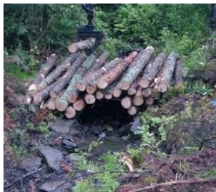
Franchissement de cours d'eau en utilisant les troncs du site et des buses hydrauliques.
