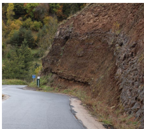
▲ Profilé prégnant et peu qualitatif, accotement imperméabilisé empêchant une couverture végétale, bordure béton et glissière de sécurité métallique.
