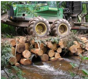
Franchissement de cours d'eau en utilisant les troncs du site et des buses hydrauliques.
