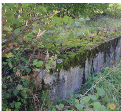
▲ Éviter le développement de la végétation sur les murs. Éviter les matériaux exogènes (traverses), les enrochements avec blocs de pierre disproportionnés, les joints au ciment visibles, les parpaings...
