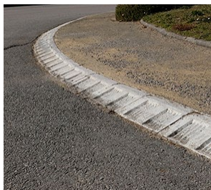
▲ Profilé prégnant et peu qualitatif, accotement imperméabilisé empêchant une couverture végétale, bordure béton et glissière de sécurité métallique.
