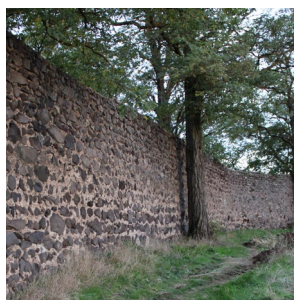
▲ Murs de soutènement plus importants renforcés par un liant à la chaux permettant un transfert d'humidité
