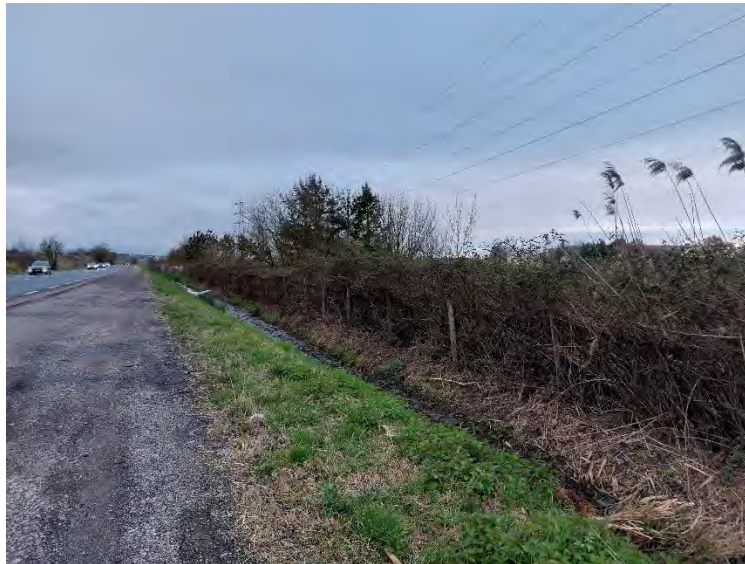
Grillage entre le fossé et la réserve écologique des Barails (Artelia, 2022)
