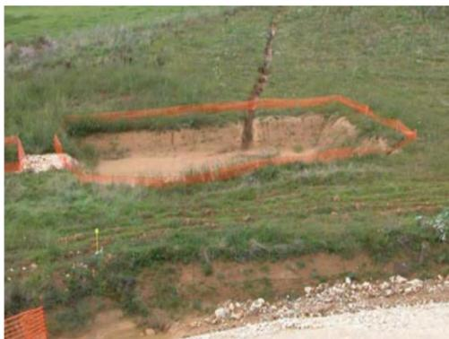
Figure 7: Exemple de fossé de collecte des eaux de chantier à faible pente (CEREMA 2015)
