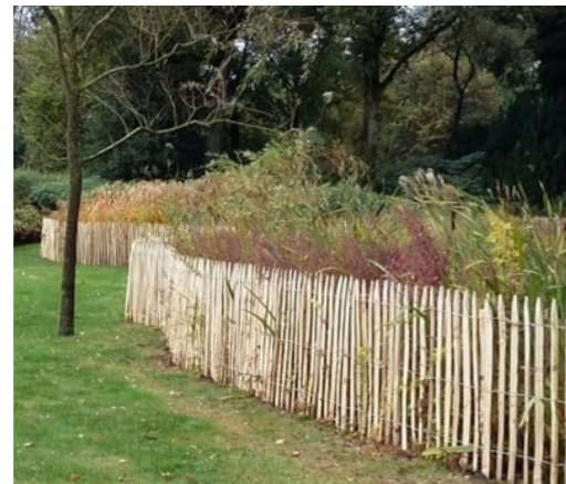
Exemple de système de protection des formations végétales - Ganivelles hautes 120 cm
