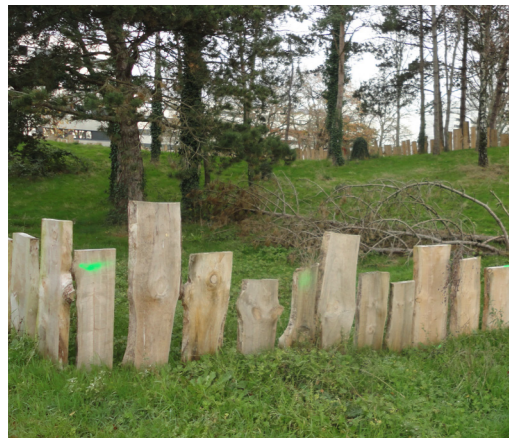
Exemple de système de protection des formations végétales - Pieux bois (réutilisation du bois insitu)
