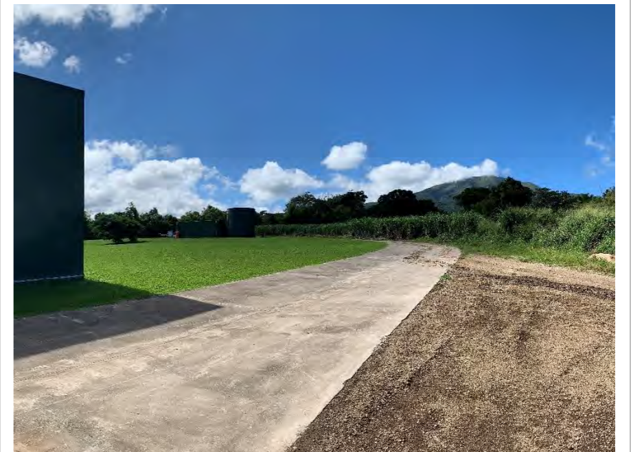
Figure 48 : Prise de vue n°6 – Vue sur les pelouses rases (à gauche) et les zones récemment remaniées dans le cadre de la construction du chai n°3
