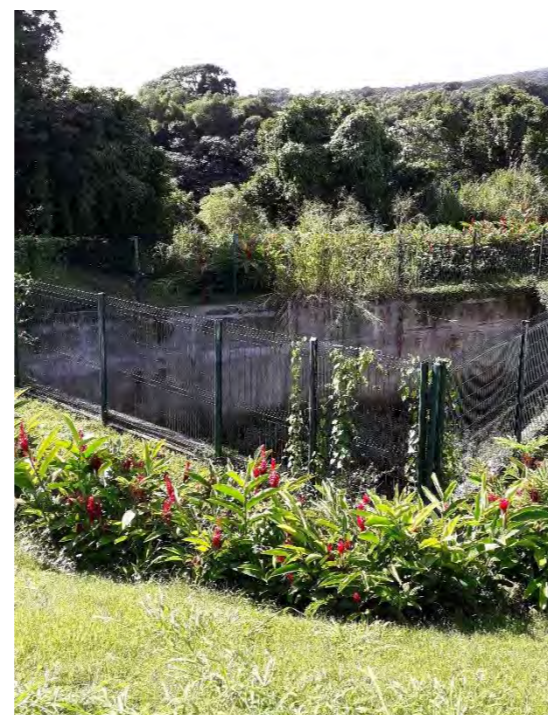
Figure 33 : Photographie du bassin incendie actuel
