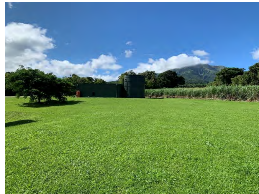
Figure 47 : Prise de vue n°5 – Vue depuis le sud des installations existantes sur les espaces en herbe
