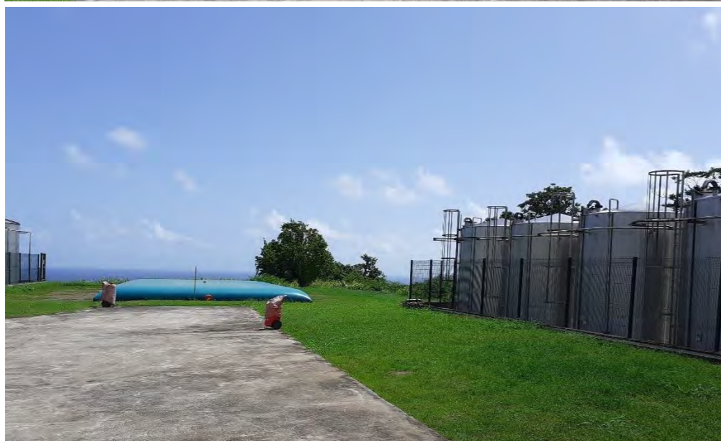
Figure 78 : Ouvertures visuelles sur l'océan Atlantique depuis les zones de cuverie au nord-est de la parcelle de projet (Source : SUEZ CONSULTING)
