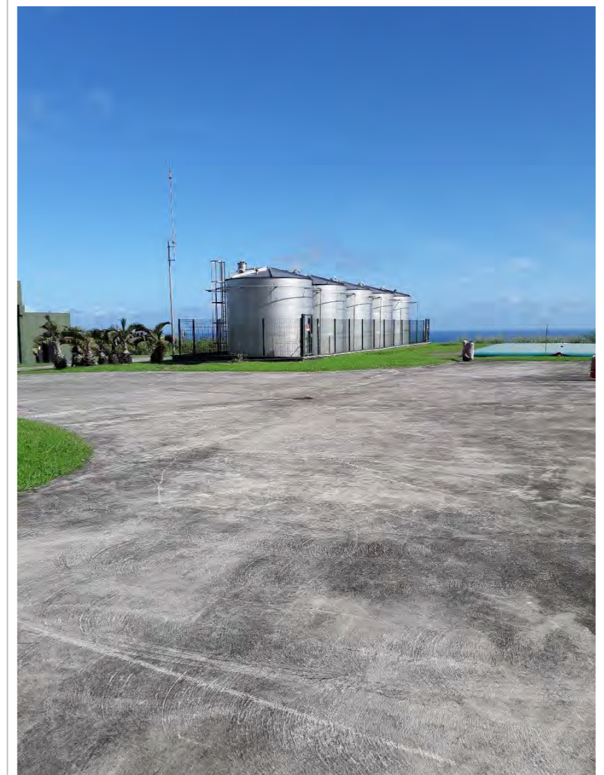
Figure 55 : Prise de vue n°12 – Vue depuis le nord-est de l'aire d'étude sur les constructions existantes (zones de cuveries)
