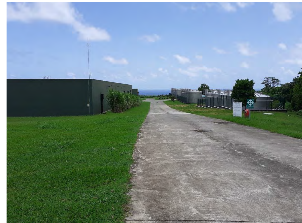
Figure 52 : Prise de vue n°9 – Voiries, bâtiments et zones de cuverie
