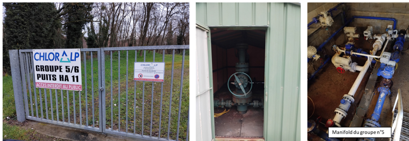
Photographie du site, puits d'exploitation HA11
