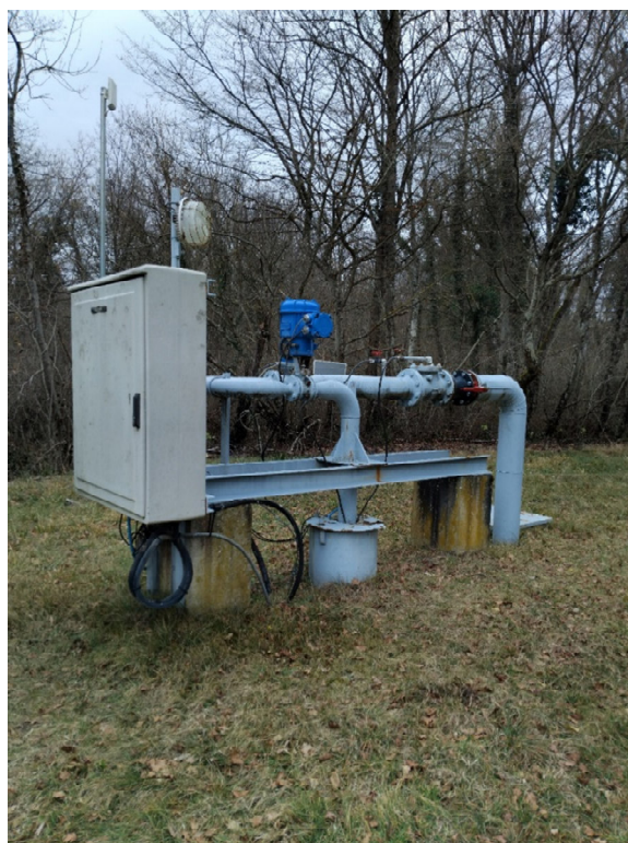
Photographie du site, forage T4
