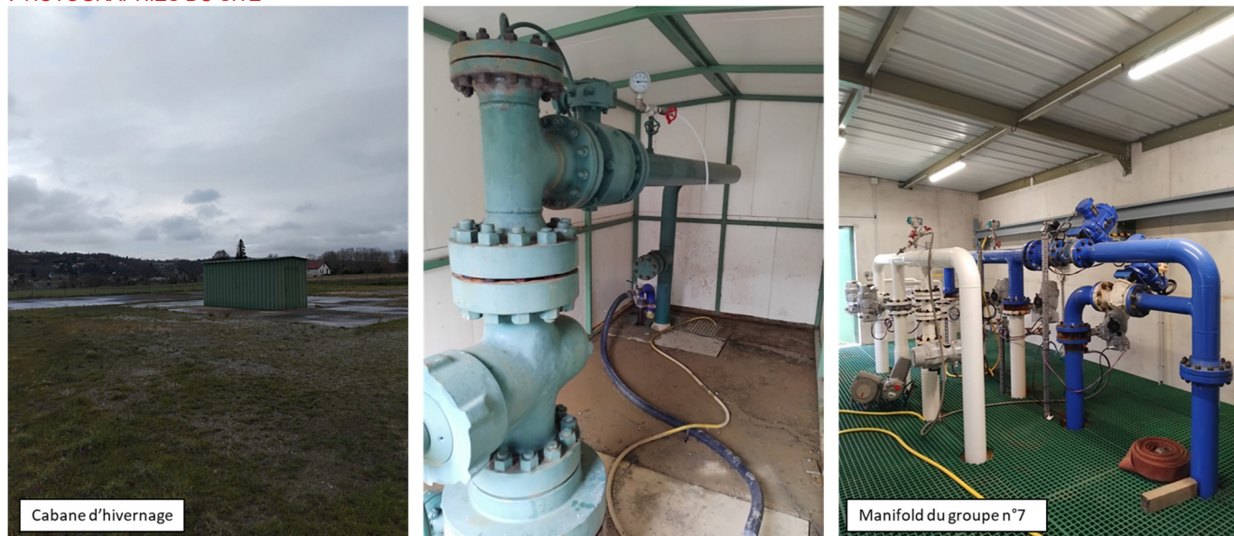
Photographie du site, puits d'exploitation HA14
