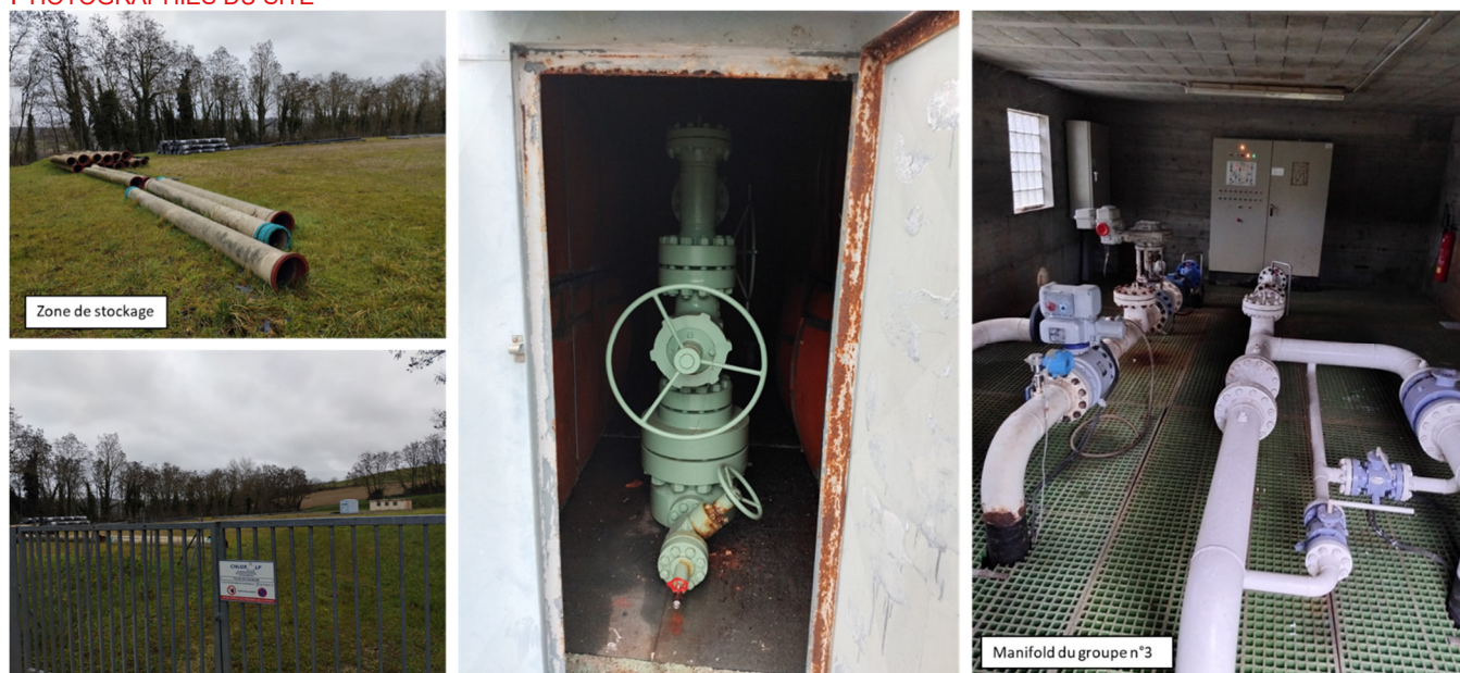
Photographie du site, puits d'exploitation HA12
