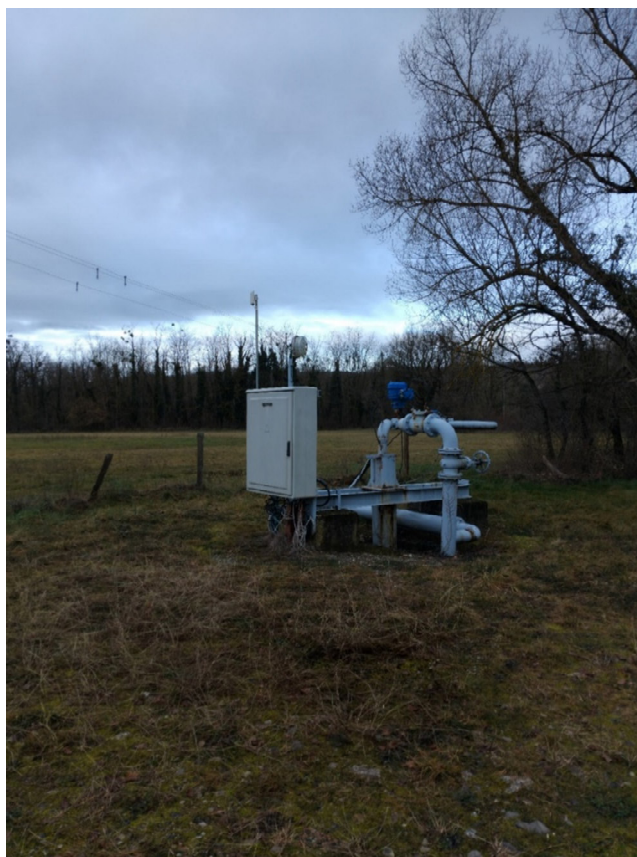
Photographie du site, forage T1
