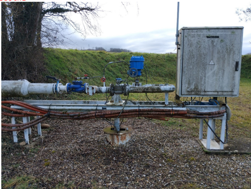
Photographie du site, forage T13
