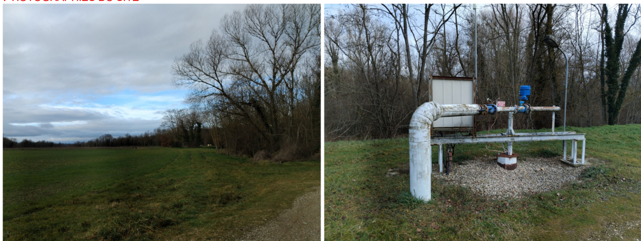
Photographie du site, forage T14
