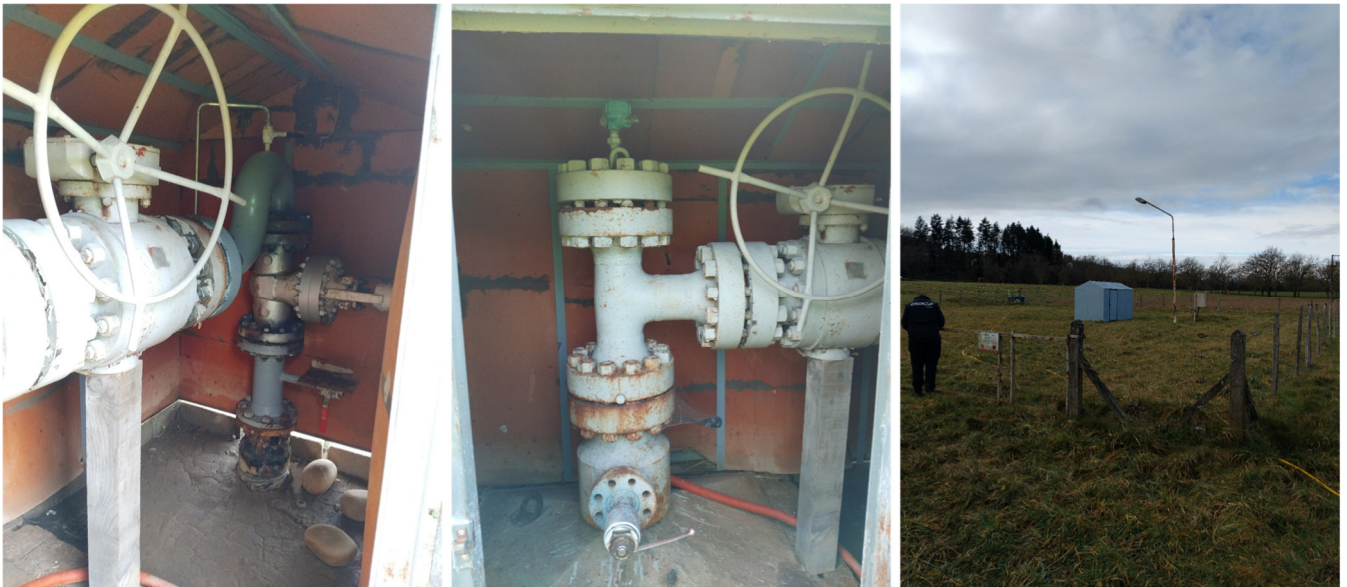
Photographie du site, puits d'exploitation HA5
