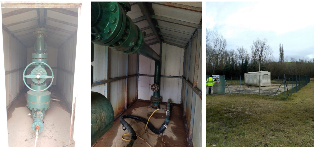
Photographie du site, Puits d'exploitation HA10
