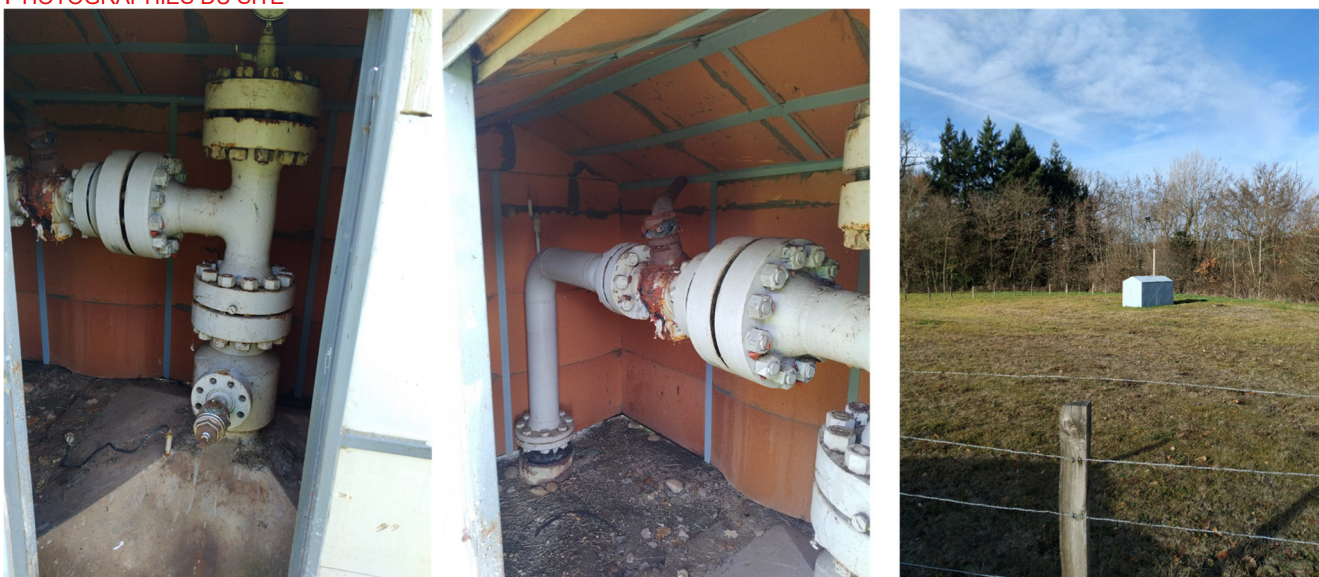
Photographie du site, puits d'exploitation HA4
