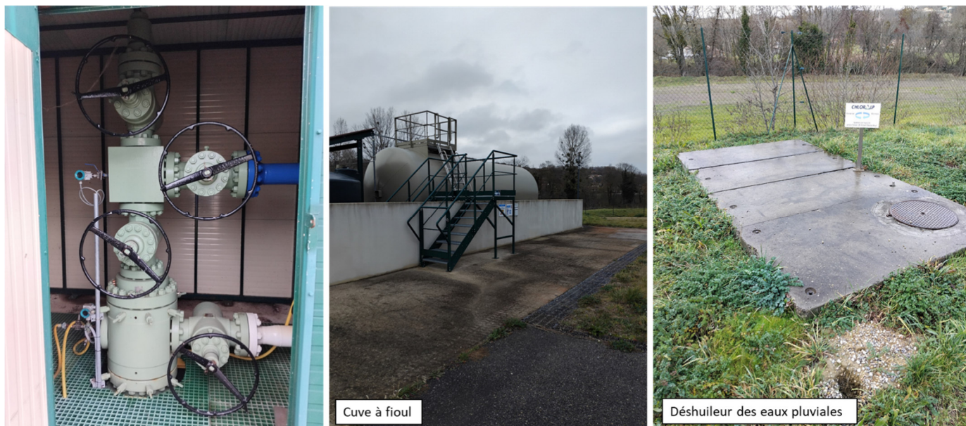
Photographie du site, puits d'exploitation HA15
