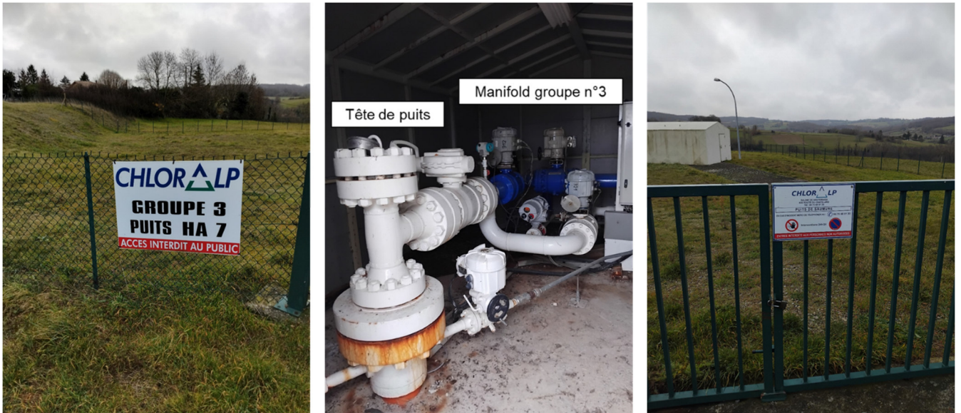
Photographie du site, puits d'exploitation HA7
