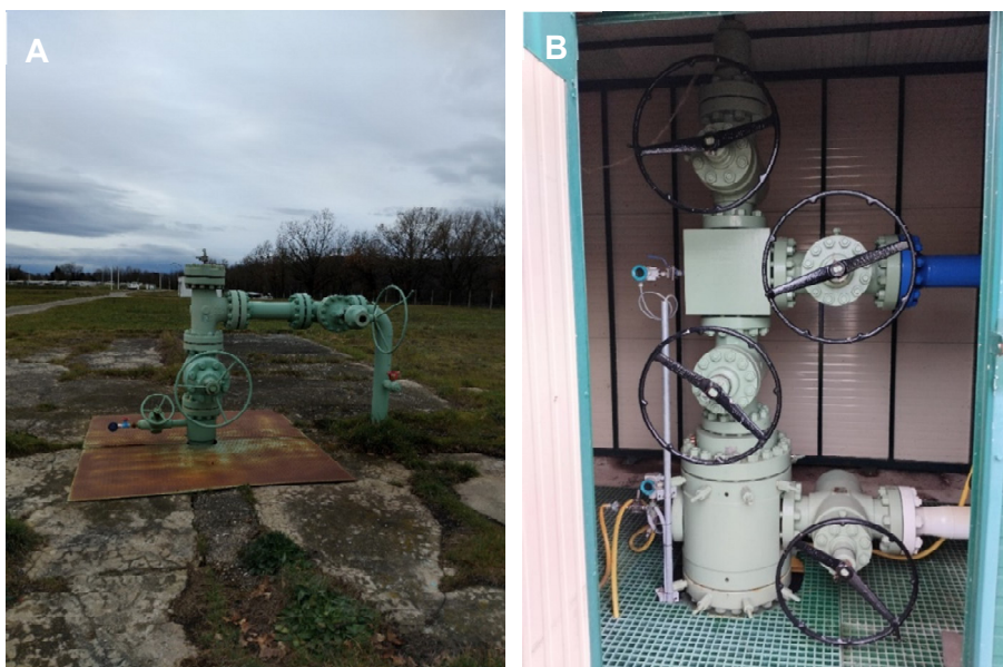
Photographies de deux têtes de puits (A : HA3 ; B : HA15)
