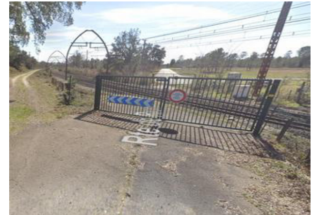
Etat de l'accès côté V1
