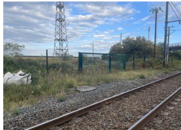
Etat actuel de l'accès côté V2
