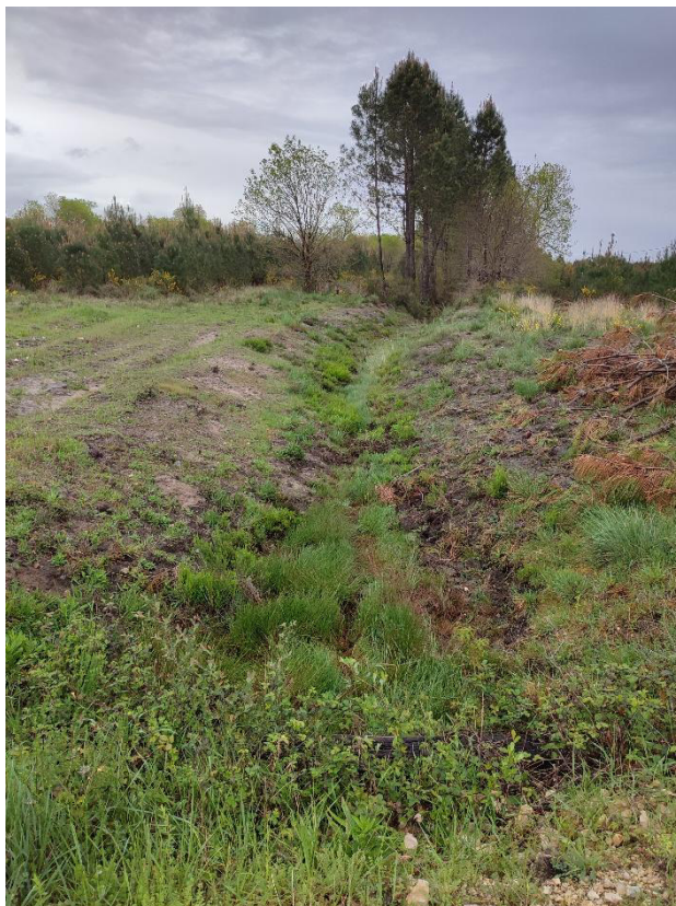
Photo 7 : Prairie humide en fond de fossé – PK 105+559 (voie 1) – 15/04/2025 ©AMOnia environnement
