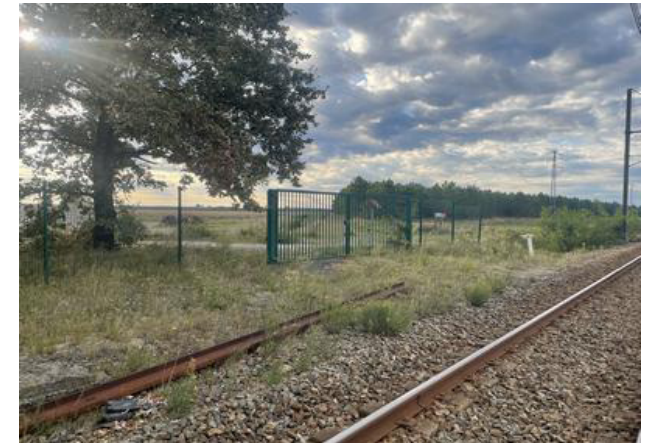
Etat actuel de l'accès côté V1
