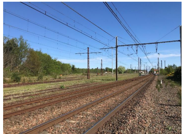
Photo 24 : Rails ©AMOnia environnement, 18/04/2025
