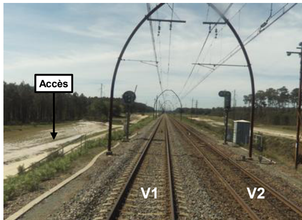
Vue de l'accès depuis les voies (vue vers Dax)
