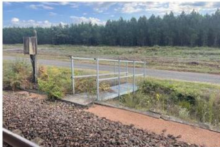
Figure 12 : Exemple de passerelle piétonne existante au PK 106+660 (Source : SNCF Réseau)
