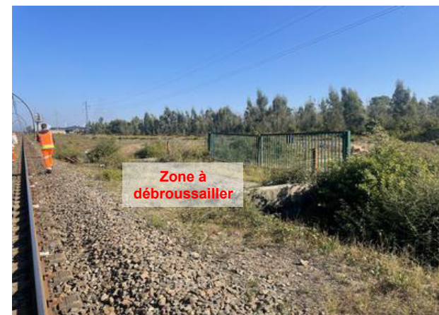
Vue de l'accès côté V1
