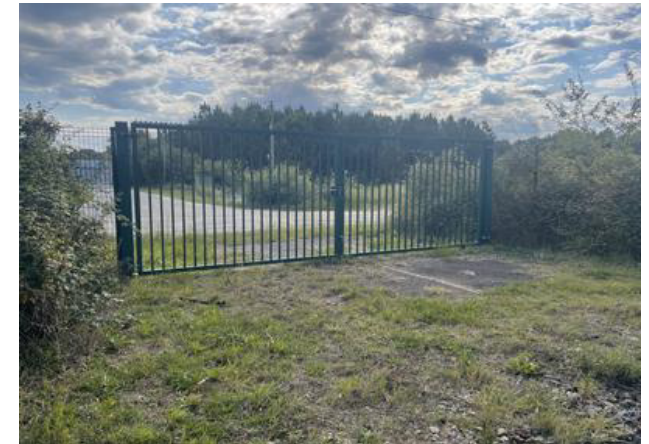
Etat actuel de l'accès côté V1
