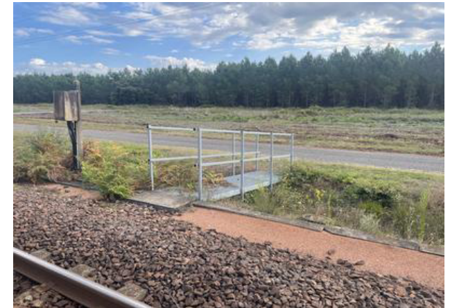
Etat actuel de l'accès côté V1
