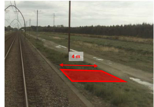
Rampe piéton à aménager
