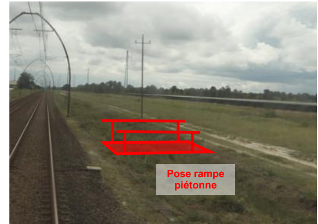
Pose d'une rampe piétonne de franchissement
