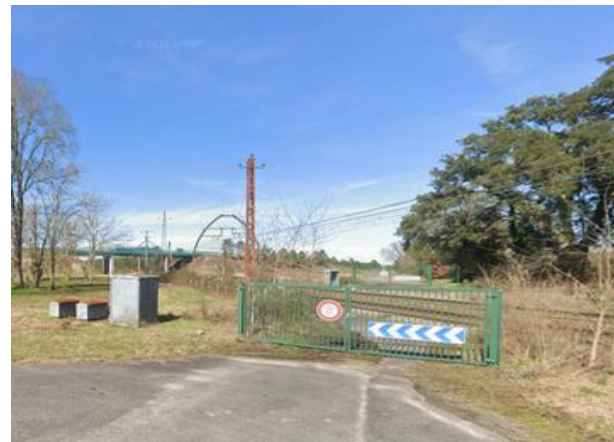
Etat de l'accès côté V2
