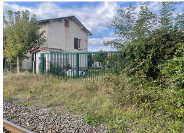
Etat actuel de l'accès côté V2
