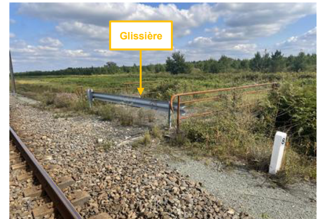
Accès côté V1
