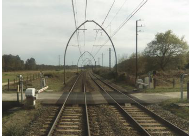
Vue de l'accès depuis les voies (vue vers Dax)
