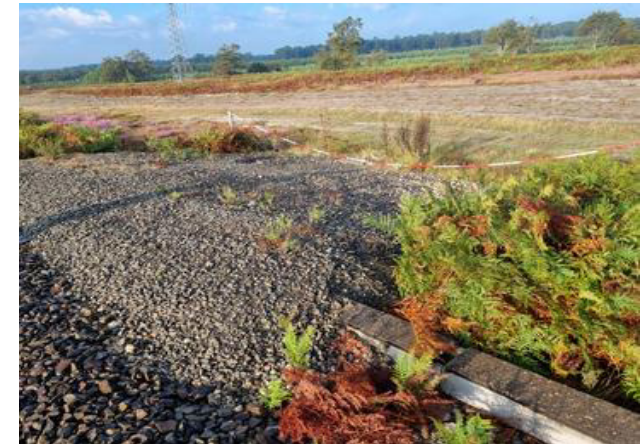
Etat actuel de l'accès
