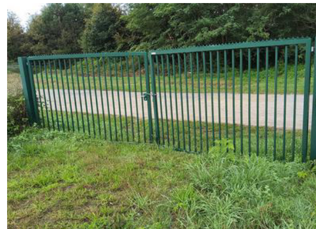
Portail en bon état
