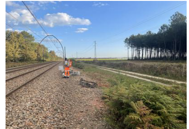
Etat actuel de l'accès
