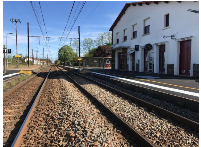
Photo 22 : Gare de Labouheyre ©AMOnia environnement, 18/04/2025
