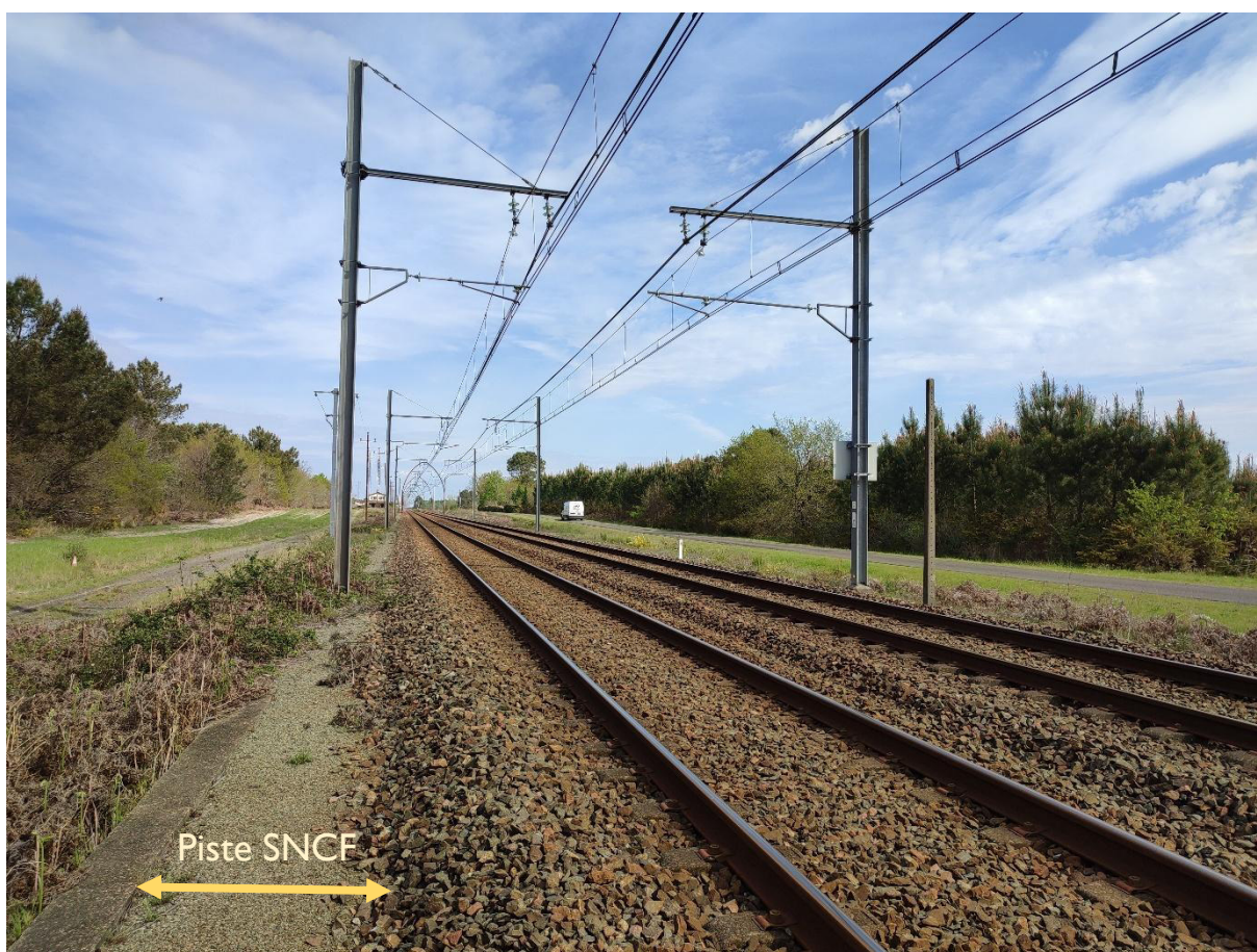
Figure 14 : Exemple de plateforme SNCF avec piste et voies ferroviaires ©AMOnia environnement
