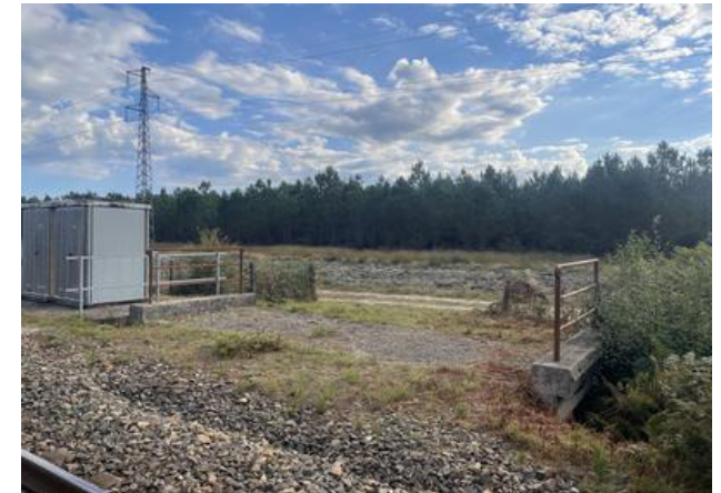
Etat actuel de l'accès côté V1
