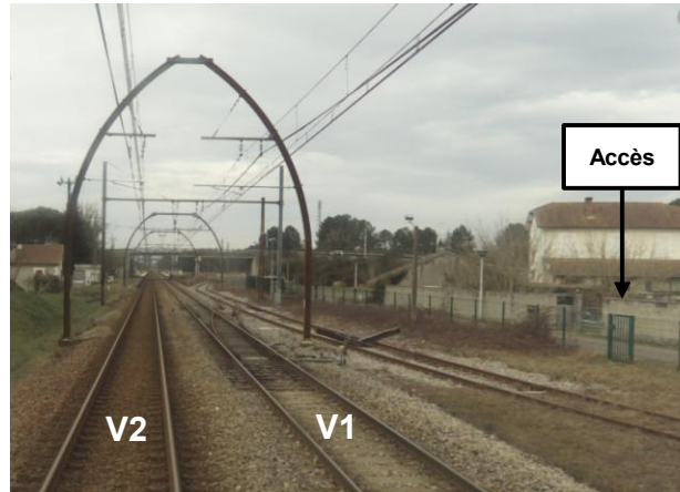
Vue de l'accès depuis les voies (vue vers Ychoux)
