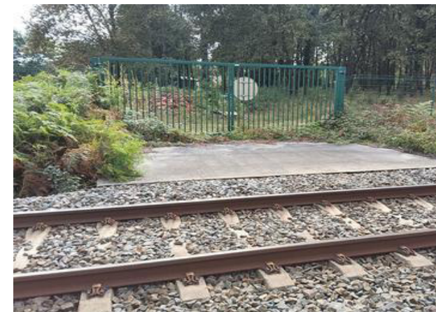
Portail en bon état
